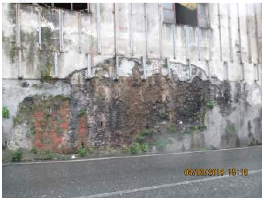
Foto 8: dettaglio del muro perimetrale dell'edificio lungo il primo rettilineo
