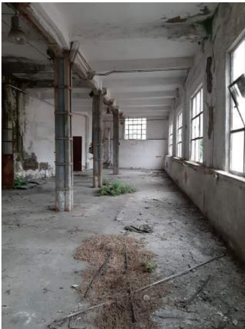
Foto 5 – interno edificio uffici, piano terra
