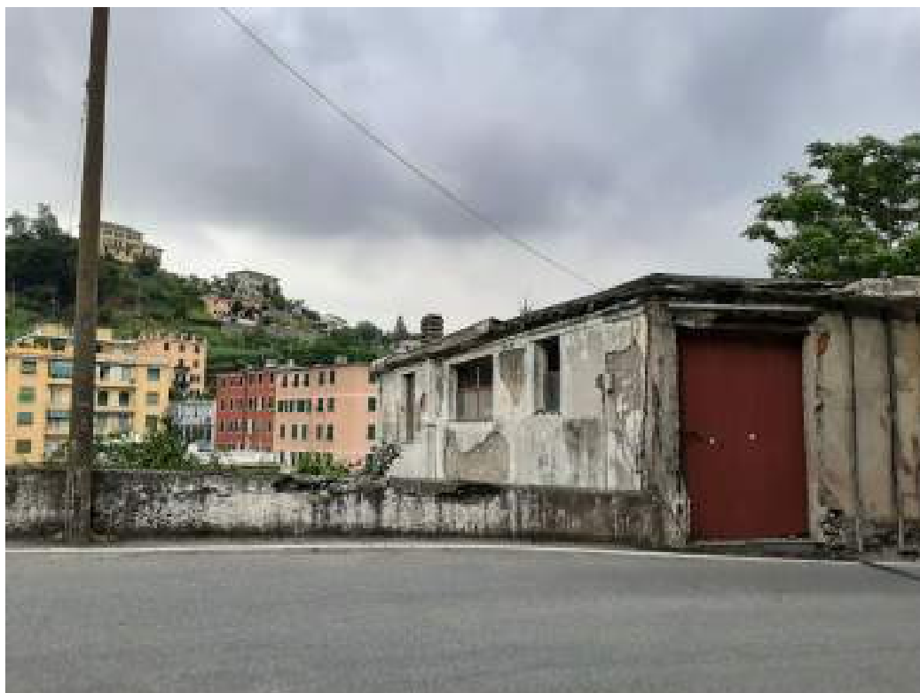
Foto 1 – ingresso agli uffici dal primo piano
