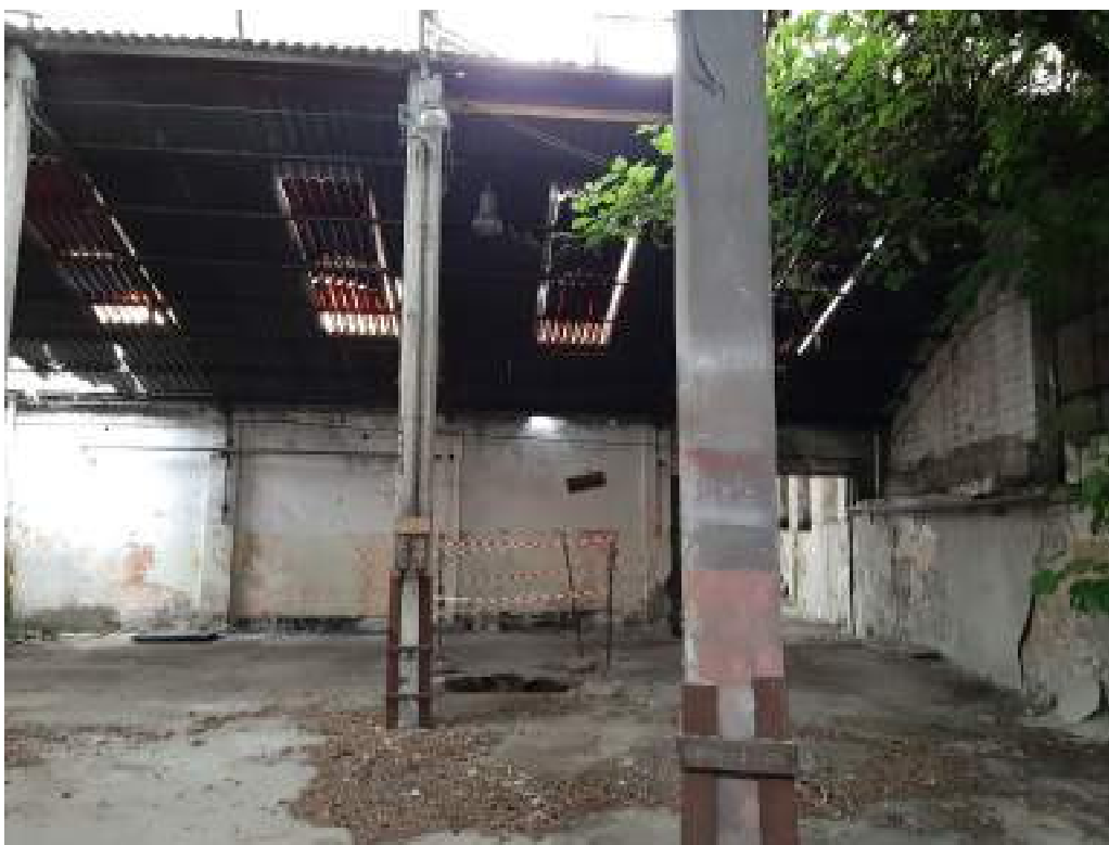
Foto 2 – interno del capannone 2
