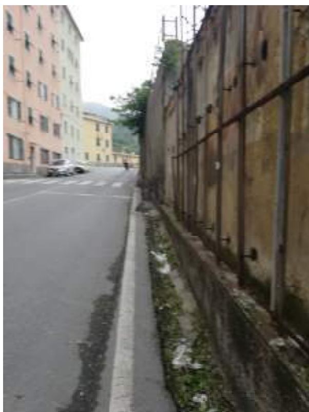
Foto 9: vista del muro perimetrale dell'edificio lungo il secondo rettilineo
