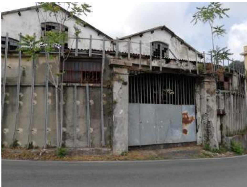
Foto 7 – accesso carrabile e pedonale a capannone 1
