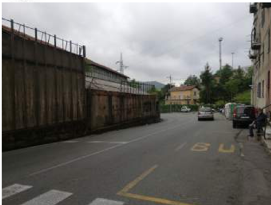
Foto 10: vista del muro perimetrale dell'edificio lungo il secondo rettilineo
