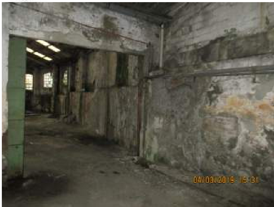
Foto 20: vista interna al capannone del muro interno lungo il secondo rettilineo
