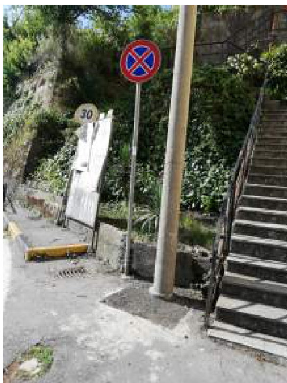
Foto 41: vista di dettaglio della base della scalinata in corrispondenza del primo tornante
