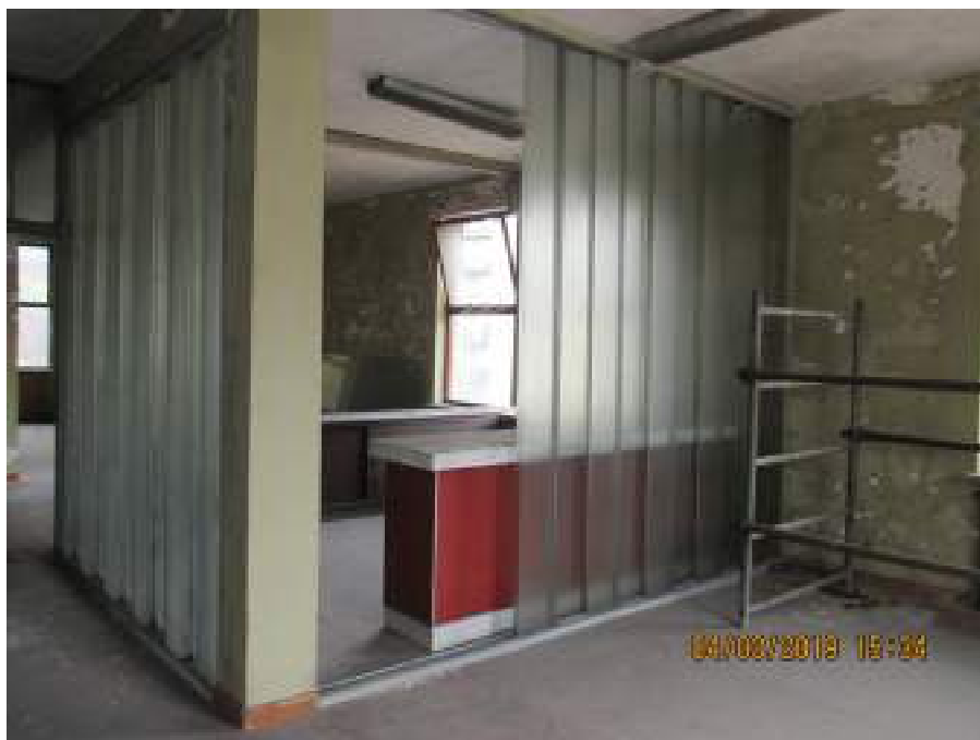
Foto 24: vista degli uffici al primo piano
