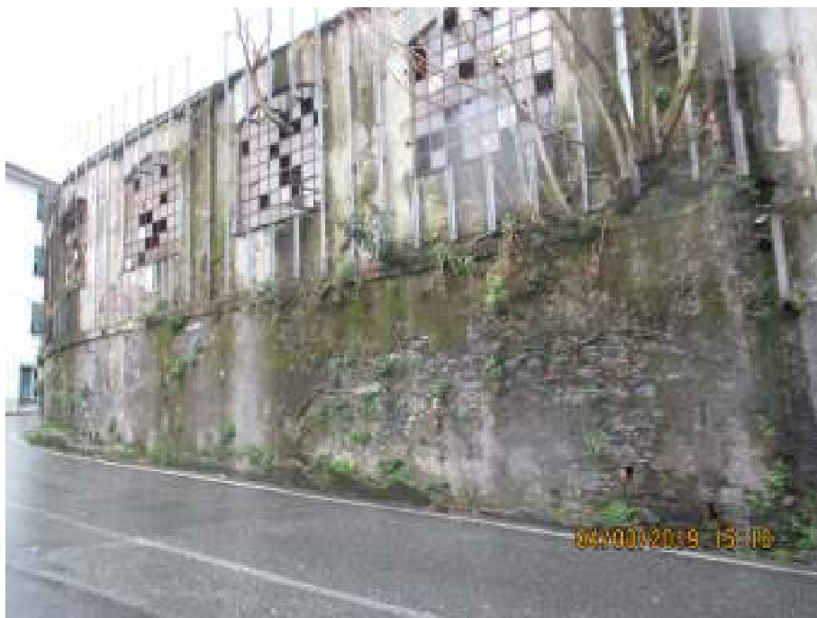
Foto 8: vista del muro perimetrale dell'edificio all'imbocco del secondo tornante
