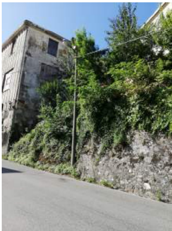
Foto 39: vista del muro di sostegno dell'area verde
