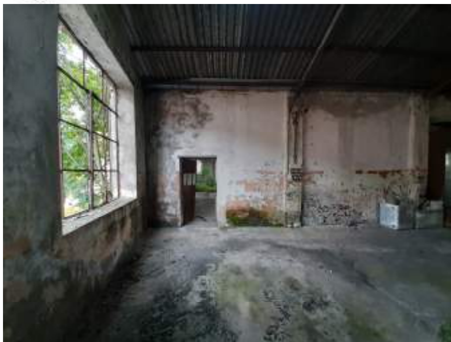
Foto 14: vista degli accessi interni alla zona denominata “Capannone 2”
