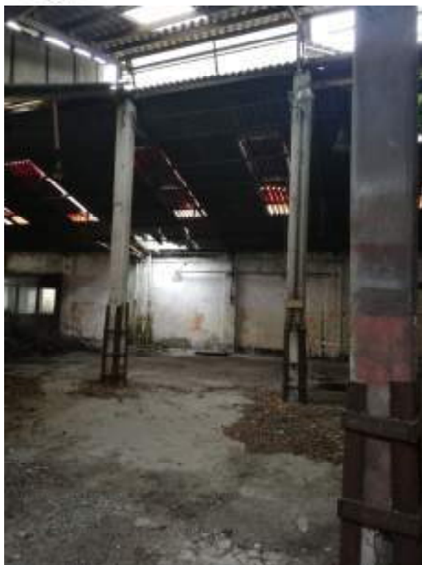
Foto 16: vista della zona denominata “Capannone 2”
