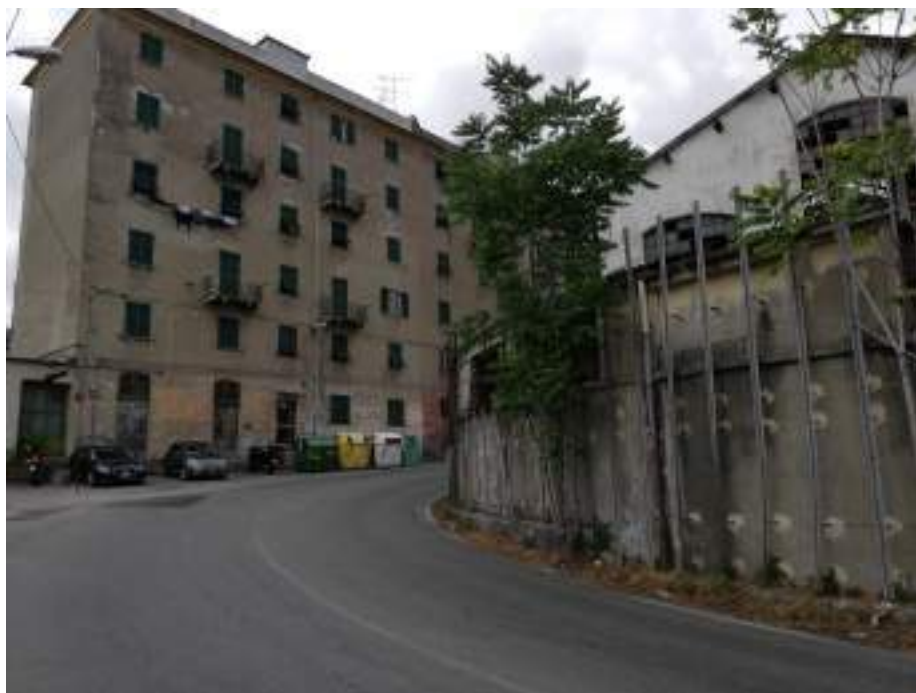
Foto 3: vista del muro perimetrale dell'edificio lungo il secondo tornante in direzione monte
