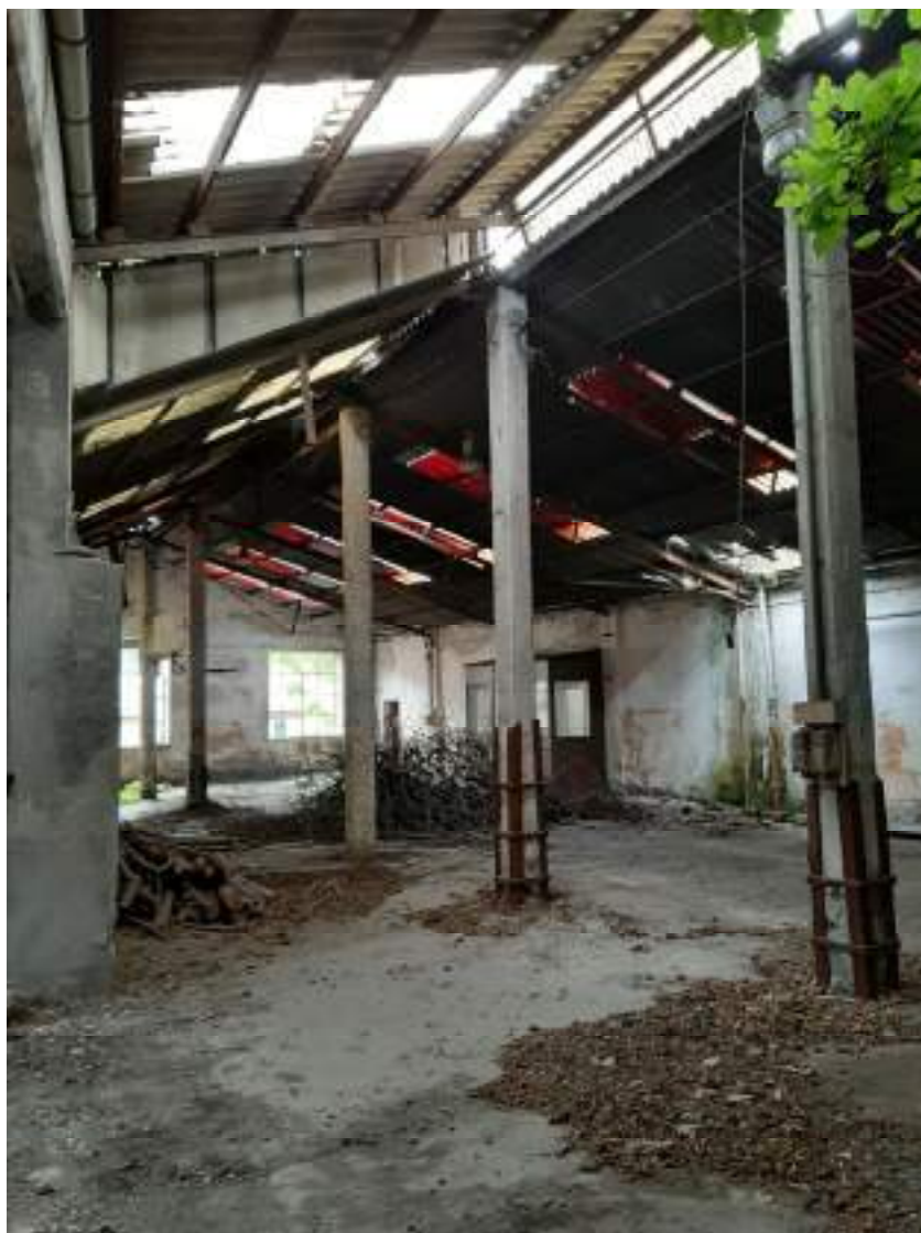
Foto 3 – interno del capannone 2.
