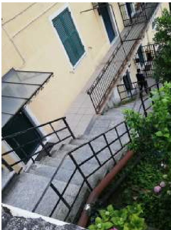
Foto 5 – scala collegamento pedonale
