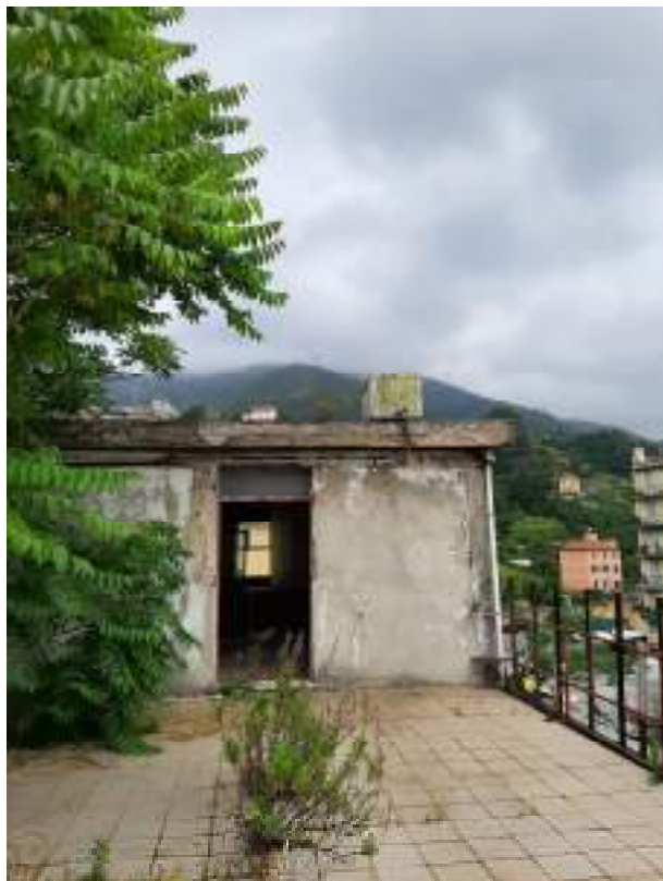
Foto 26: vista del terrazzo al primo piano
