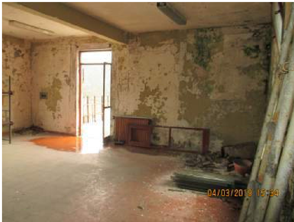
Foto 8 – interno degli uffici, primo piano
