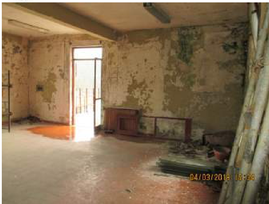
Foto 24: vista degli uffici al primo piano
