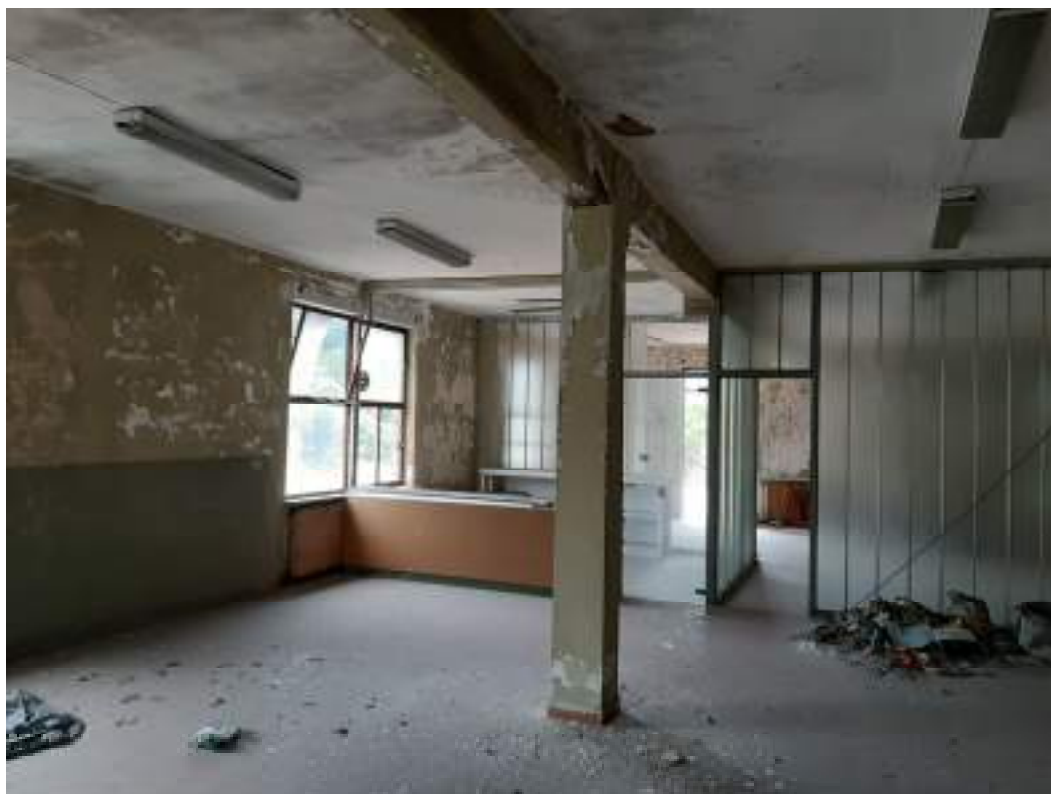
Foto 7 – interno degli uffici, primo piano
