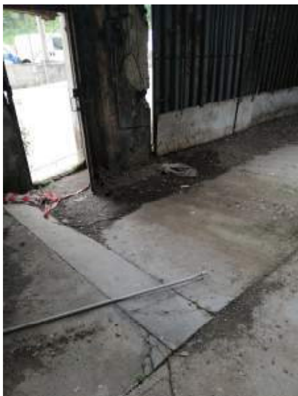
Foto 6: dettaglio del portone di accesso carrabile e pedonale dall'interno dell'edificio
