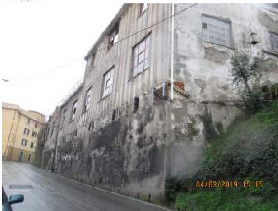
Foto 7: vista del muro perimetrale dell'edificio lungo il primo rettilineo
