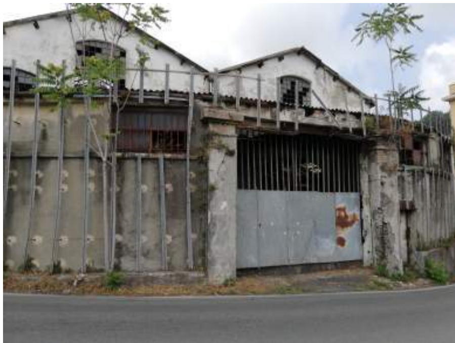
Foto 1: vista frontale del portone di accesso su Via Borzoli
