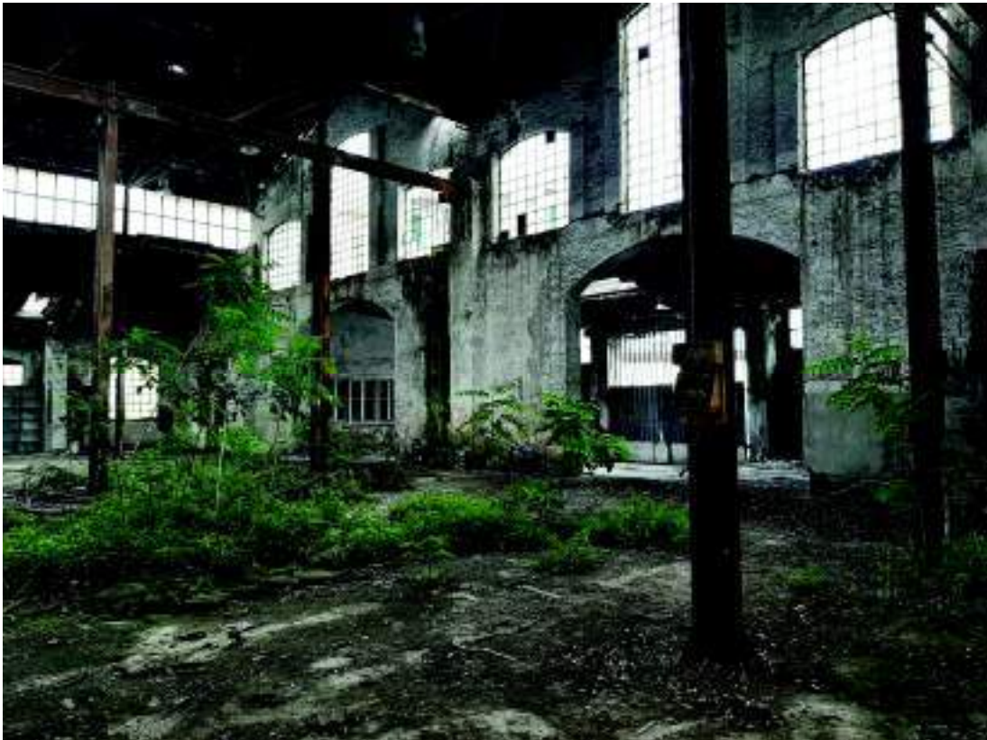
Figura 3. Controfacciata del prospetto anteriore ripresa dall'interno
