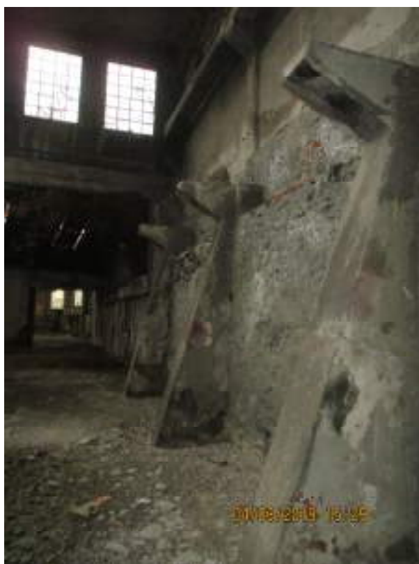
Foto 19: vista interna al capannone del muro interno lungo il secondo rettilineo
