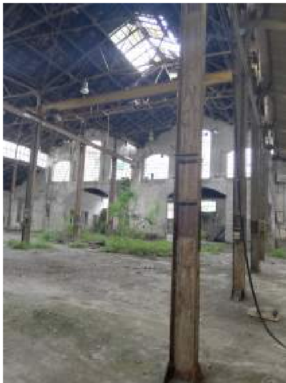
Foto 12: vista interna del volume principale dell'edificio
