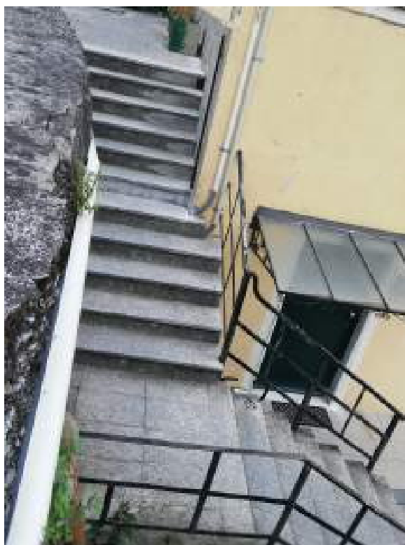
Foto 4 – scala collegamento pedonale
