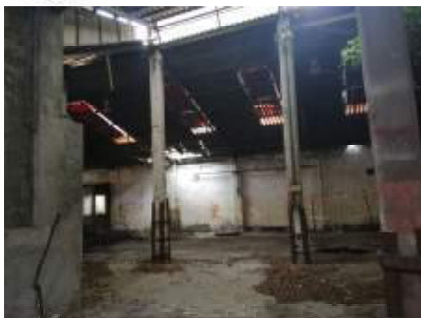
Foto 18: vista della zona denominata “Capannone 2”
