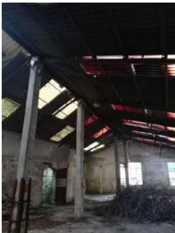
Foto 17: vista della zona denominata “Capannone 2”
