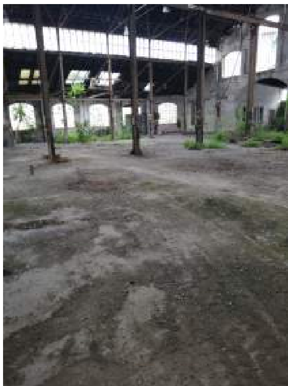
Foto 13: vista della zona denominata “Capannone 1”
