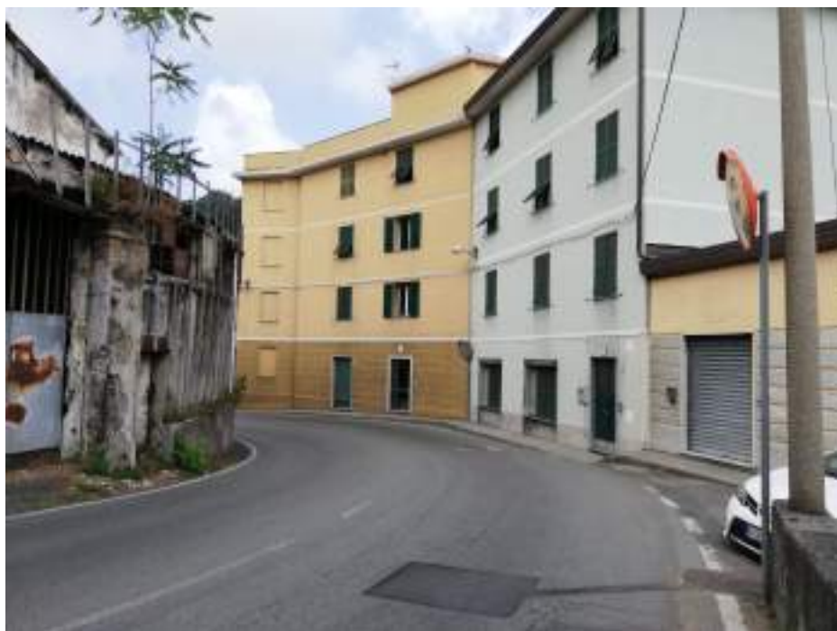
Foto 4: vista del muro perimetrale dell'edificio lungo il secondo tornante in direzione valle
