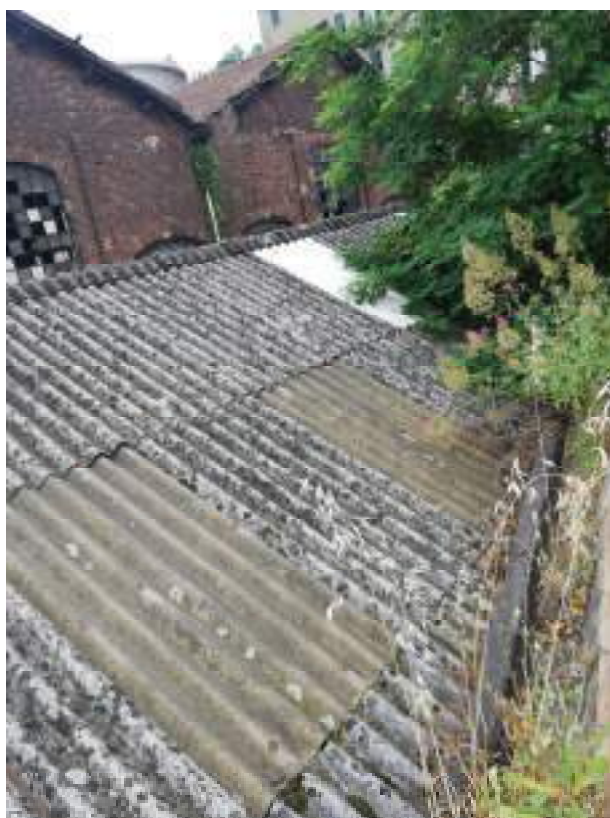
Foto 28: vista della copertura della zona del Capannone 2
