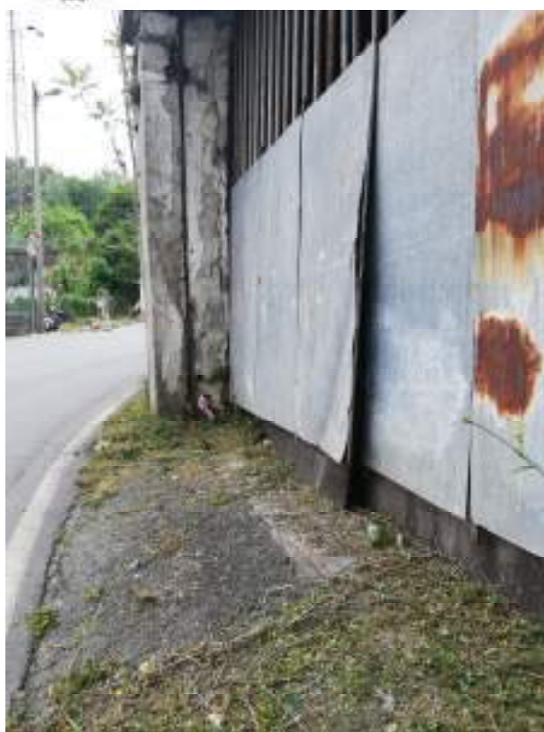
Foto 5: dettaglio del portone di accesso su Via Borzoli
