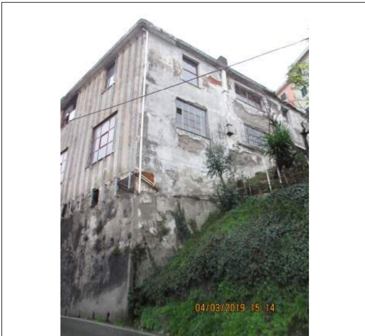
Foto 4 – l'edificio degli uffici visto da via Borzoli, nei pressi del rio Fegino
