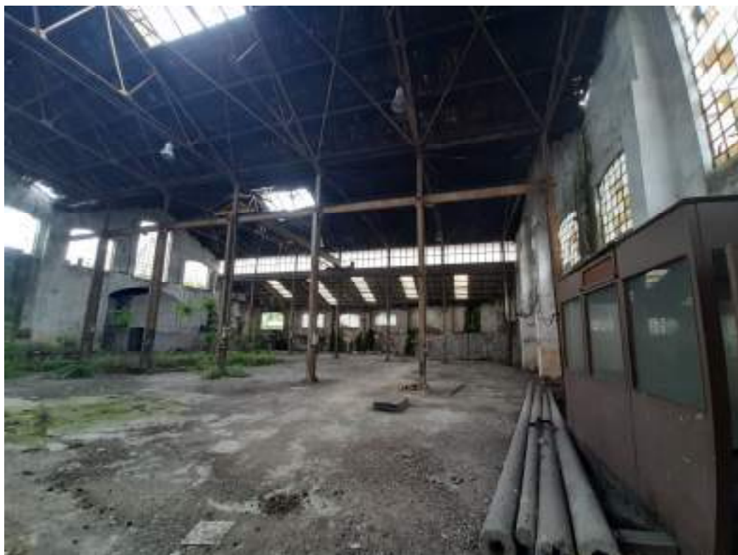
Foto 3 – interno del capannone 1.
