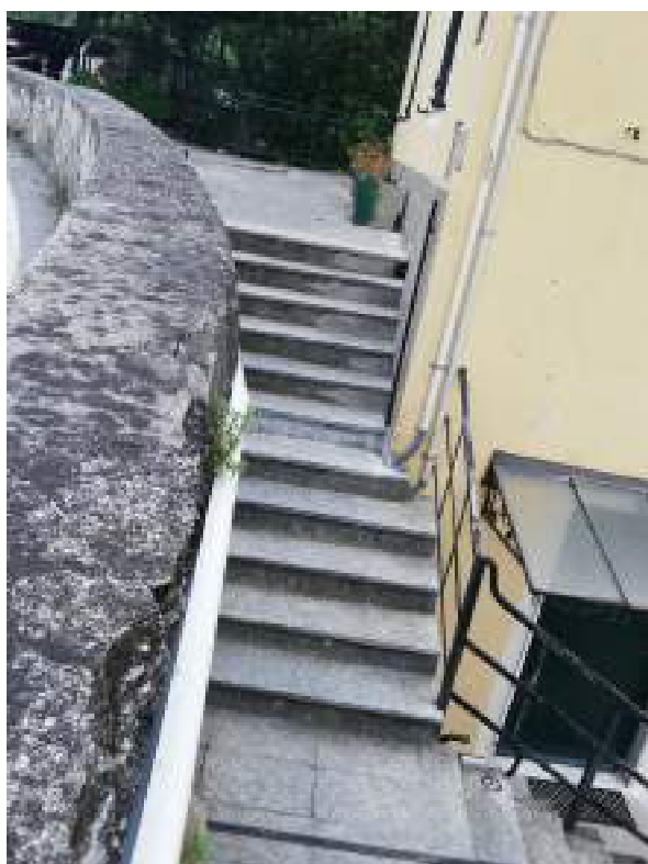
Foto 43: vista di dettaglio della scalinata in corrispondenza del terzo tornante
