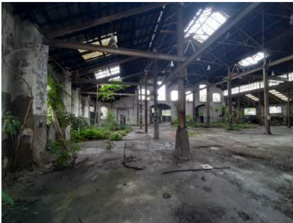
Foto 2 – interno del capannone 1
