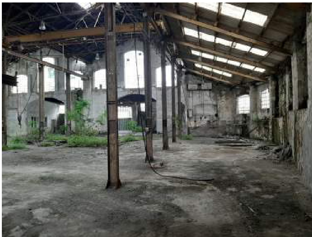
Foto 1 – interno del capannone 1
