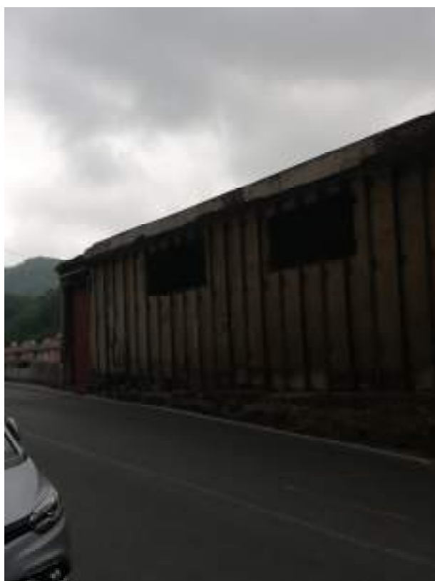
Foto 11: dettaglio del muro perimetrale dell'edificio lungo il secondo rettilineo
