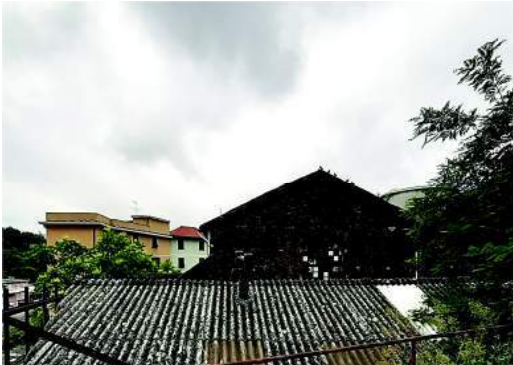
Figura 5. Vista del prospetto posteriore in muratura di mattoni facciavista
