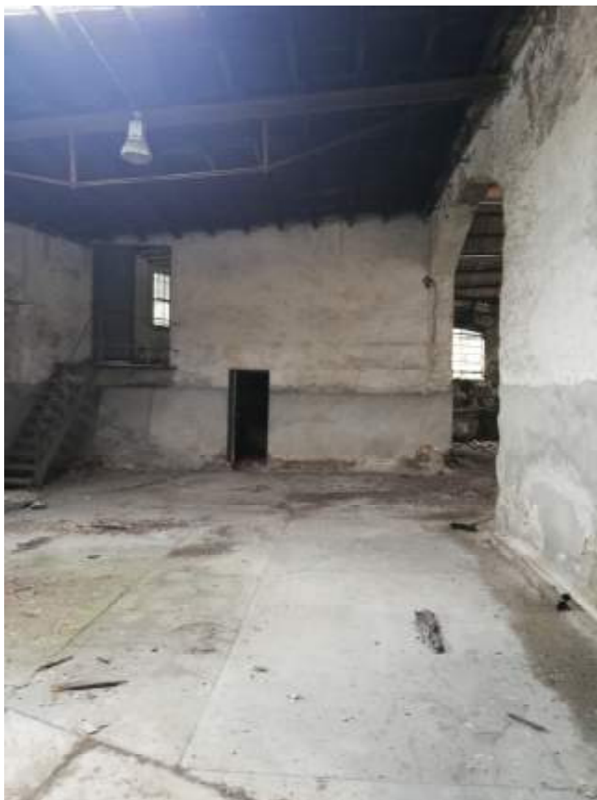
Foto 5 – zona di accesso
