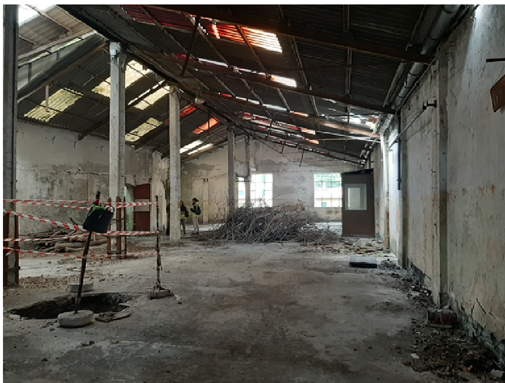
Foto 1 – interno del capannone 2
