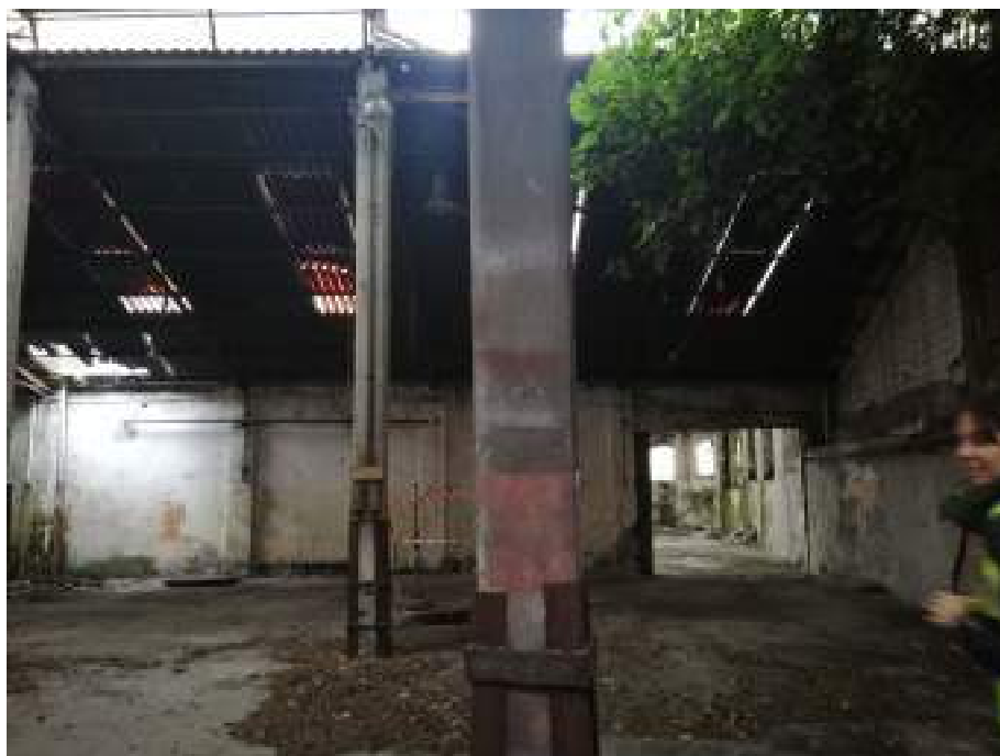
Foto 15: vista degli accessi interni alla zona denominata “Capannone 2”
