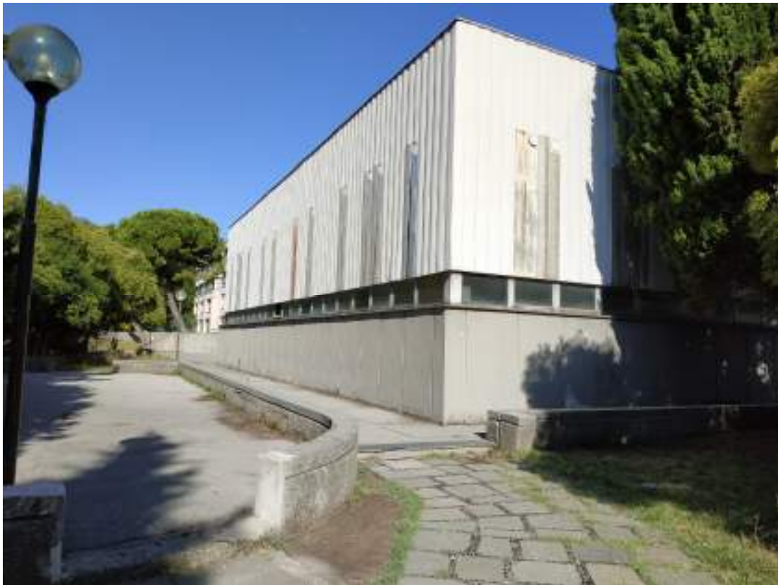
Figura 5. Vista del gradino in corrispondenza della palestra con realizzazione di piccola rampa per abbattimento barriere
