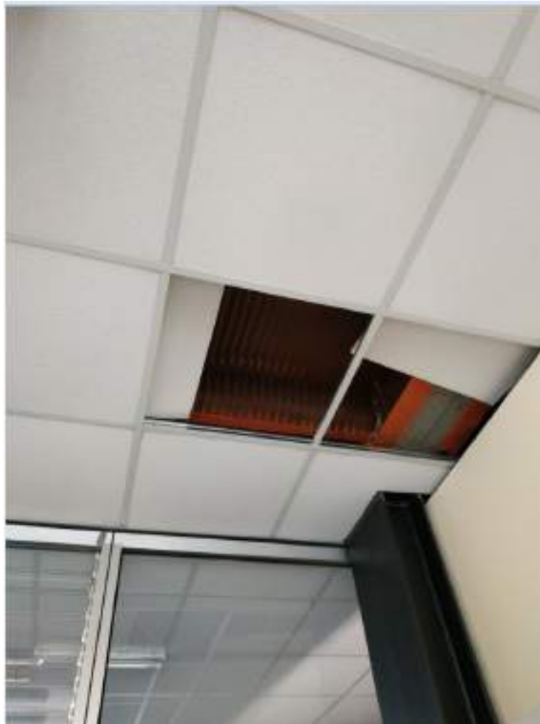
Figura 2. Particolare del saggio interno a soffitto piano primo aula adiacente zona dove sarà inserita nuova piattaforma elevatrice per verifica orientamento travetti solaio
