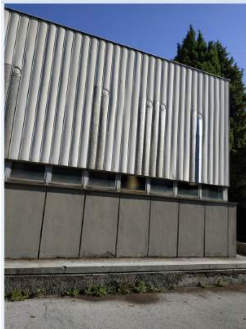
Figura 6. Vista della facciata palestra dove è previsto inserimento di una uscita di sicurezza palestra
