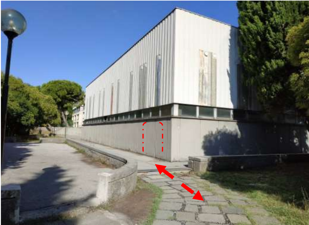
Foto 6: Foto percorso di accesso e palestra – differenza di quota da adeguare e nuova porta palestra
