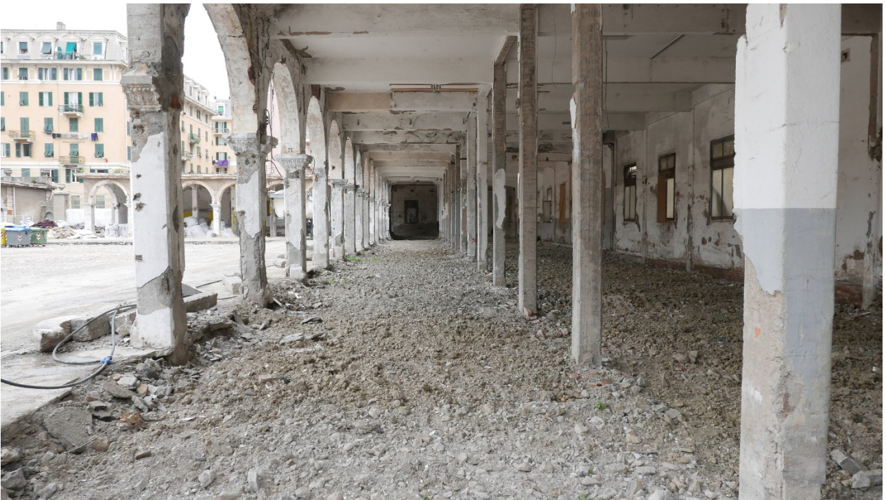
Foto del cantiere in corso
