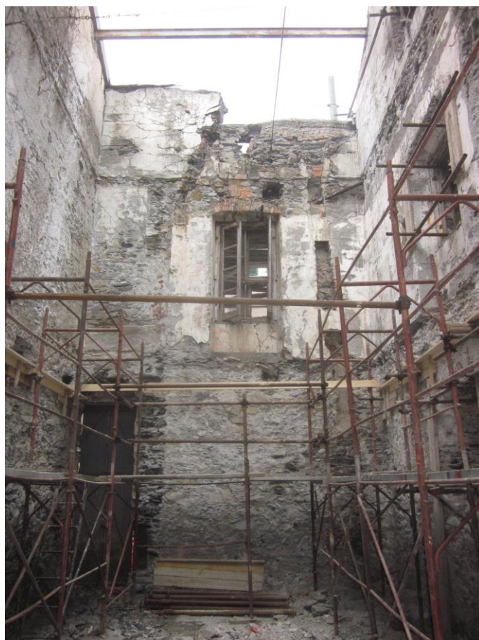
Fig.3) corpo Est controfacciata lato Nord – le bucatore inizialmente non rilevate sono state tamponate per motivi di consolidamento – aspetto già autorizzato in variante n.1
