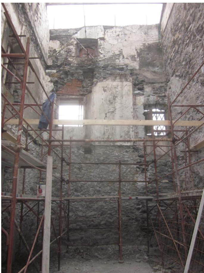
Fig.2) corpo Est controfacciata lato Sud – le bucatore inizialmente non rilevate presentano finestre a due ante in legno
