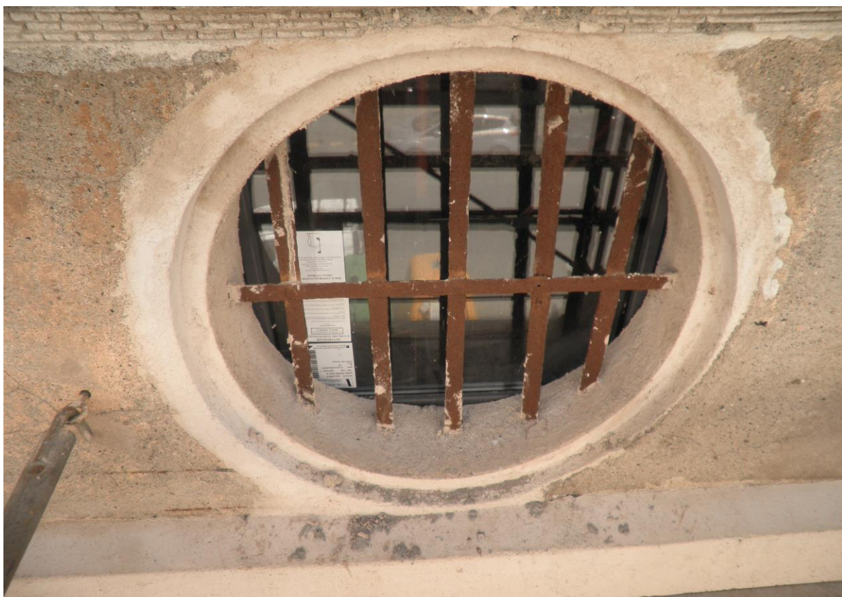
Fig.8) campione di serramento con telaio in alluminio in opera
