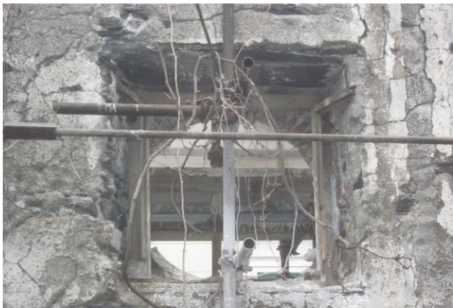
Fig.4) corpo Est controfacciata lato Est – oculo con serramento ad una anta a battente
