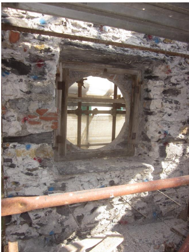
Fig.4) corpo Est controfacciata lato Est – oculo con serramento ad una anta a battente
