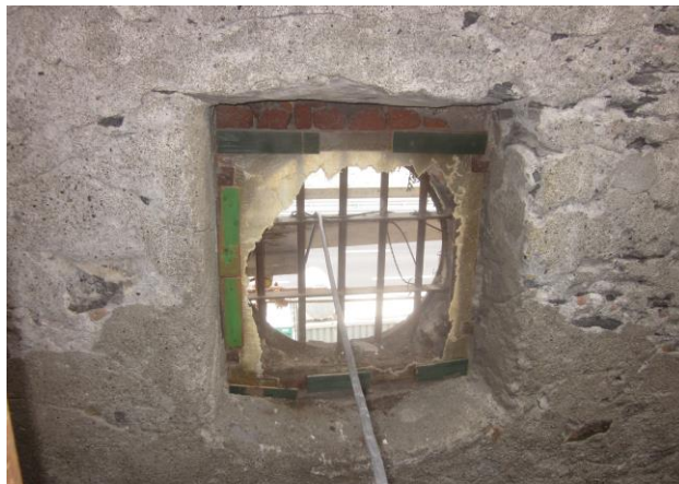
Fig.5) controfacciata vano magazzino – oculo privo di serramento
