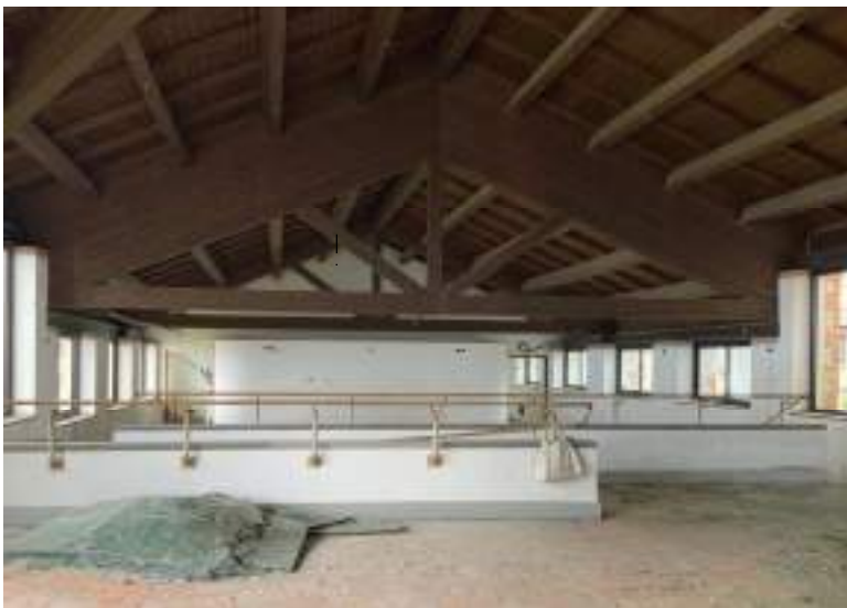
Fotogramma 7) Dettaglio capriata in legno lamellare piano secondo caserma principale
