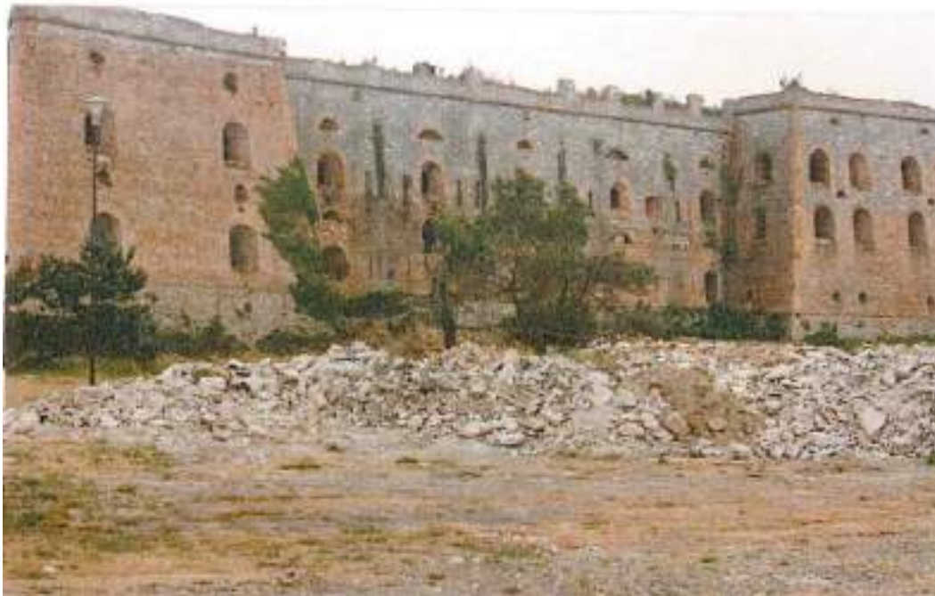
Fotogramma 1) Il forte in Luglio 1993 prima dei lavori di recupero risalenti agli anni 1995/1998
