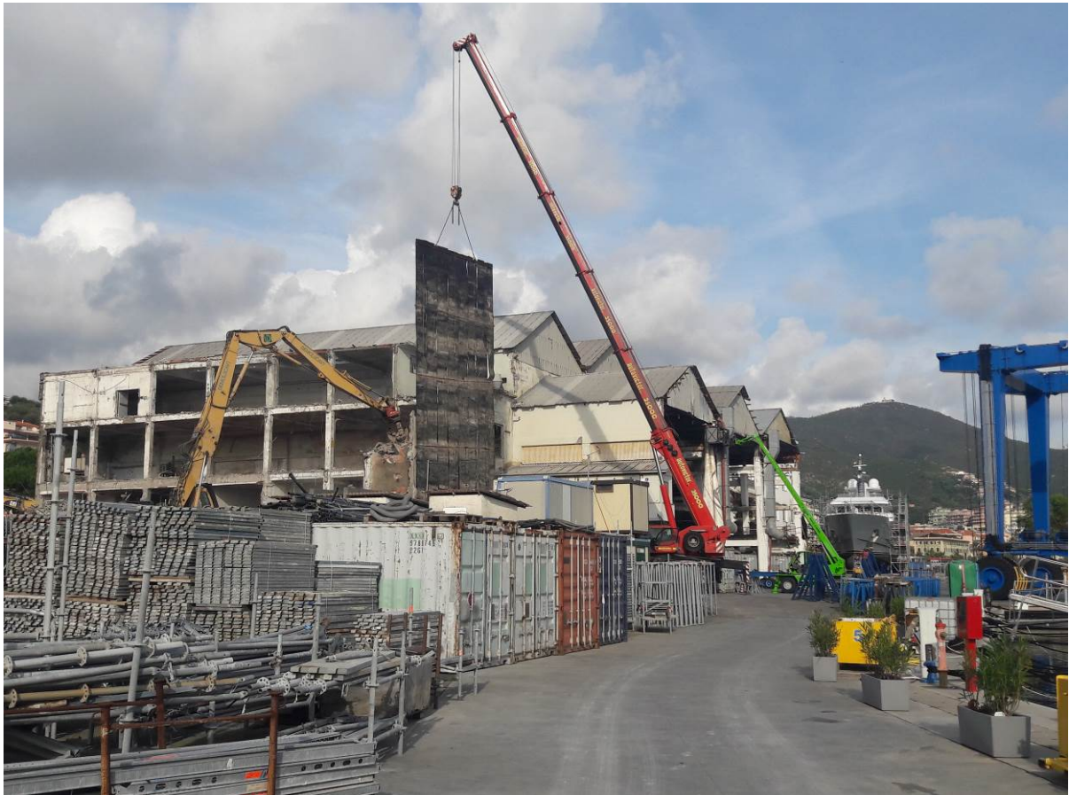
Figura 16: Pannello di protezione in fase di demolizione
