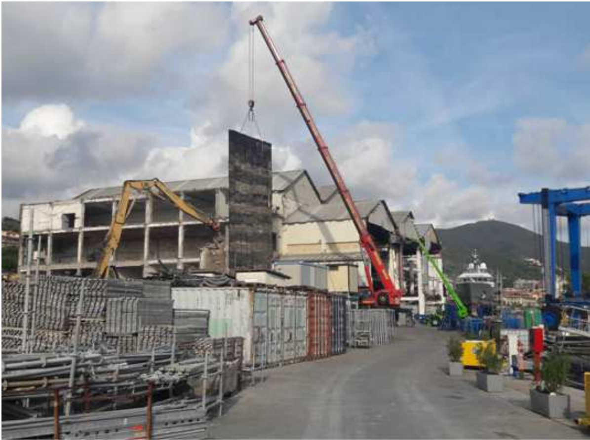
Figura 1: Pannello di protezione in fase di demolizione
