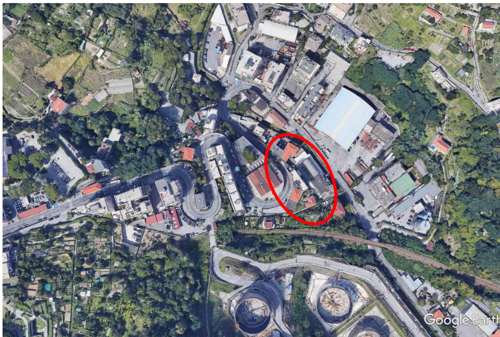
Figura 5: Localizzazione dei tornanti su via Borzoli
