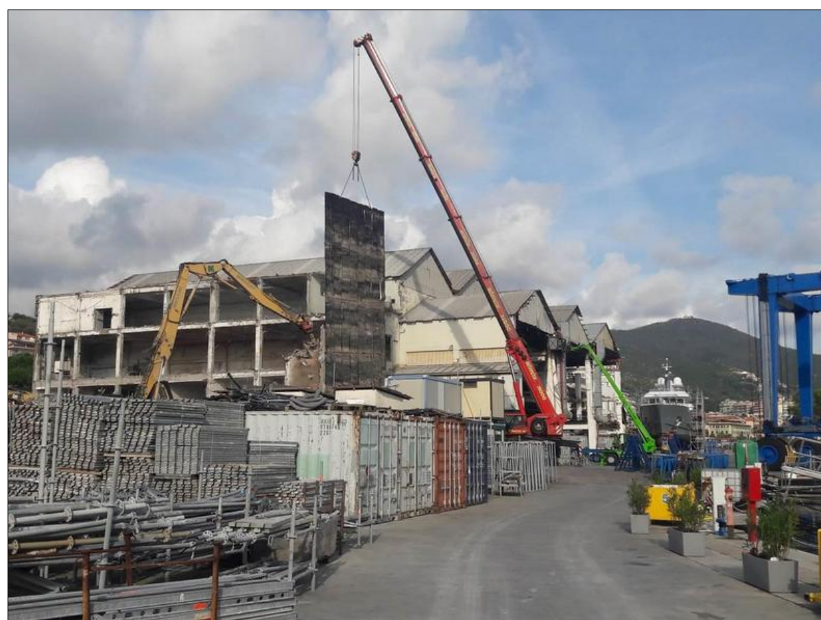
PROTEZIONE DELL'AMBIENTE CIRCOSTANZE DAI PROIETTI DOVUTI ALLE DEMOLIZIONI: LA PANNELLATURA MOBILE, SORRETTA DA UN'AUTOGRU, PERMETTERA' DI CONVOGLIARE I DETRITI AL PIEDE DELL'AREA DI DEMOLIZIONE.
