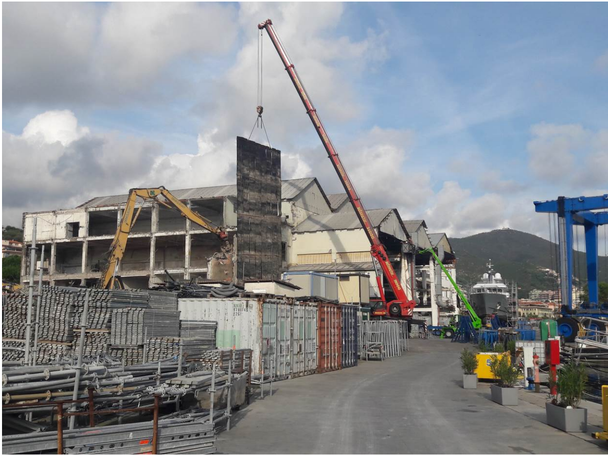
Figura 16: Pannello di protezione in fase di demolizione
