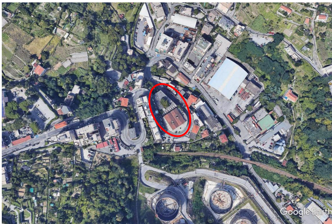
Figura 2: Localizzazione dei tornanti su via Borzoli
