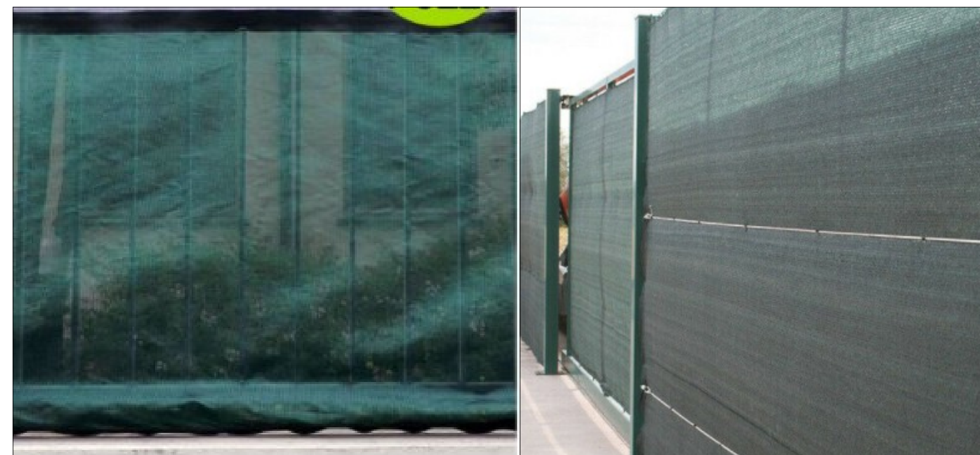
PERCORSO PEDONALE: PROTEZIONE CON PANNELLI GRIGLIATI TIPO ORSOGRILL, POSTI SU BASETTE DI CEMENTO COPERTI DA RETE FRANGIVISTA (O, IN ALTERNATIVA, RETE FRANGIVENTO) LARGHEZZA PERCORSO min. 150 cm
