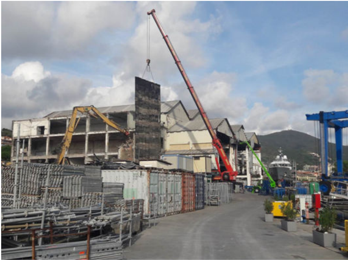
Figura 1: Pannello di protezione in fase di demolizione
