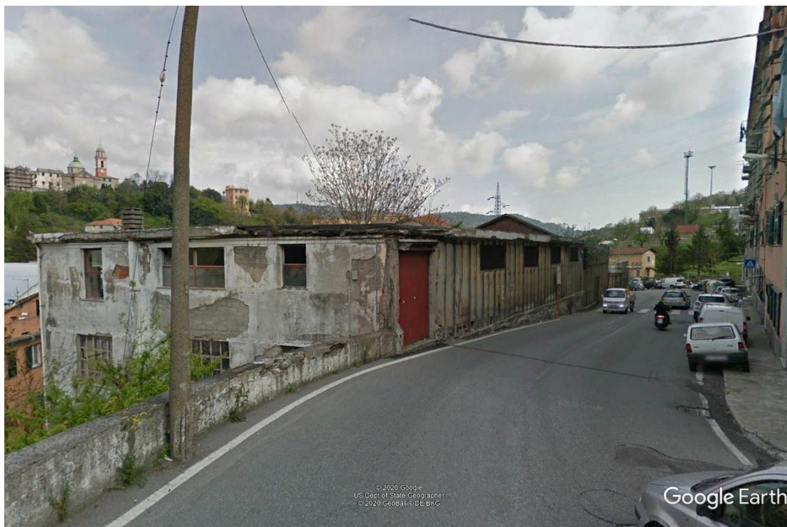
Figura 9: Vista da via Borzoli, lato superiore
