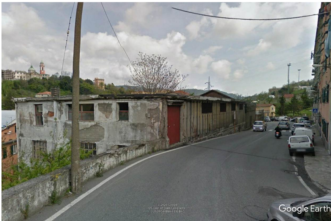
Figura 9: Vista da via Borzoli, lato superiore
