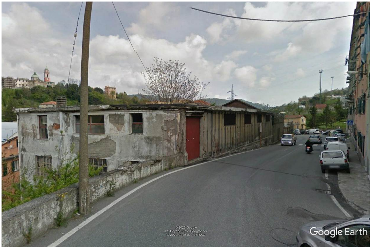
Figura 6: Vista da via Borzoli, lato superiore
