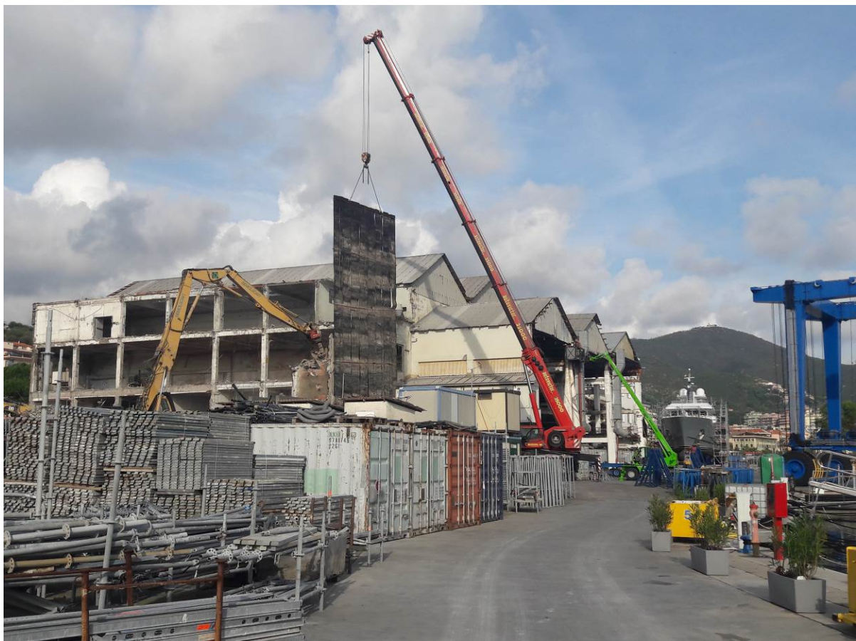
Figura 13: Pannello di protezione in fase di demolizione
