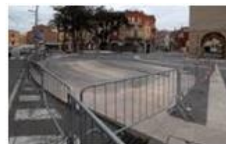
RIMOZIONE AREA DI CANTIERE
