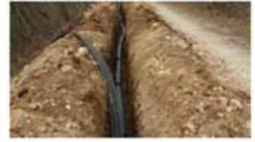
POSA TUBAZIONI, INFILAGGIO CAVI E RINTERRI
