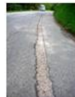
LAVORI AL MANTO STRADALE
