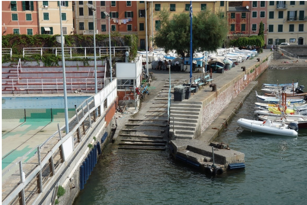
Figura 5 Banchina esistente lato ponente e parete piscine esistente
