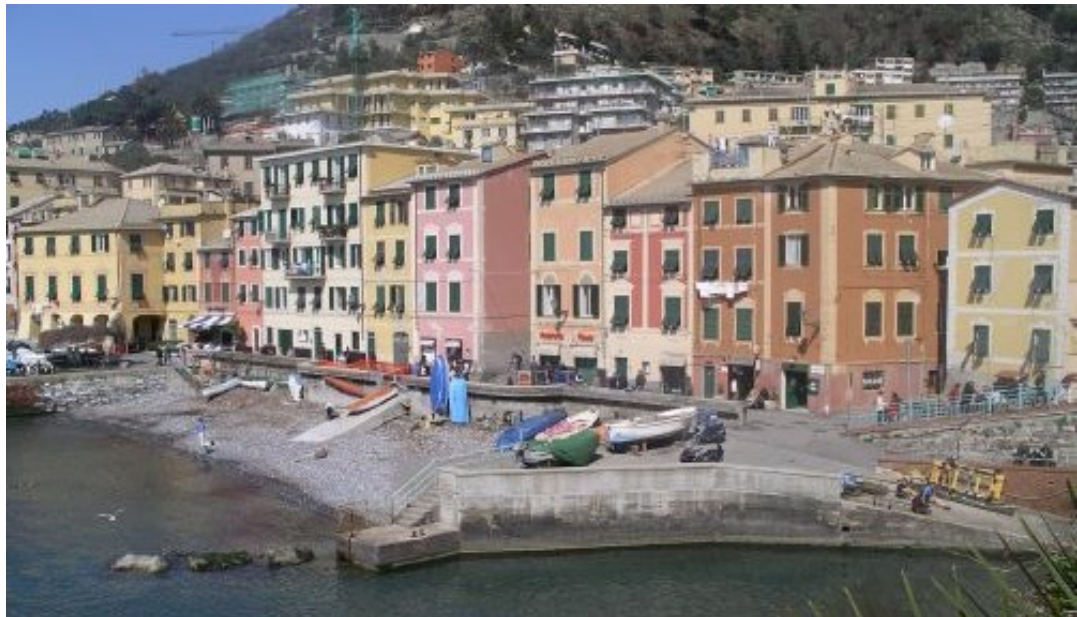
Figura 6 Pennello lato levante allo sbocco del torrente Nervi
