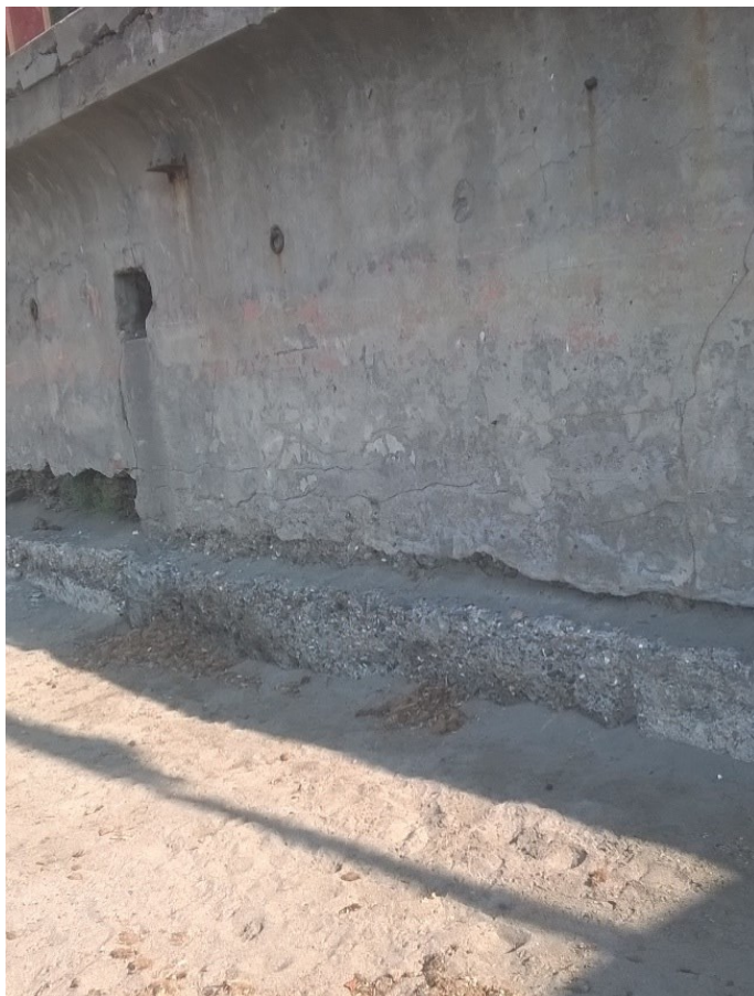
Figura 7 Piede del muro di sostegno della strada Via Caboto
