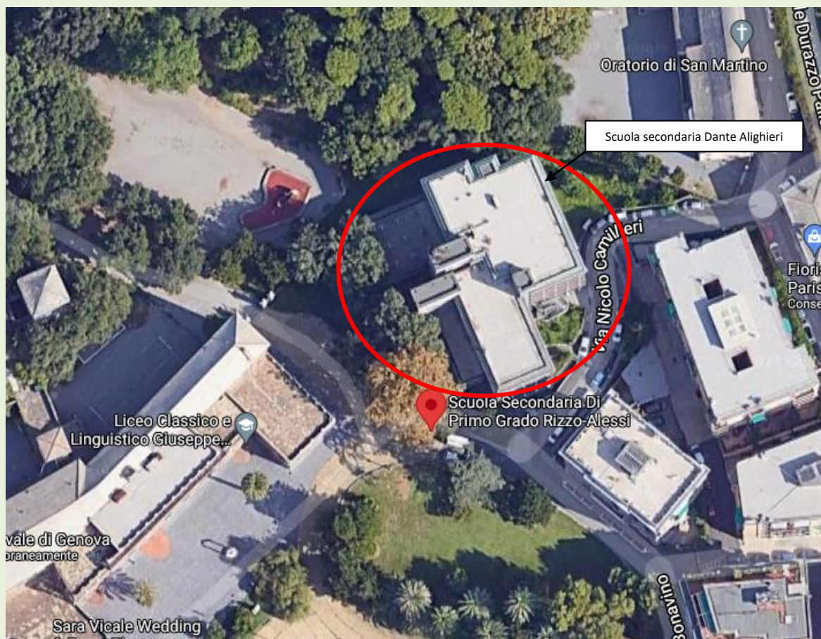
Orto foto dell'edificio oggetto di intervento
