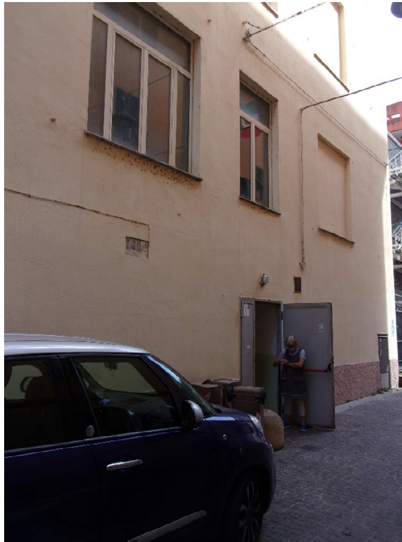
Foto 3 – Uscita sicurezza n.1/accesso disabili su via Gianuè
