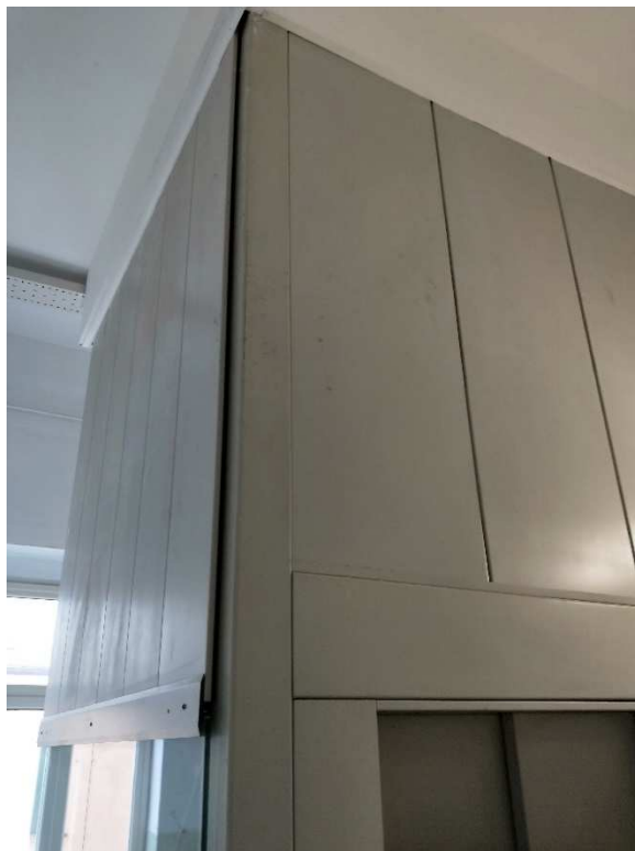
Foto 13 –Parte terminale vano ascensore (P.3°)
