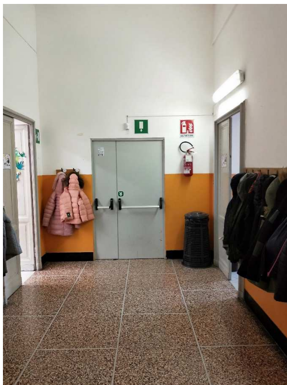
Foto 11 – Accesso al filtro della scala a prova di fumo (piano 3°)
