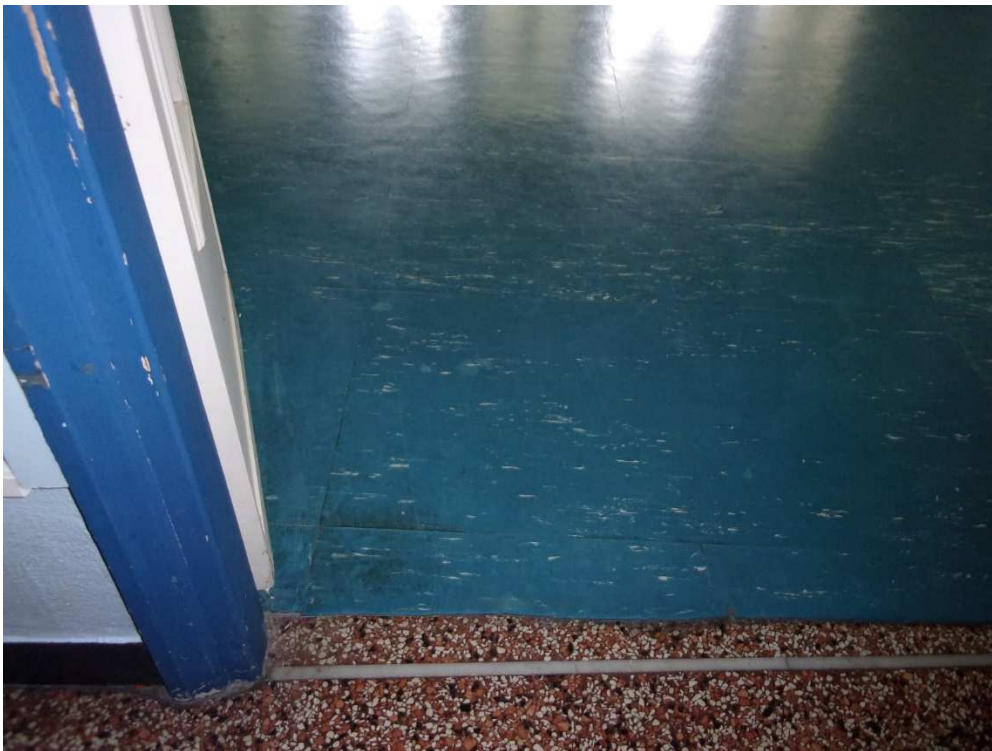
Foto 16 –Pavimentazione aula sostegno (piano 3°)
