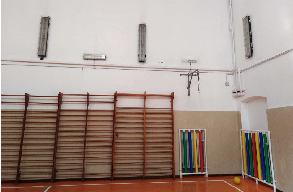
Figura 3. Zona di muratura interessata dall'intervento di apertura nuovo varco - lato palestra
