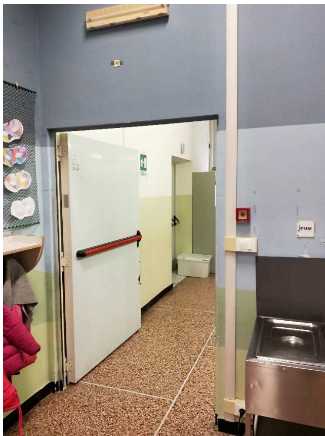
Foto 9 – Accesso al filtro della scala a prova di fumo (piano 1°)
