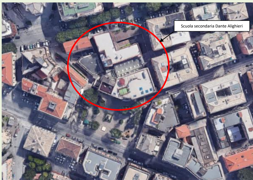
Orto foto dell'edificio oggetto di intervento
