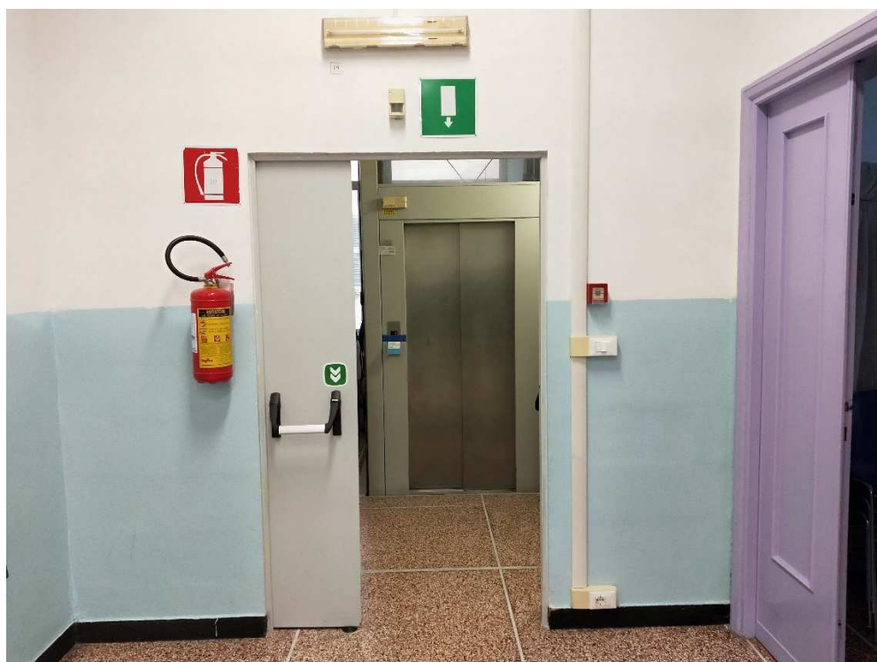
Foto 8 – Accesso al filtro della scala a prova di fumo (piano terra)
