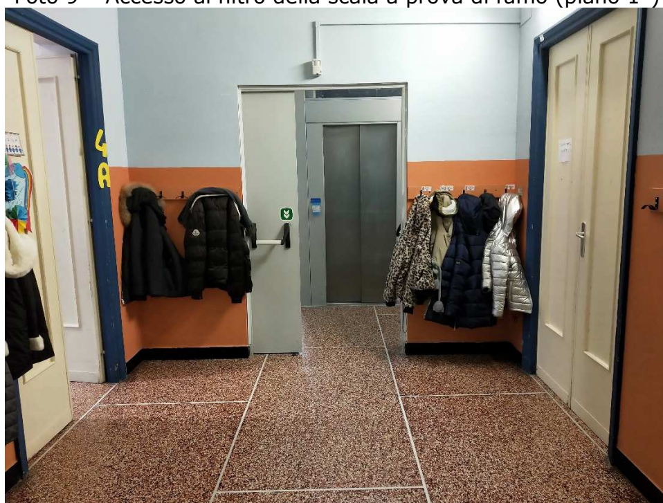
Foto 10 – Accesso al filtro della scala a prova di fumo (piano 2°)
