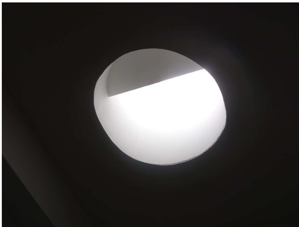
Foto 7 – Cupolino fisso di illuminazione disimpegno tra le due palestre (piano seminterrato)
