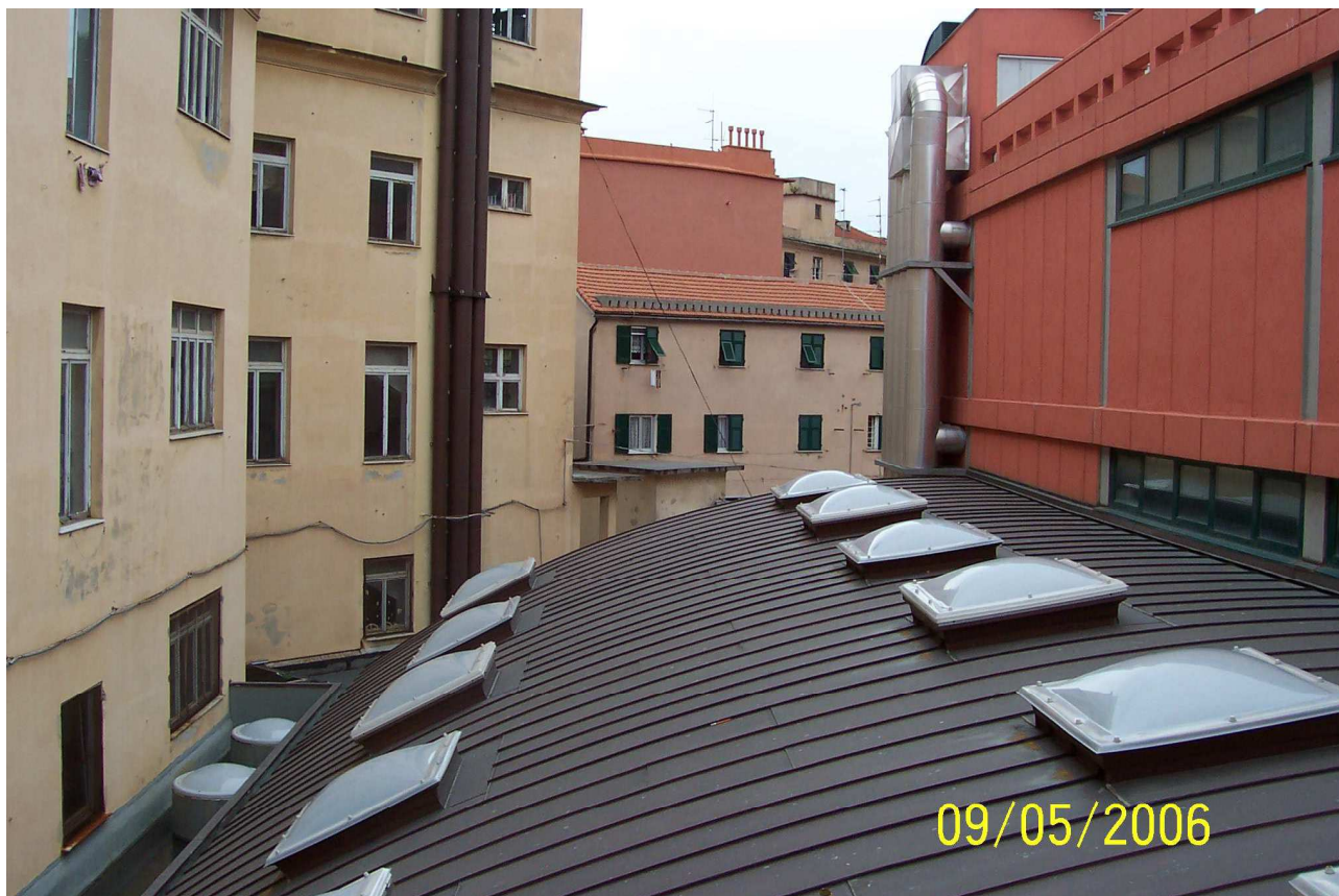
Figura 6. Lucernai circolari presenti sulla porzione di copertura piana (a sinistra della foto)
