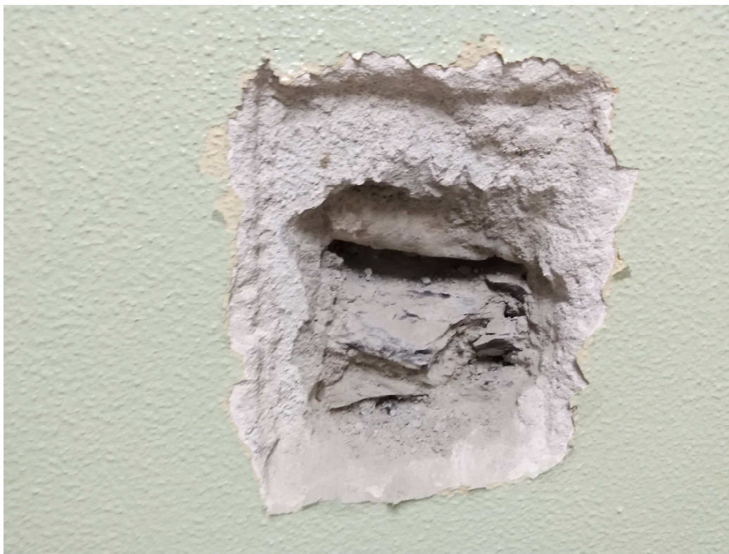
Figura 4. Dettaglio saggio eseguito nella muratura – lato corridoio
