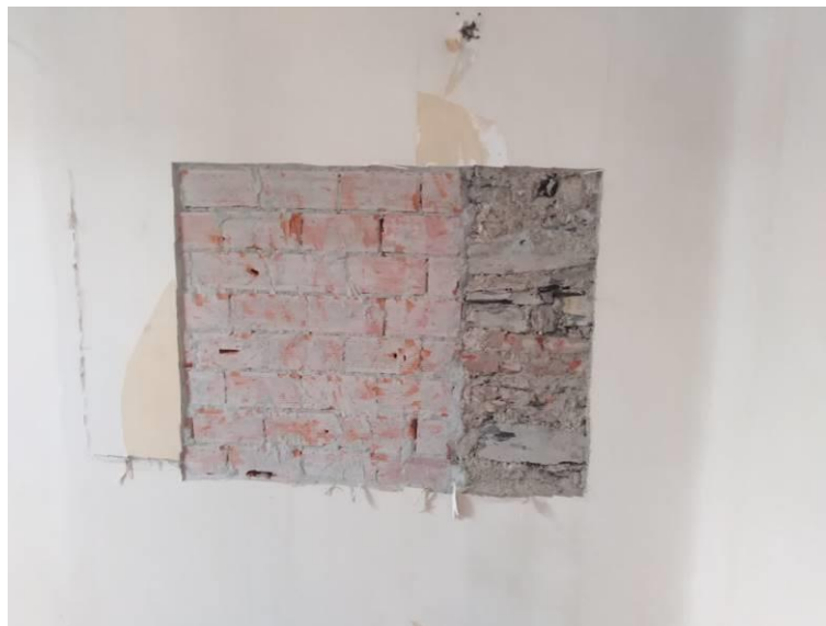
Muratura portante primo piano zona primo varco
