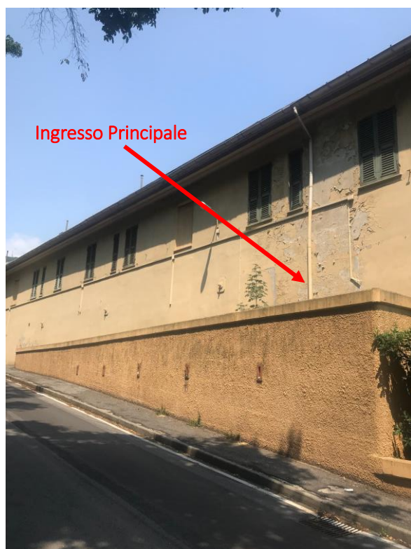
Foto 7 Prospetto Ovest con rampa disabili
