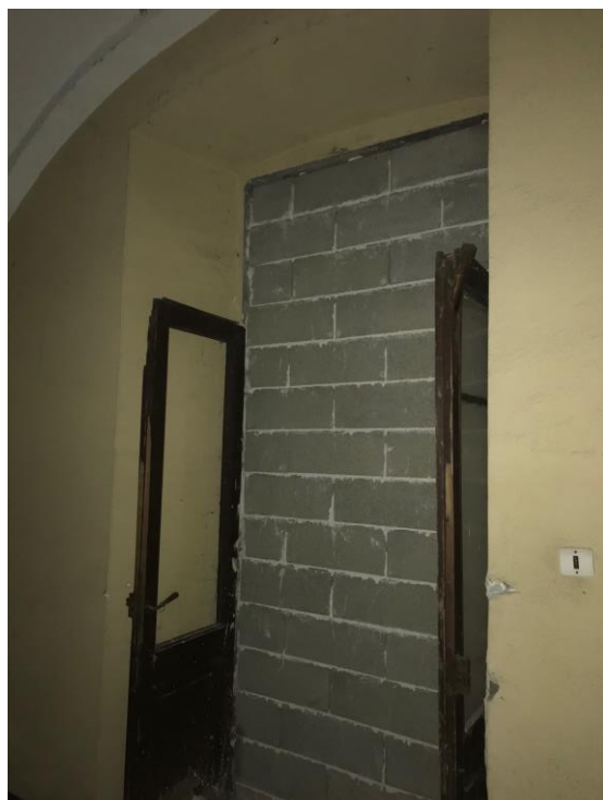
Foto 19 Accesso principale Scuola da rimuovere tamponamento
