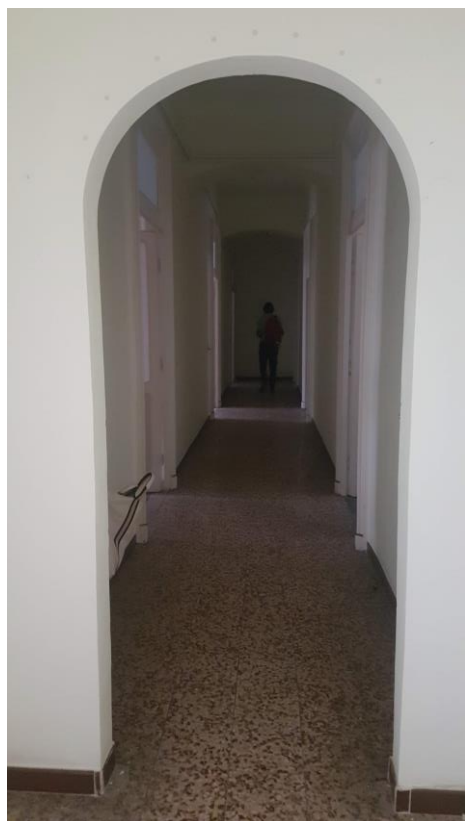
Foto 11 Accesso al corridoio
