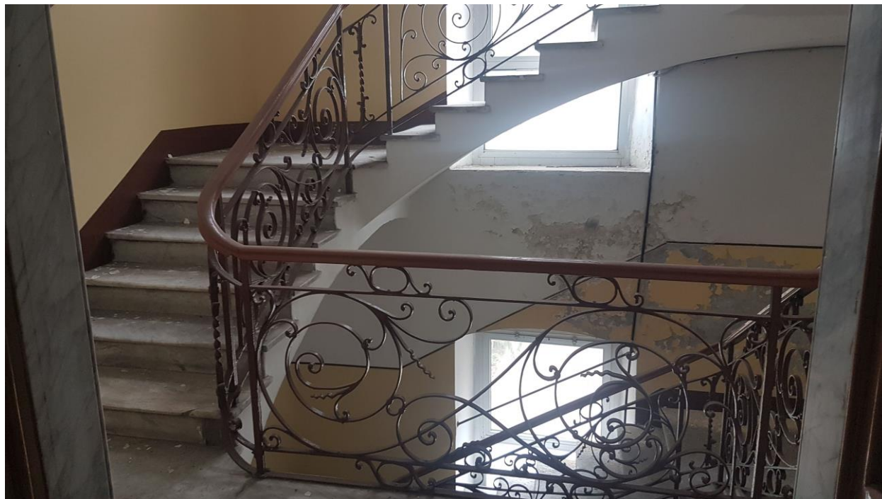
Foto 8 Vano scala di emergenza da adeguare
