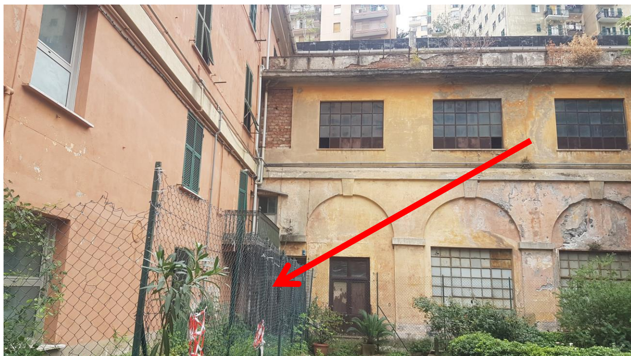
Foto 4 Angolo Sud-ovest con individuazione dell'accesso riservato al cortile interno
