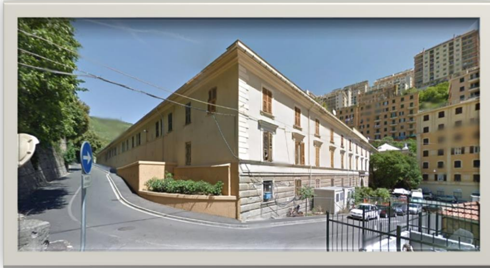
Vista lato sud-ovest sulla via Lagaccio (presenza linee aeree sull'angolo sud-ovest e notevole dislivello strada)
