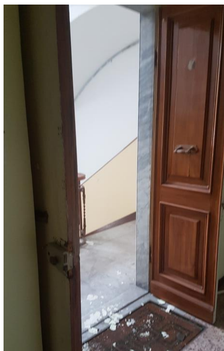
Foto 10 Porta di accesso al vano scala dal piano 3° F.
