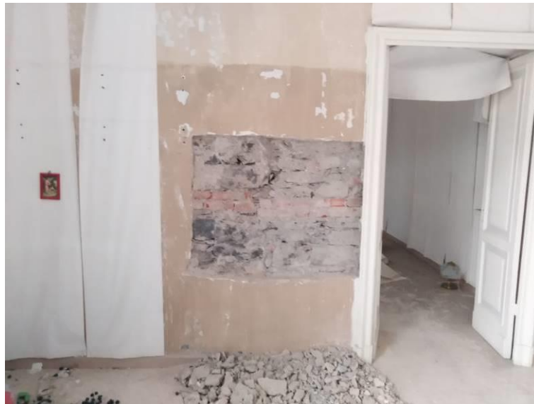
Muratura portante primo piano zona secondo varco
