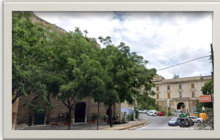
Vista lato sud con ingresso e resedi chiesa limitrofa (presenza linee aeree e piante ad alto fusto)
