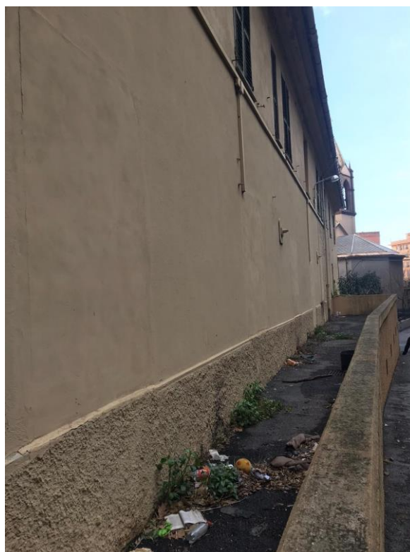
Foto 8 Rampa disabili di accesso in quota al piano 3° f.t.
