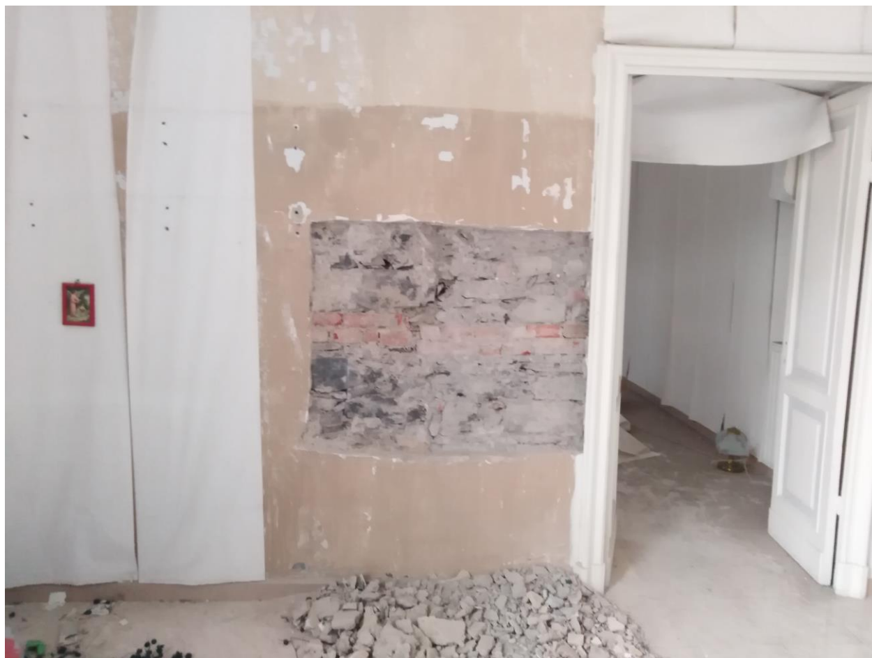
Foto 16 Parete interessata da ampliamento di varco per realizzare un'aula più ampia
