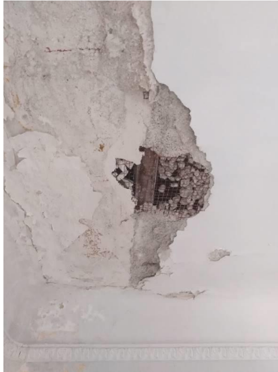
Tipologia controsoffitto secondo piano
