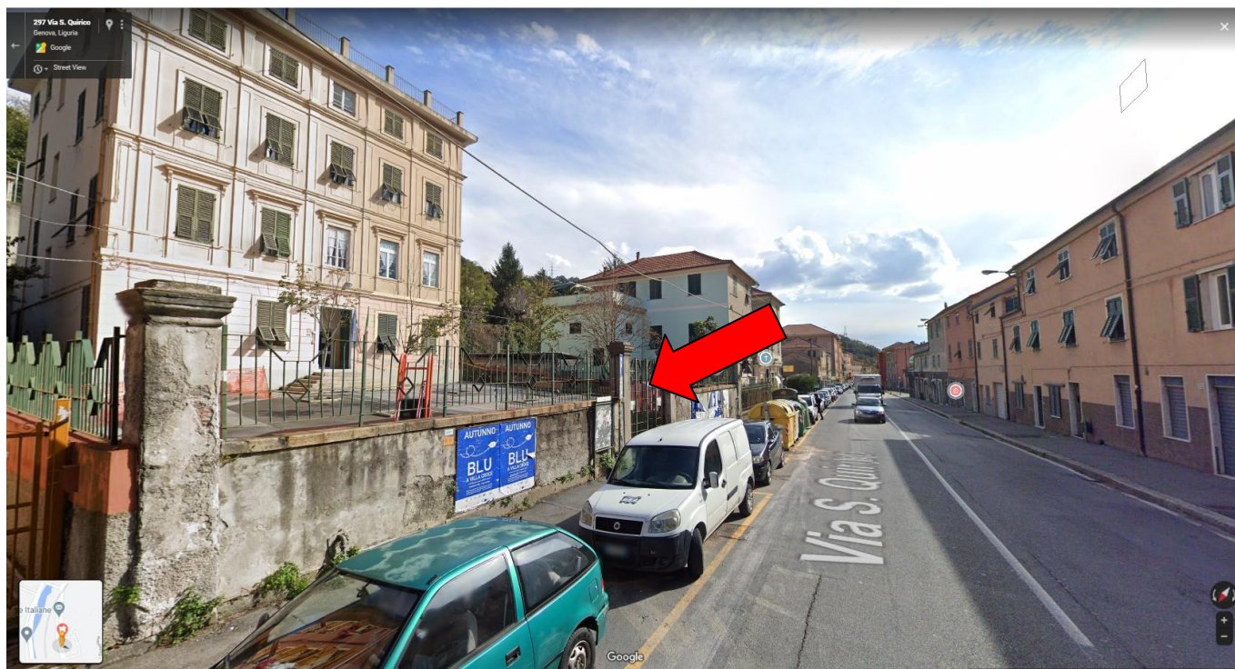
Fig. 40 – Immagine all'altezza della Scuola Materna Comunale “Carlo Garrone” con l'indicazione dell'ingresso della scuola stessa, che risulta intercluso tra un'area dedicata al carico e allo scarico delle merci e un'area dedicata ai cassonetti dell'AMIU, Lato A
