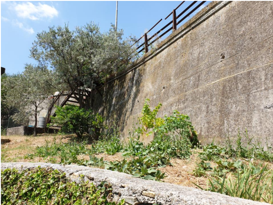
Figura 5 - Vista della porzione di muro a monte dell'intervento Lotto 1 e dettaglio della lesione n.6
