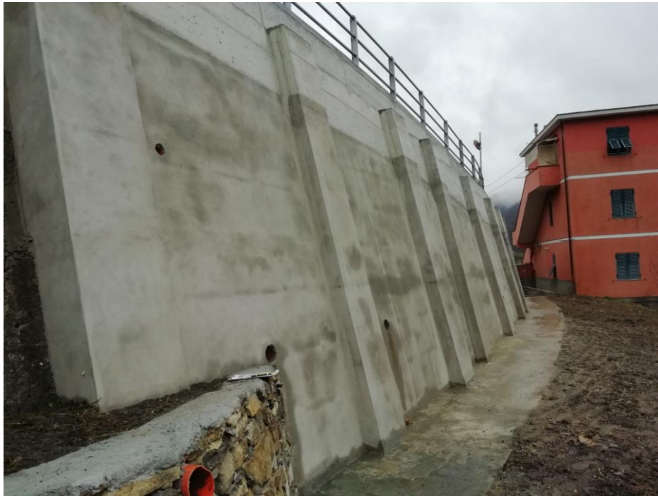
Figura 4 - Vista generale dell'intervento di consolidamento - Lotto 1
