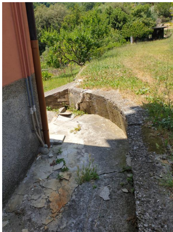
Figura 4 e 5 - Viste del dissesto a valle dell'opera di contenimento
