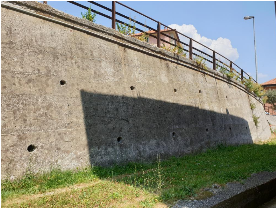
Figura 6 - Vista della porzione di muro a valle dell'intervento Lotto 1
