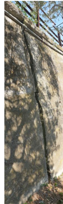
Figura 5 - Vista della porzione di muro a monte dell'intervento Lotto 1 e dettaglio della lesione n.6
