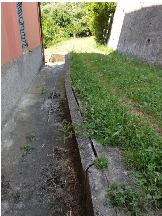
Figura 4 e 5 - Viste del dissesto a valle dell'opera di contenimento
