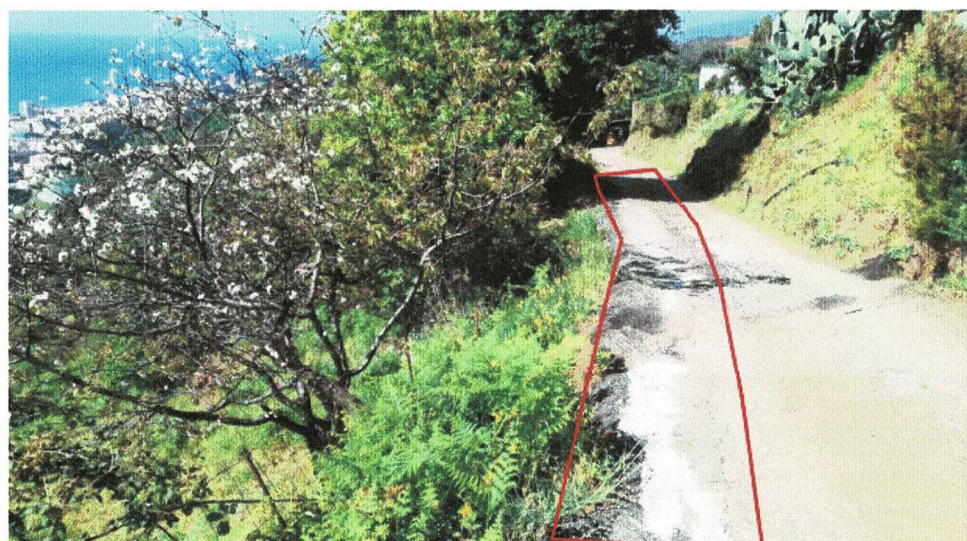
Foto 2 (figura 13) – intervento n. 3, realizzazione cordolo testa pali
