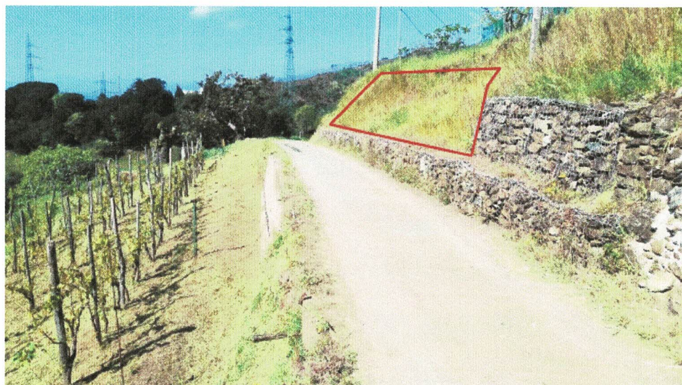
Foto 4 (figura 20) – intervento n. 4, rifacimento gabbionata con in testa doppia palificata
