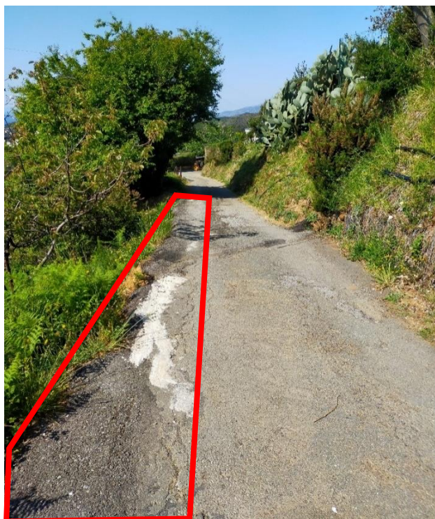
Figura 9 Area di intervento con cordolo su pali a cavalletto
