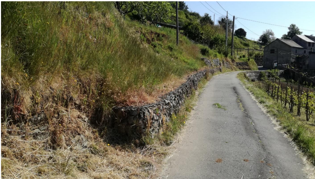
Figura 14 Vista dell'area di intervento da Ovest-Est
