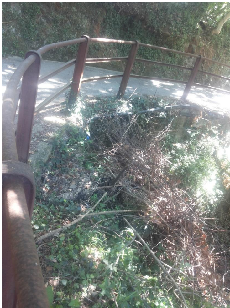
Figura 5 Cordolo lato valle, parziale demolizione/ricostruzione e sostituzione ringhiera di protezione
