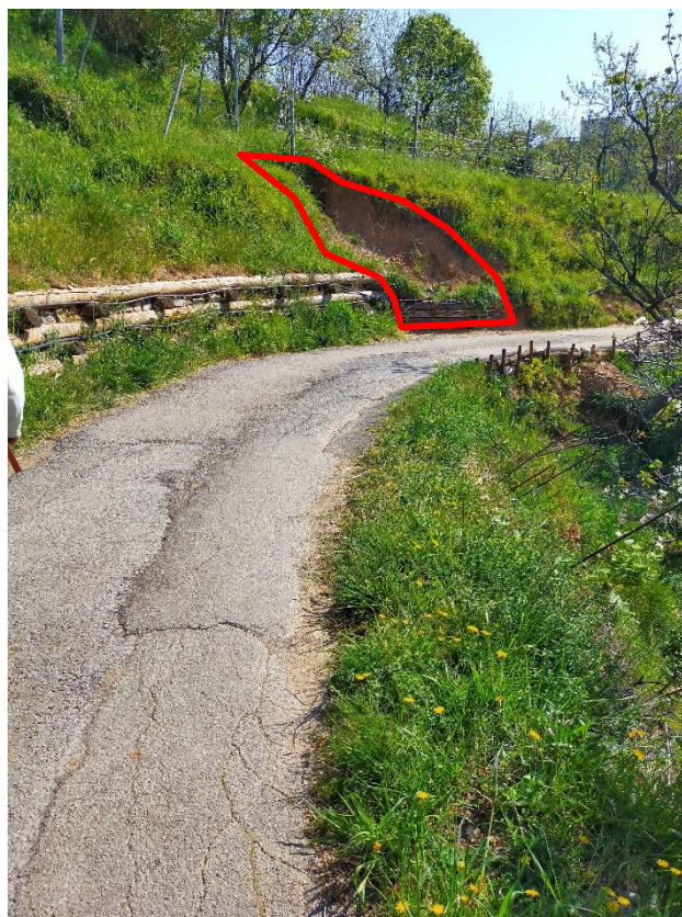
Figura 7 Area da ripristinare con inserimento palificata doppia
