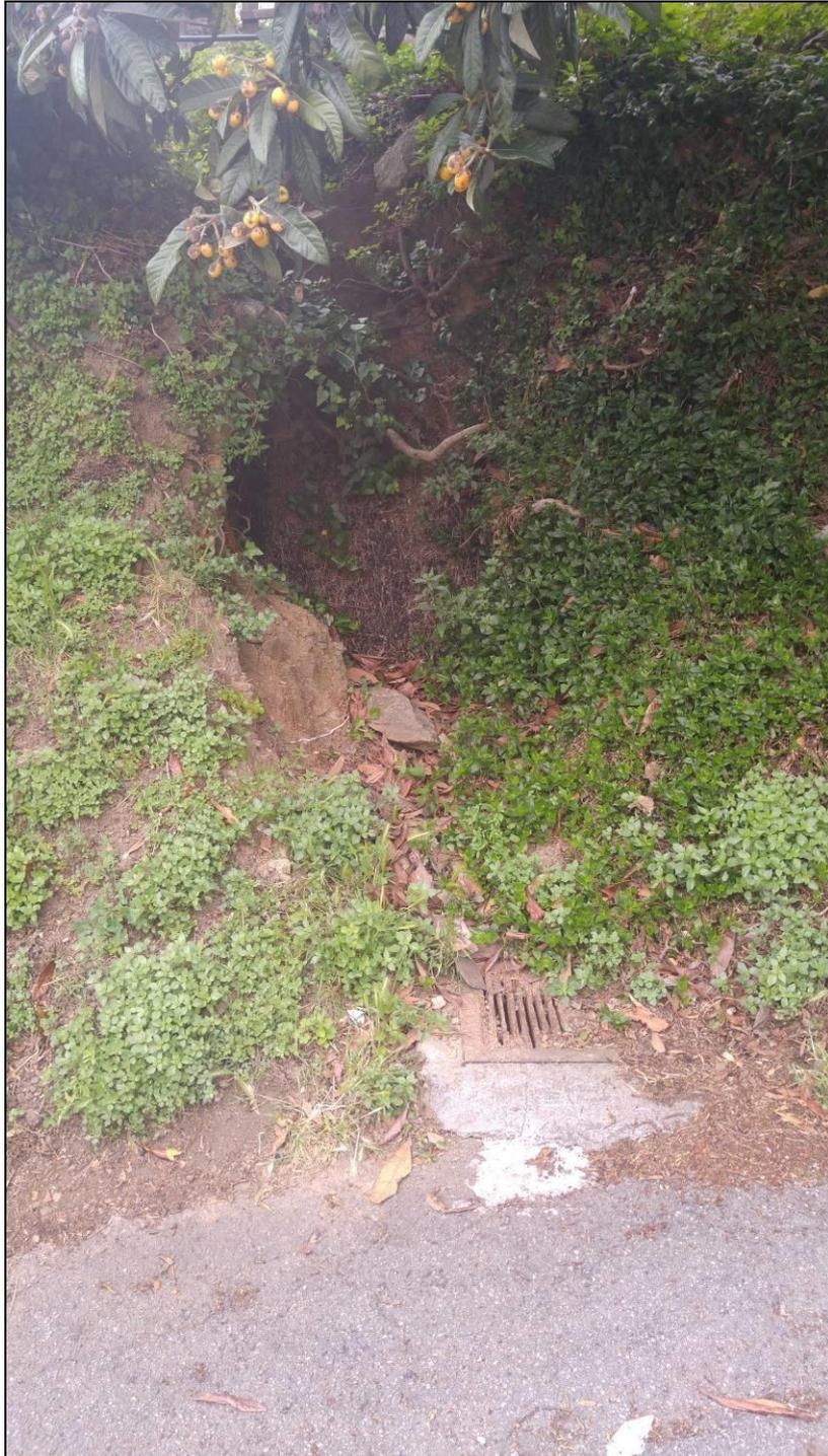
Foto 12 – **Punto 6** - il dissesto puntuale al piede della scarpata, presso l'area di parcheggio. Si nota il pozzetto di raccolta acque, intasato ed inutilizzabile.
