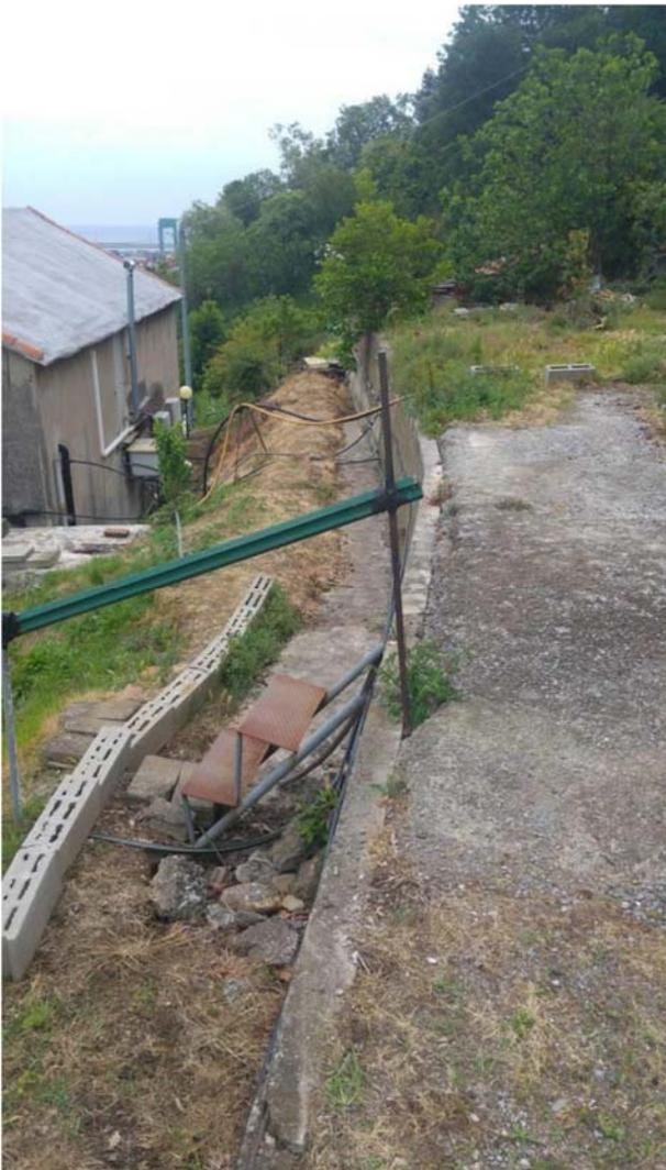
Foto 4 – Le acque provenienti dal versante si incanalano sulla sommità della scarpata a tergo dell'edificio e proseguono verso Sud
