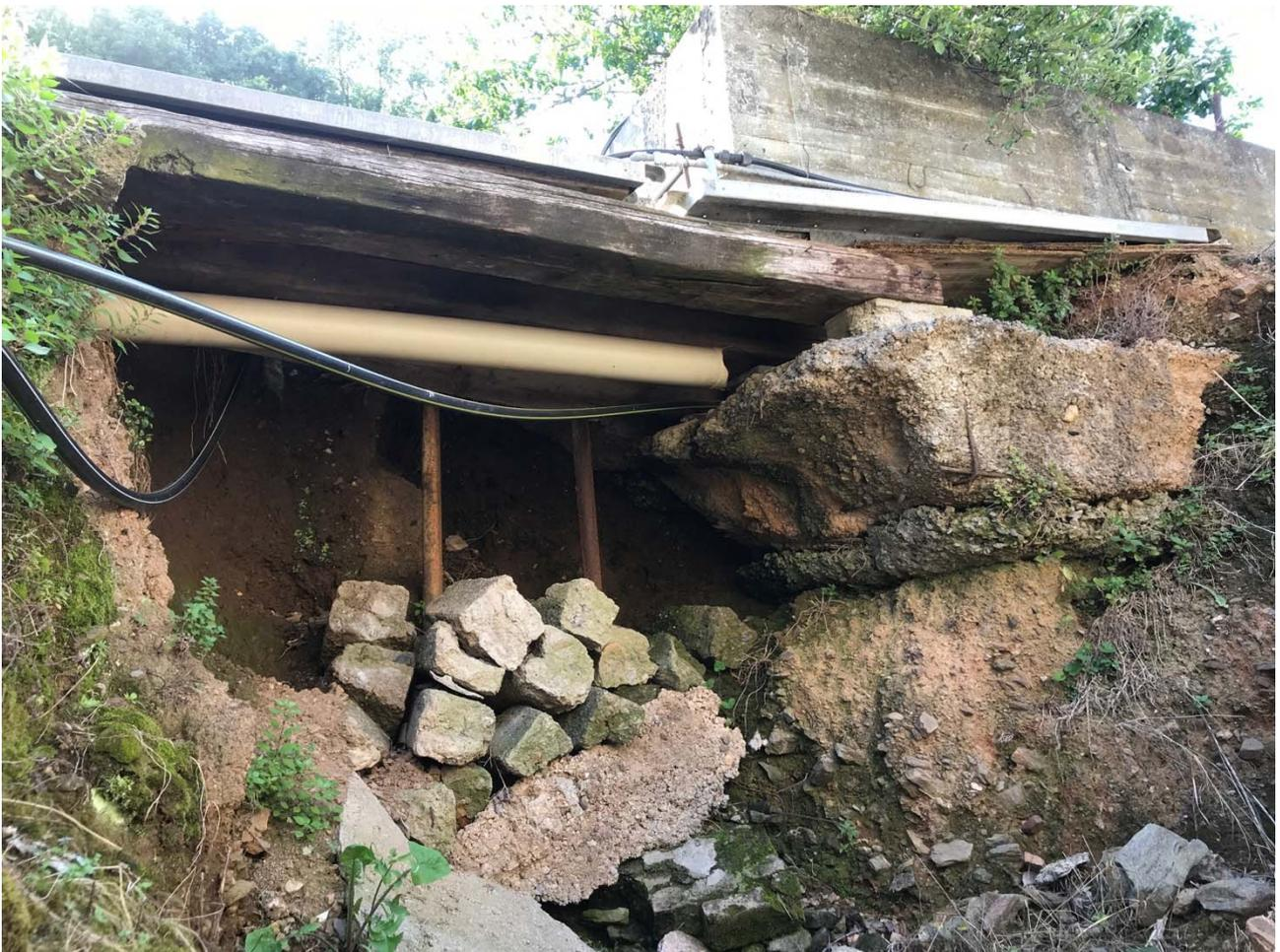
Foto 7 - Erosioni concentrate sul versante a tergo dell'edificio civico 26.
