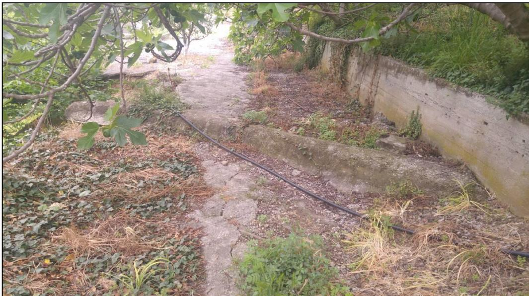
Foto 9 – **Punto 4** lungo la vecchia pista di cantiere è presente un cordolo per l'intercettazione delle acque che non assolve più alla sua funzione
