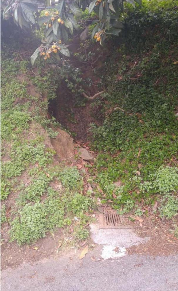
Foto 11 – Punto 6 - Il dissesto puntuale al piede della scarpata, presso l'area di parcheggio. Si nota il pozzetto di raccolta acque, intasato ed inutilizzabile.
