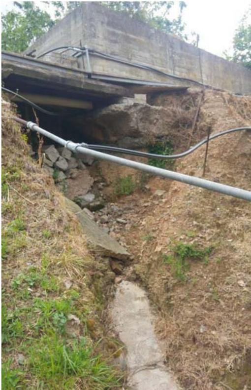
Foto 9 – Le acque provenienti dal versante si incanalano sulla sommità della scarpata a tergo dell’edificio e proseguono verso Sud
