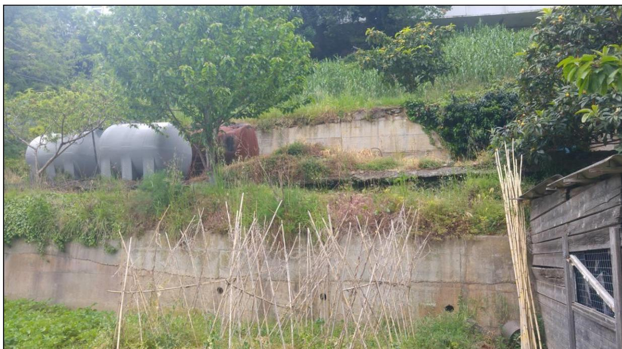
Foto 3 – **Punto 2** in alto la zona di elevata imbibizione e dettaglio del versante interessato da *intensi scorrimenti superficiali*
