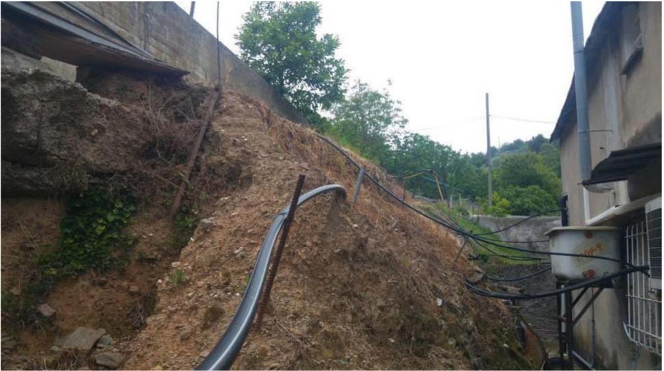
Foto 6 – Erosioni concentrate sul versante a tergo dell'edificio civico 26.
