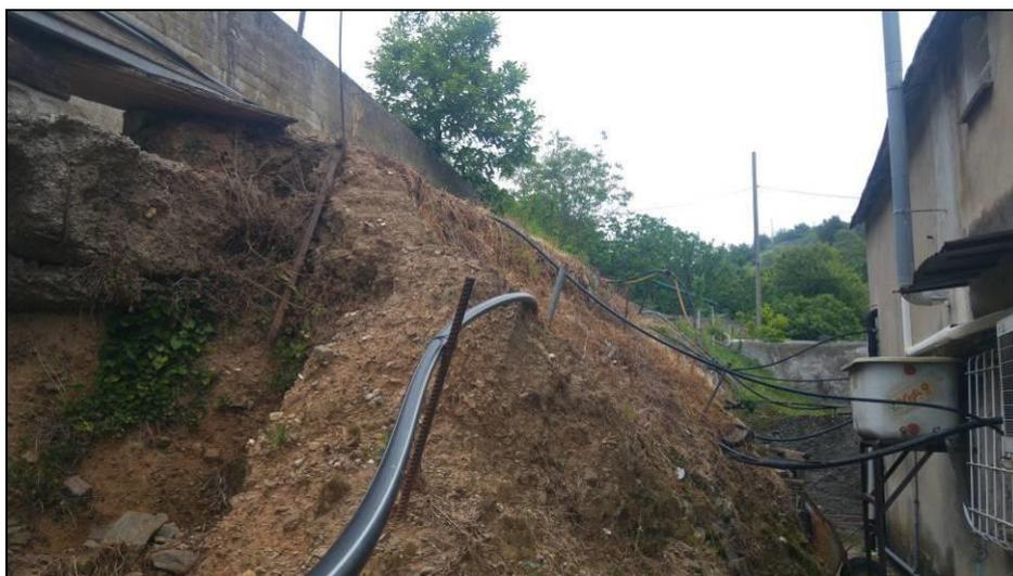
Foto 6 – **Punto 3** le acque di cui alle foto precedenti provocano un dissesto a carico della scarpata
