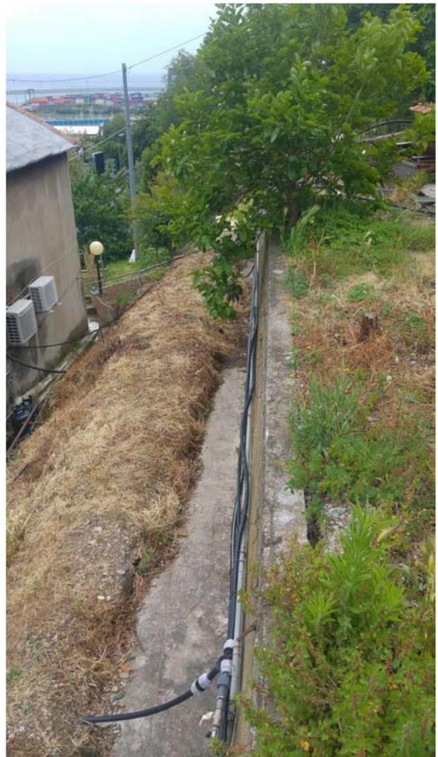
Foto 5 - Sommità della scarpata a tergo dell'edificio sulla quale convergono ingenti quantitativi causa di fenomeni di erosione concentrata.
