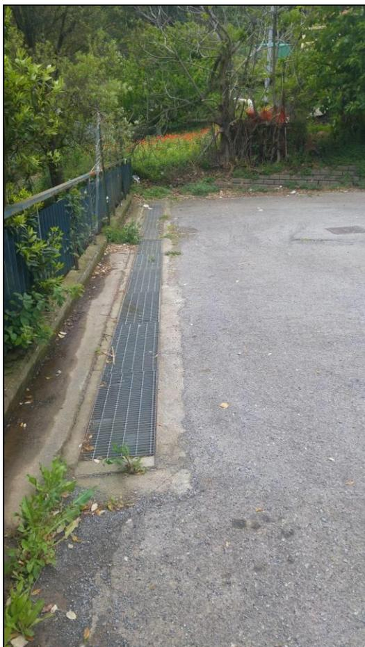
Foto 13 – circa una decina di metri a valle di foto 11, al limite dell'area parcheggio è presente una grata per la raccolta acque e successivo allontanamento al Rio San Michele
