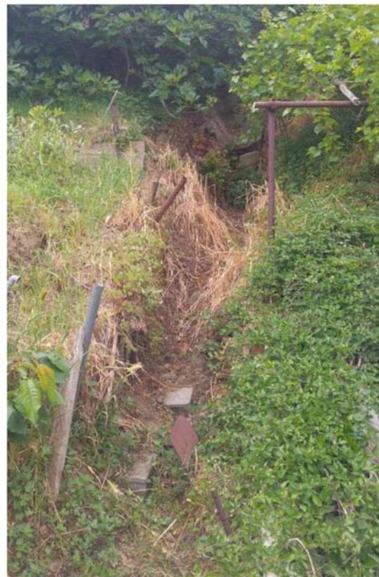
Foto 10 – Le acque parzialmente deviate dal cordolo di cui all punto 4, giungono alla rampa asfaltata tramite un solco di erosione lungo il versante trasportando considerevoli quantità di detrito.
