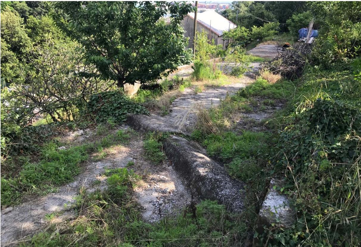
Foto 8 –Cordolo per la cattura dell’acqua sulla pista di cantiere posta a monte del civico 26 (Punto 4).
