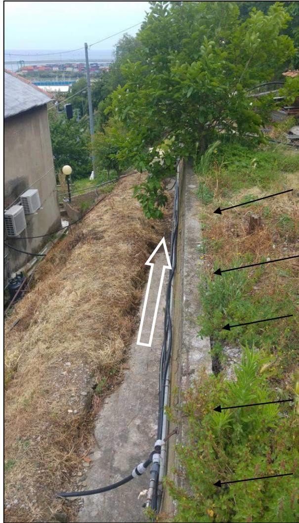
Foto 4 –5 **Punto 3** le acque provenienti dal versante si incanalano al piede del muretto di sostegno, sulla sommità della scarpata a tergo dell'edificio e proseguono verso Sud
