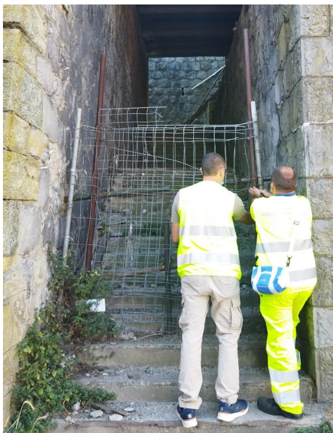
Foto 1: imbocco Salita Acquamarsa da via Giro del Vento
