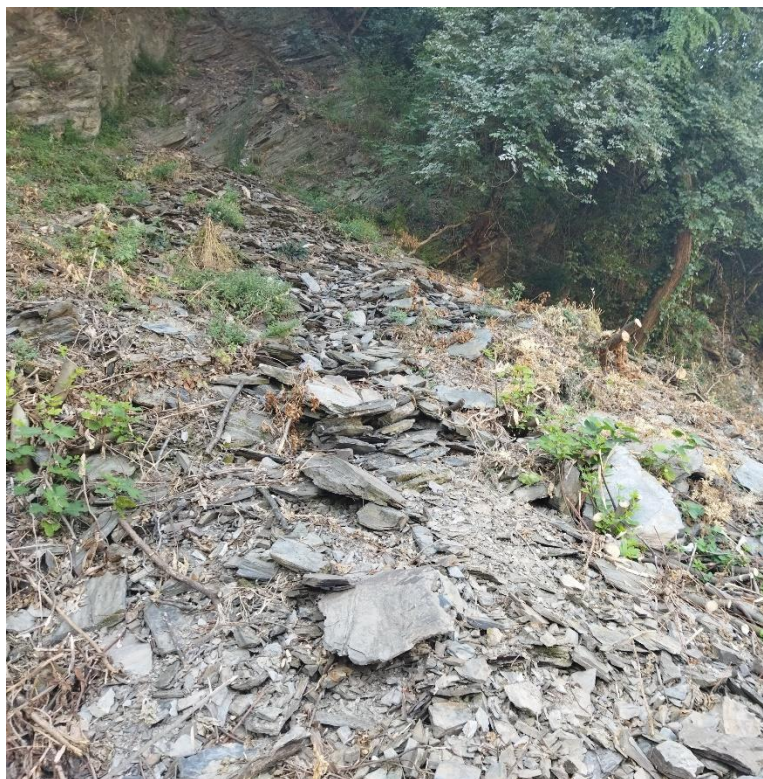
Foto 6: dettaglio materiale crollato
