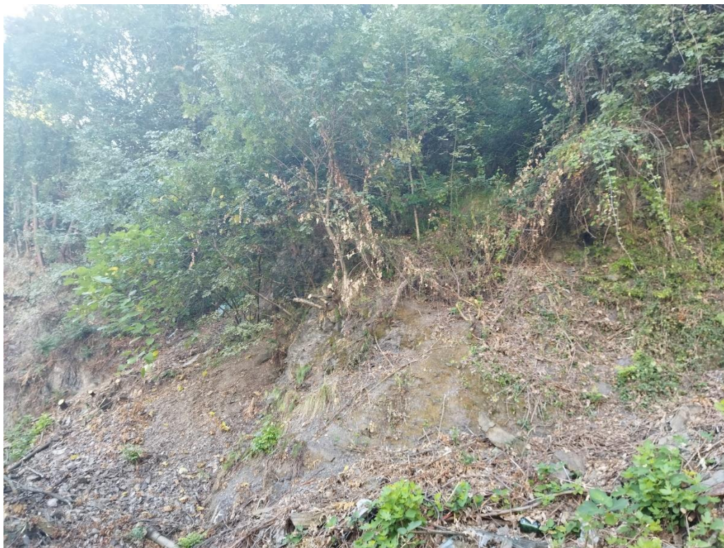
Foto 7: scarpata in abbandono, parzialmente ripulita da Autostrade
