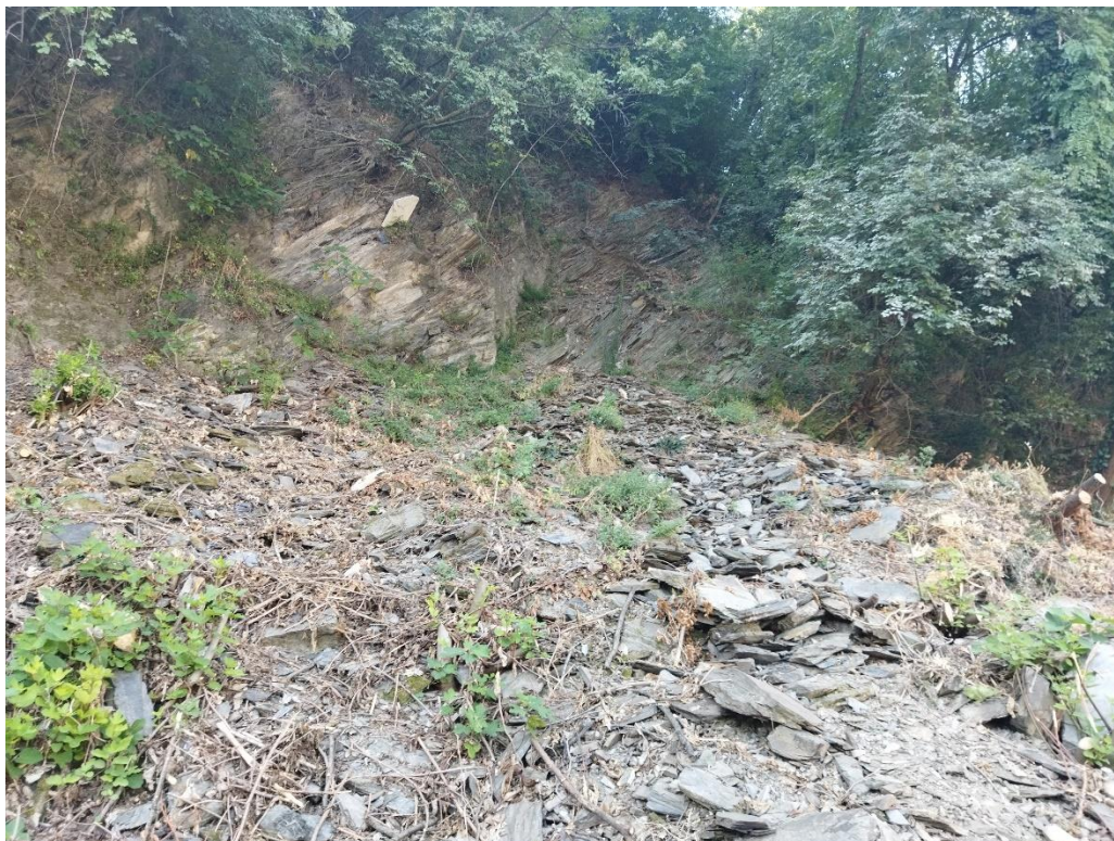
Foto 5: zona di accumulo materiale lapideo e in sommità nicchia di distacco
