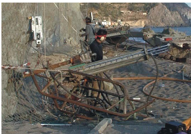
Figura 7: slitta di perforazione
