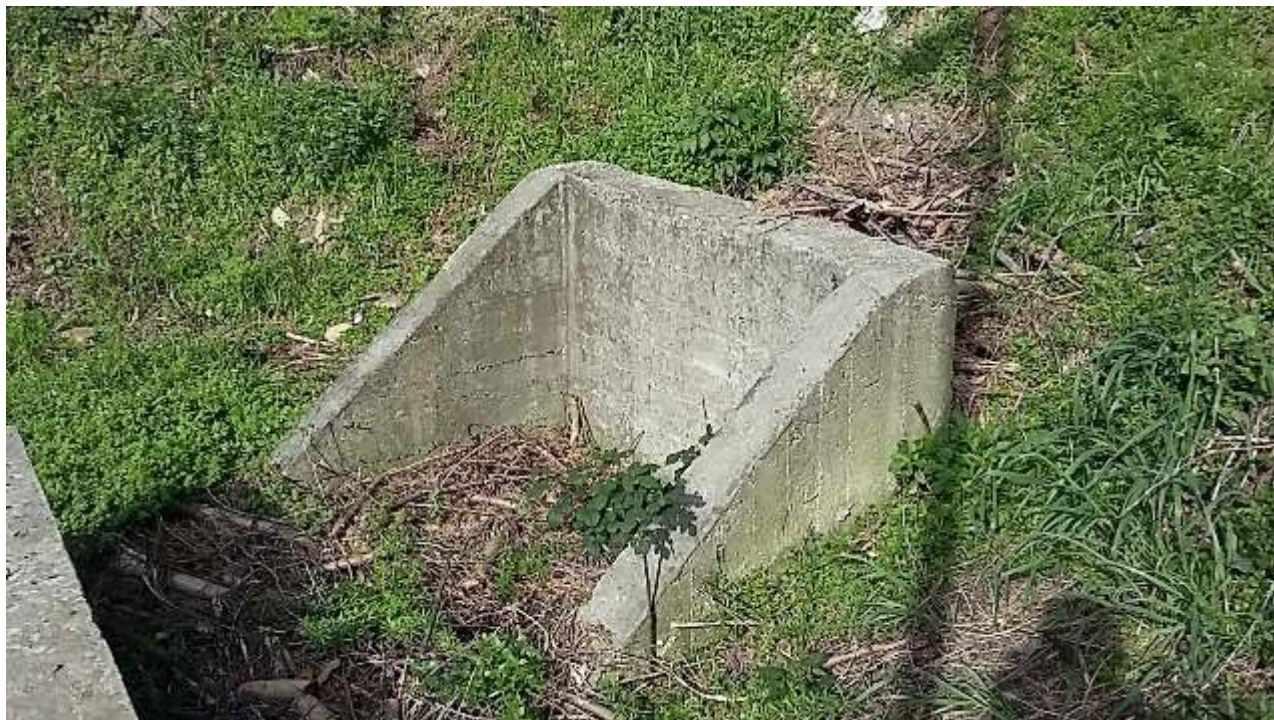
Foto 16 – Particolare del manufatto presente a tergo del muro lato monte di Via A. Robino, in corrispondenza del primo impluvio.
