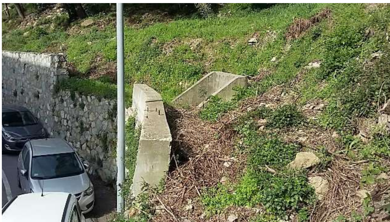
Foto 17 – Particolare del manufatto presente a tergo del muro lato monte di Via A. Robino, in corrispondenza del primo impluvio e del breve tratto (8-10 m) di muro in c.a. sovrapposto al muro originario.
