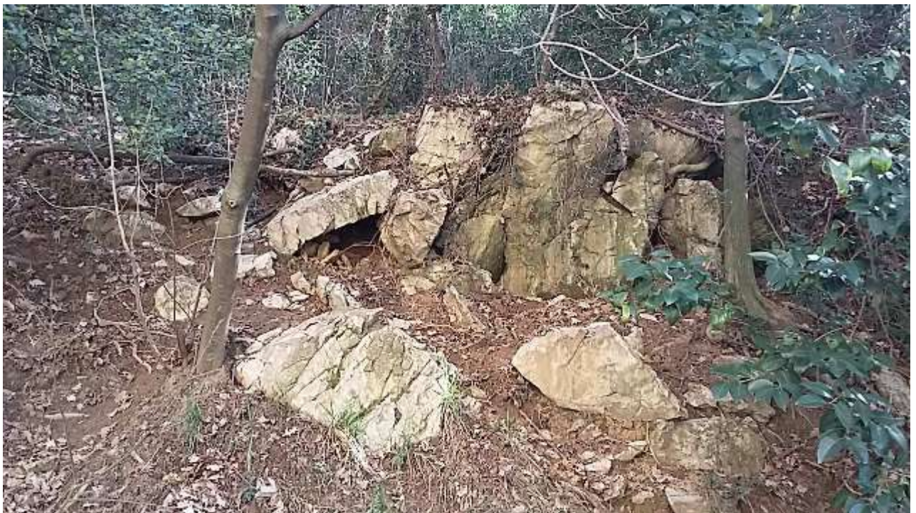
27 - Substrato roccioso fortemente alterato e dislocato subito a monte della carreggiata di Via A. Robino, in un tratto non protetto.
