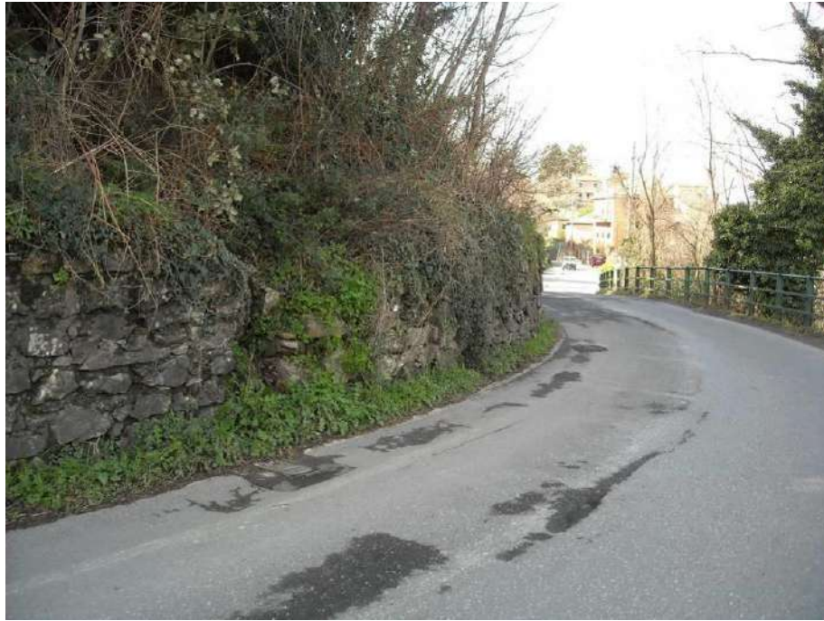
Foto 13 – Il muro in fregio alla via Montelungo, in corrispondenza della curva (verso Bavari), su cui si intende intervenire sostituendolo con muro in c.a rivestito in pietra e allargando leggermente la sezione stradale.
