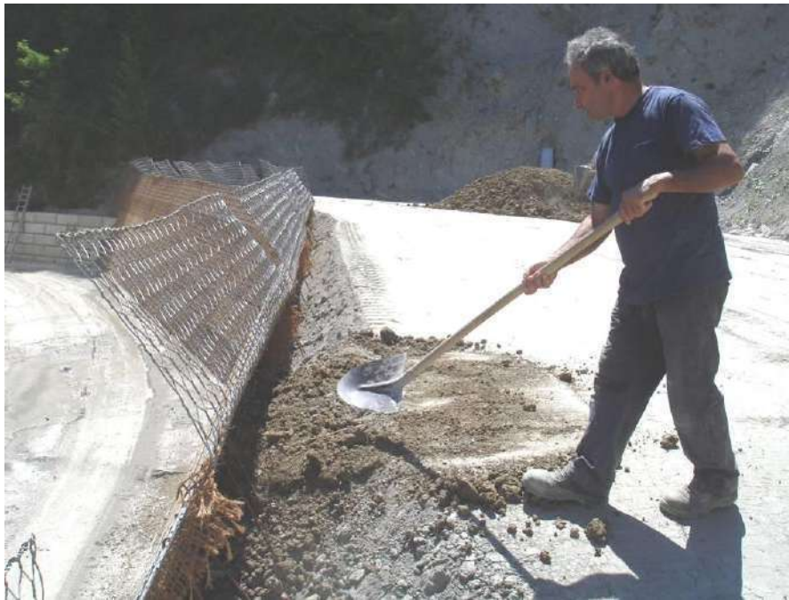
Riempimento a tergo del paramento
