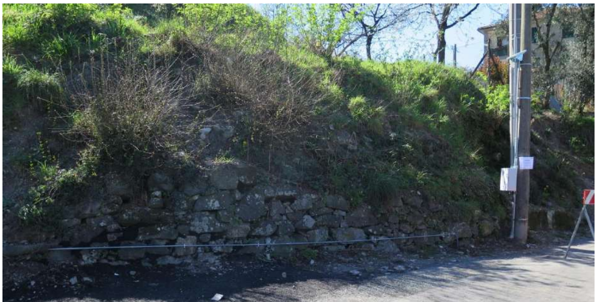
Figura 11: cavidotto dalla colonna inclinometrica a pannello di acquisizione dati.
