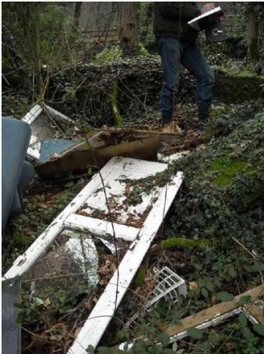
Foto 6 Zona di presunta fuoriuscita del tombino che sottopassa la via Serino e che (un tempo) riceveva le acque provenienti dal tunnel. Il foro di uscita non è più rintracciabile
