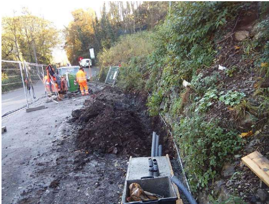
Figura 3 – Scavo protezione catodica
