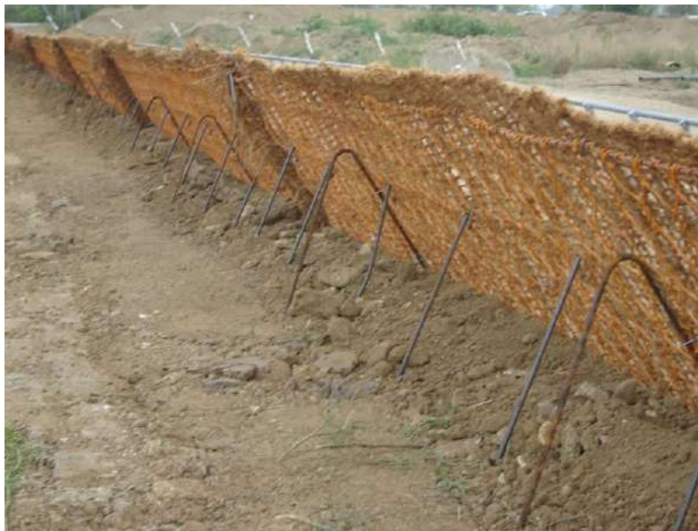
Tiranti di irrigidimento del frontale
