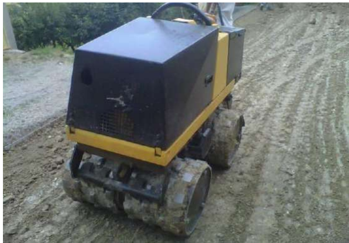
Compattazione del materiale per ciascuno degli strati
