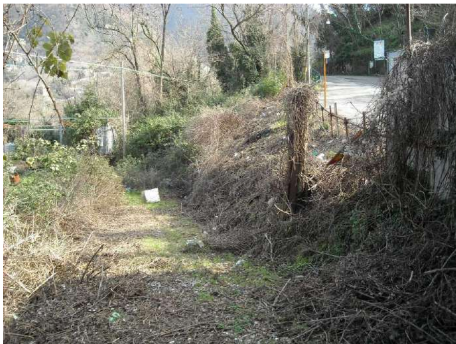
Foto 11 – Il versante a valle del tratto di cui alla foto precedente interessato dai più marcati avvallamenti
