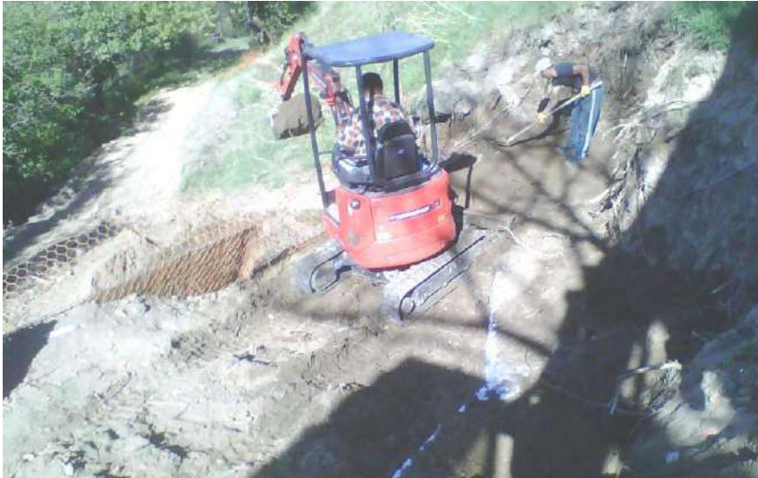
Riempimento e stesa degli strati
