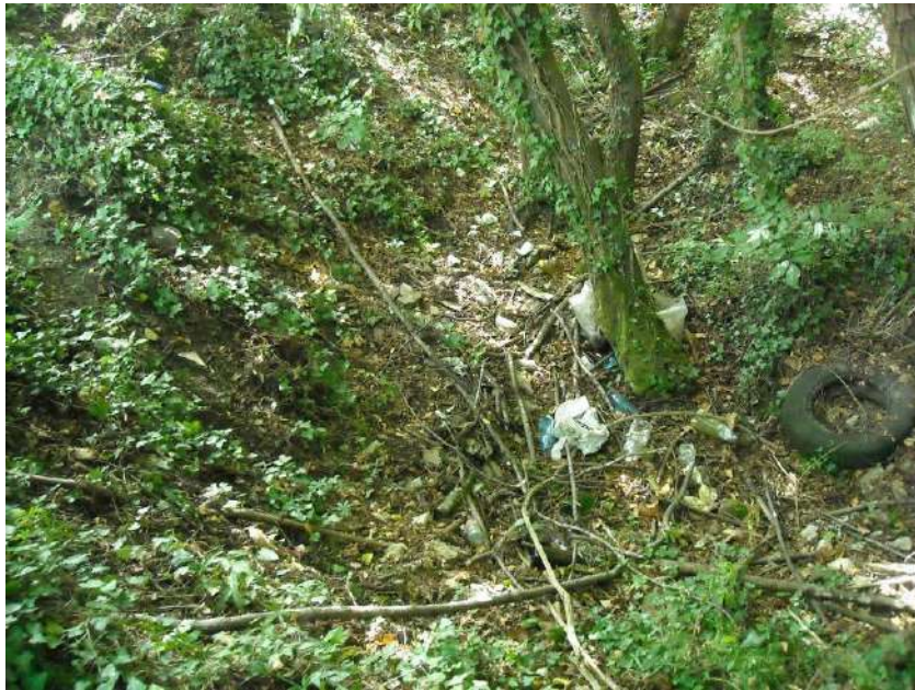
Foto 5 Zona a monte di via Montelungo nel punto di presunto imbocco del tunnel non più visibile al di sotto della scarpata
