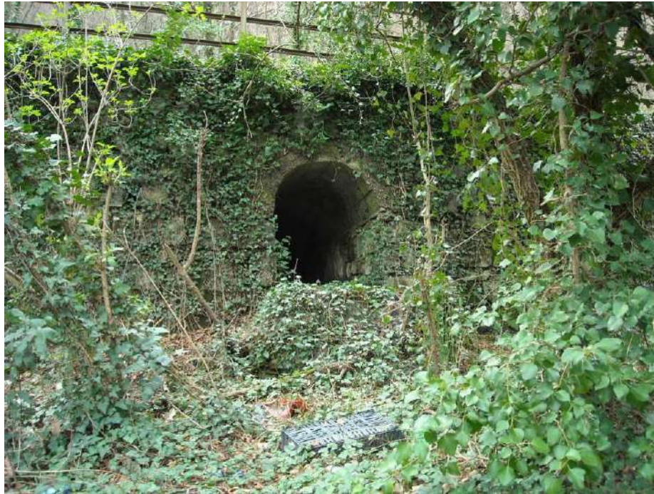
Foto 3 – Uscita del tunnel che sottopassa via Montelungo visto da Via Serino
