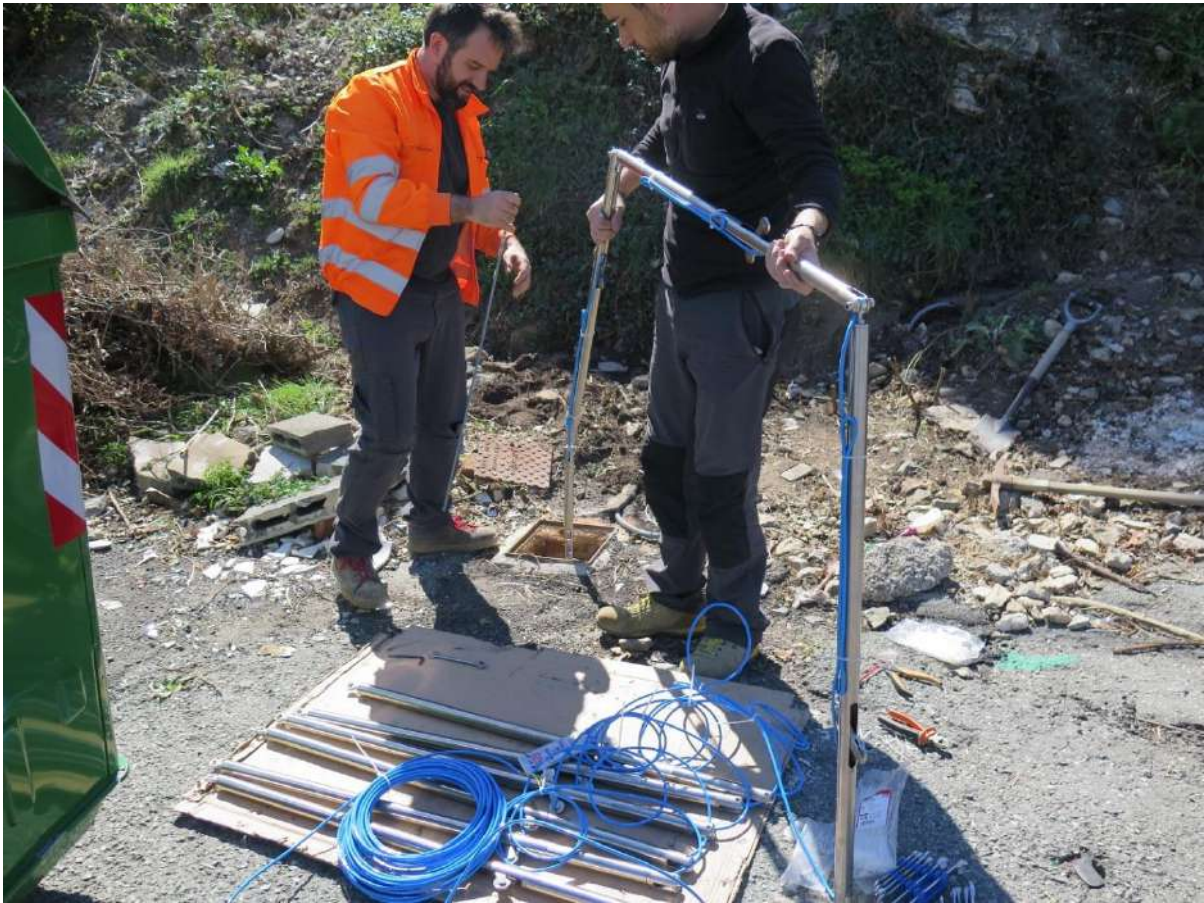
Figura 10: installazione delle sonde inclinometriche all'interno del preesistente tubo inclinometrico S7. Si noti come ciascuna sonda sia vincolata fisicamente alle sonde adiacenti tramite uno snodo.
