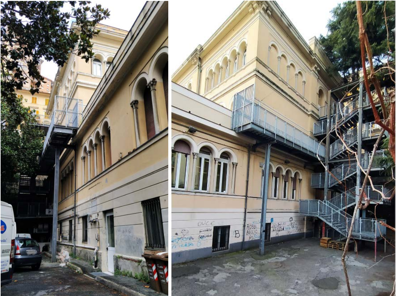
Figura 3/4 – Foto Gennaio 2020 – Scale metalliche antincendio esterne
