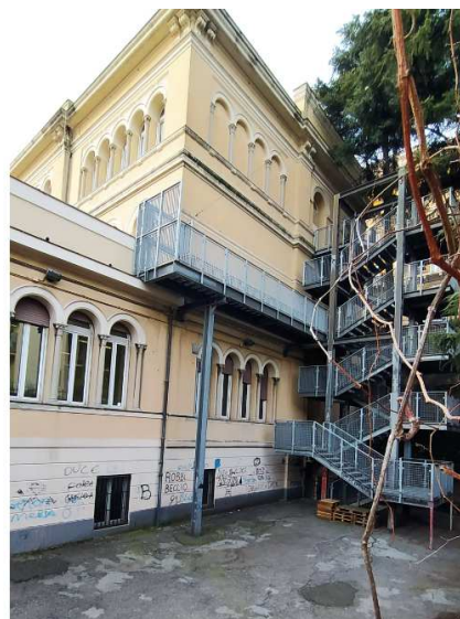
Le scale metalliche già realizzate
