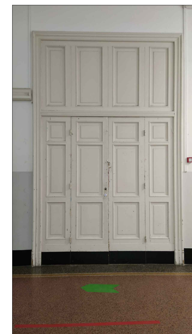
Foto di dettaglio dello stato attuale: serramento in legno da mantenere
