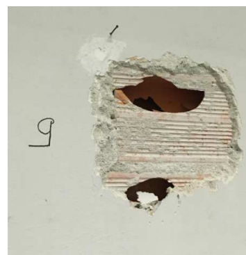
Muro in mattoni forati
