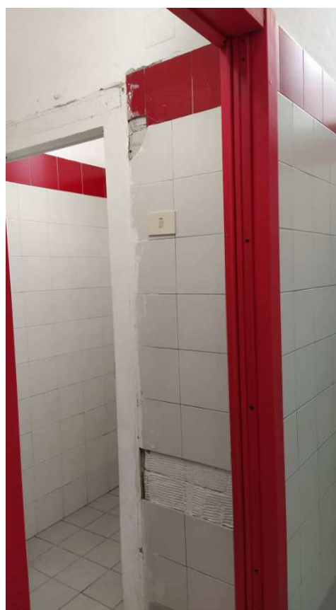
Servizi igienici: particolare con fenomeni di umidità e distacco del rivestimento in piastrelle
