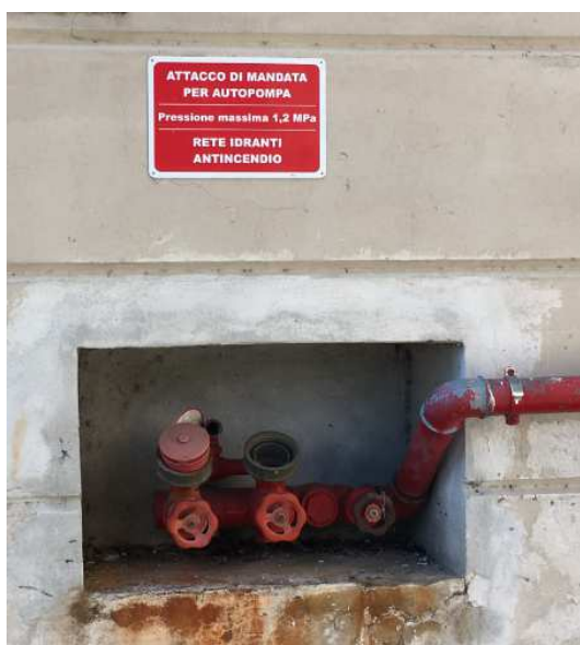
Dettaglio dell'attacco per motopompa
