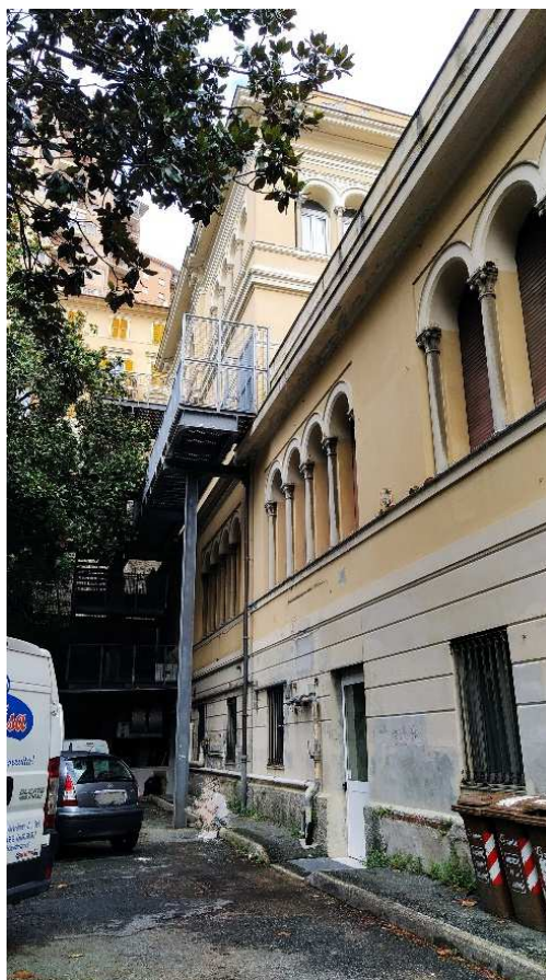
Il lato Sud Est con la scala antincendio e l'ingresso al centro cottura
