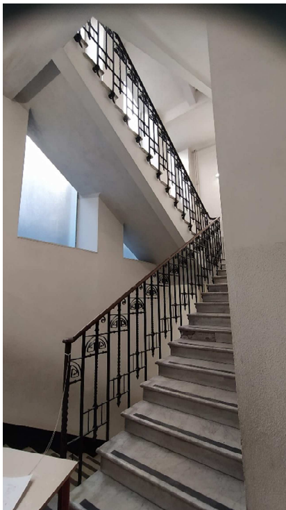
Uno dei due scaloni, contrapposti, che servono i piani terra e primo
