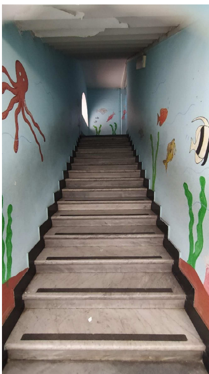
Scala che, dal piano ammezzato della scuola dell'infanzia, porta al primo piano ed infine alla torretta est.
