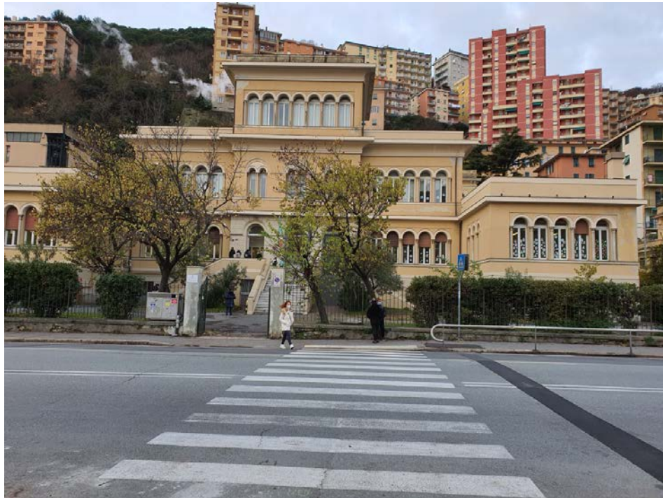
Figura 1 – Foto Gennaio 2020 – Prospetto Via Montaldo
