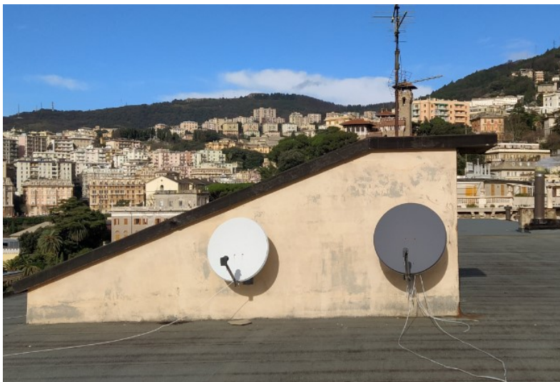
Figura 13 - Copertura: uscita vano scala
