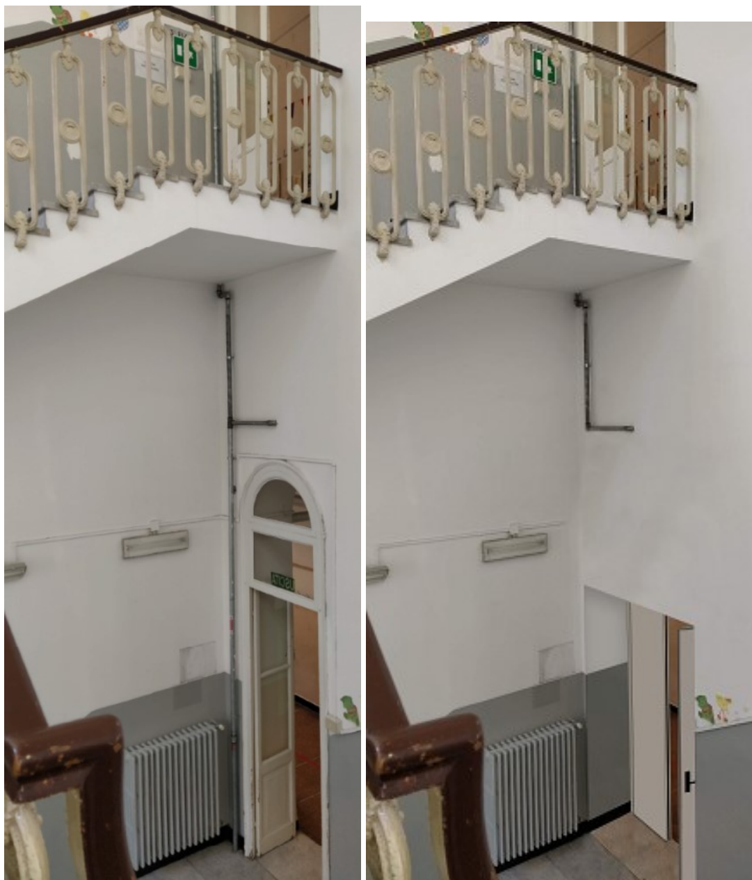
Panoramica vano scala. A destra lo stato attuale, a sinistra la porta rei doppio modulo.
