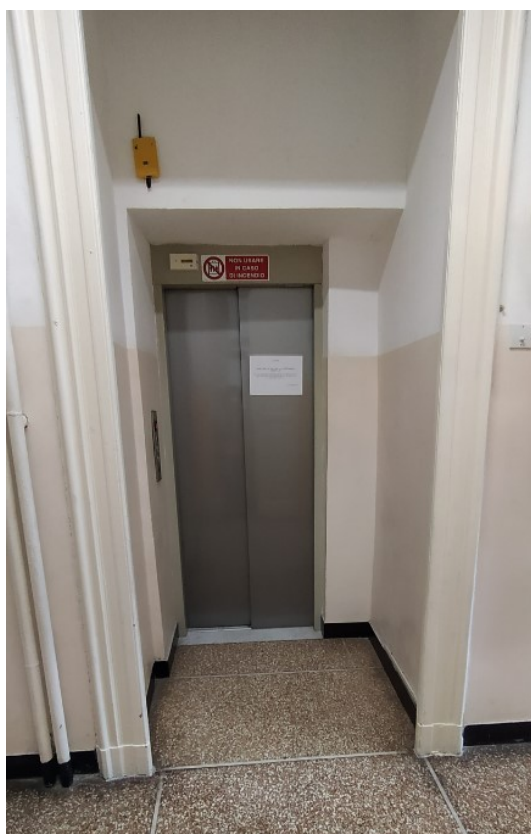
Figura 10 - Ascensore installato nel 2008
