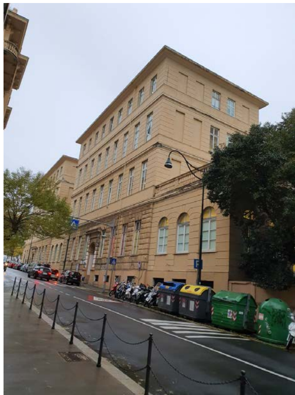
Figura 4 – Foto Gennaio 2020 – Prospetto Ovest, Corso Firenze
