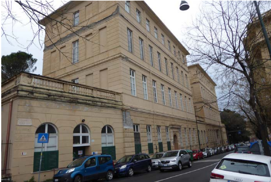
Figura 3 – Foto Gennaio 2020 – Prospetto Ovest, Corso Firenze
