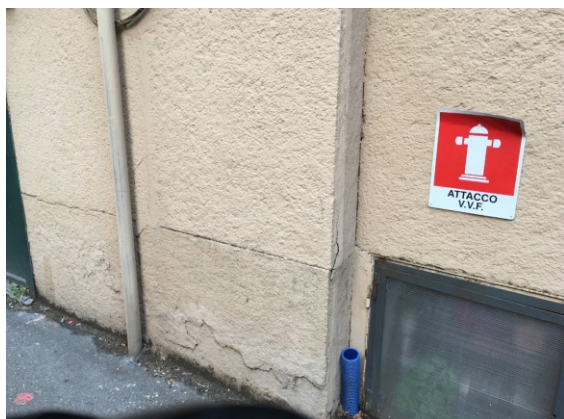
Dettaglio dell'attacco per motopompa
