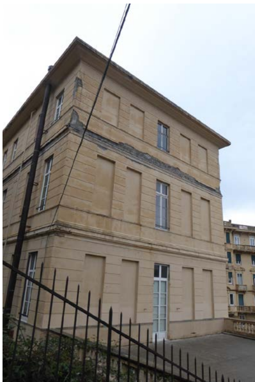
Figura 5 – Foto Gennaio 2020 – Prospetto Nord
