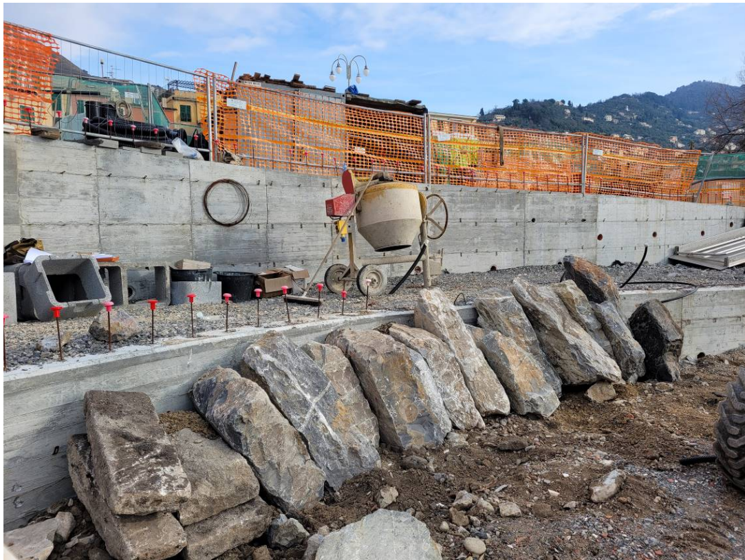
Fig. 16. Prova della posa delle scarpate del 12.2.2021.
