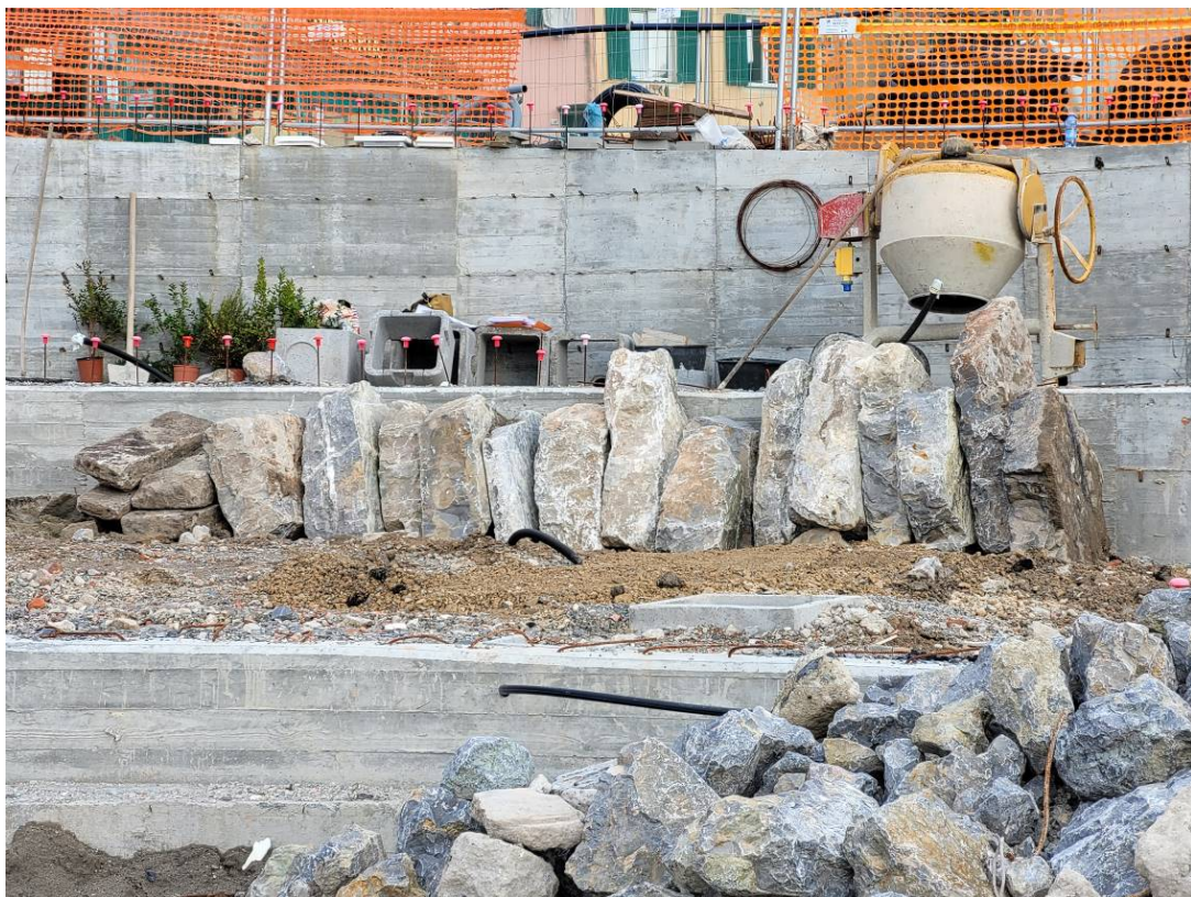
Fig. 17. Prova della posa delle scarpate del 12.2.2021.
