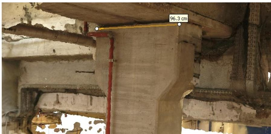
Figura 11: ricostruzione software del pilastro con pulvino
