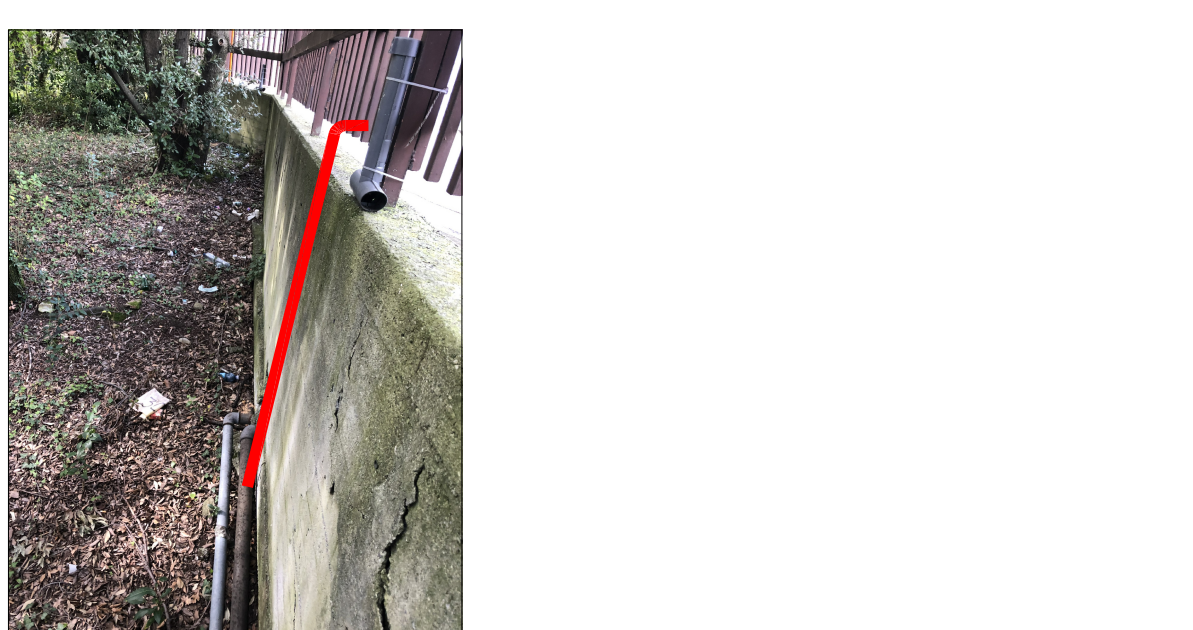
FOTO 2: STACCO TUBAZIONE PER ATTACCO MOTOPOMPA VVF
