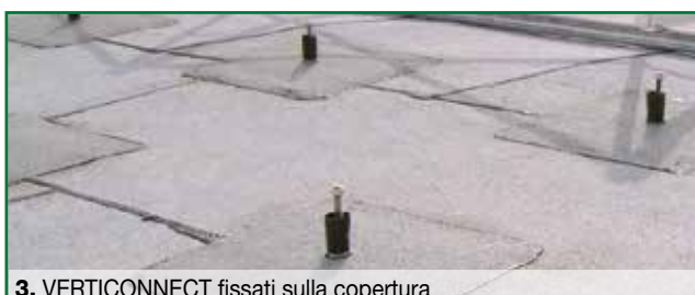
3. VERTICONNECT fissati sulla copertura
