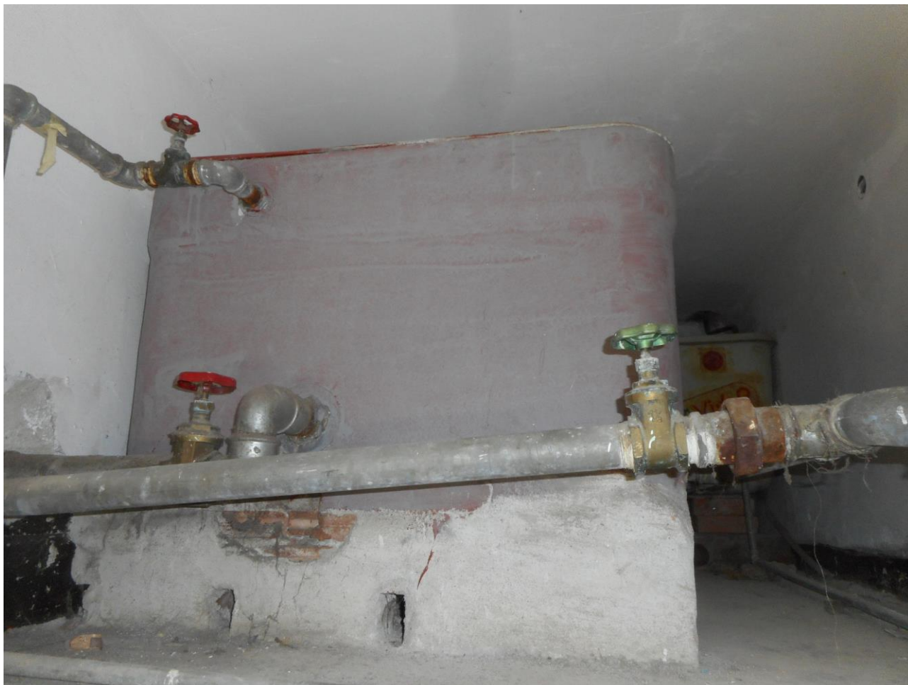
Gli attuali serbatoi in eternit usati come riserva idrica
