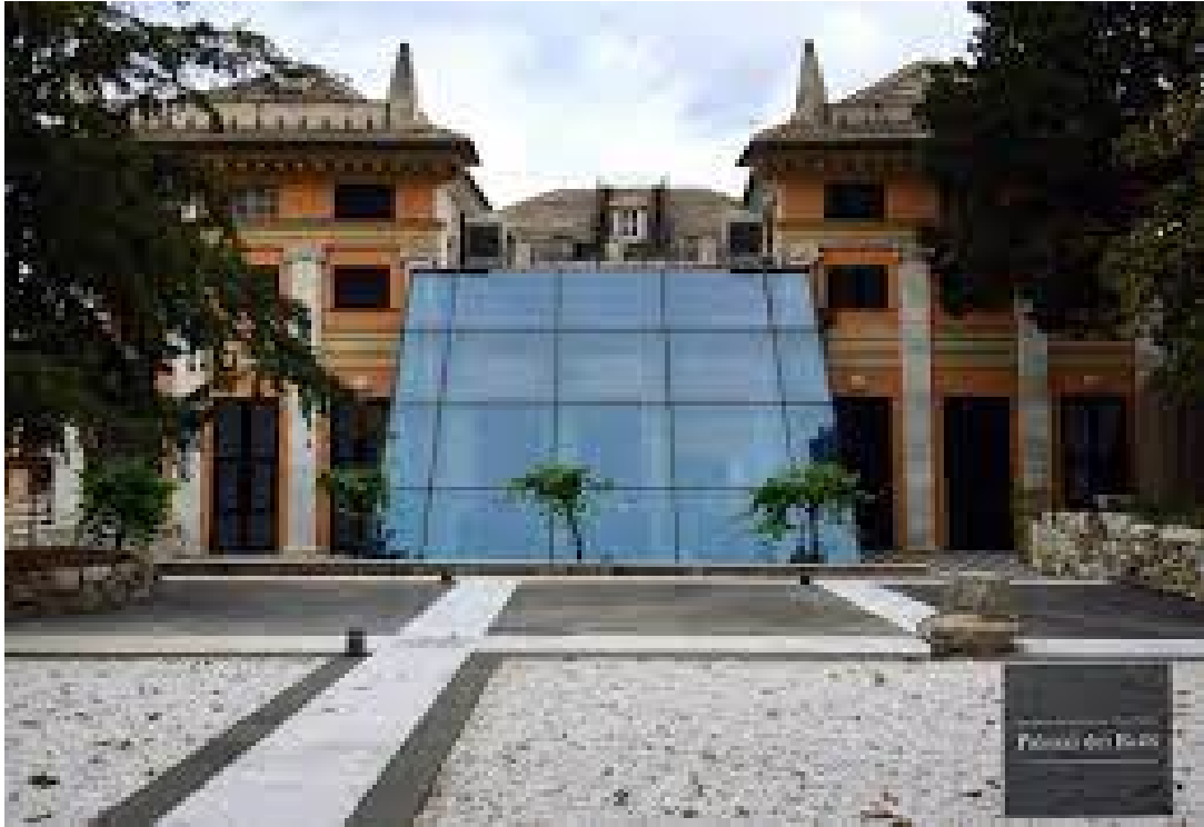
La Vela, o giardino d'inverno, vista dal parco superiore
