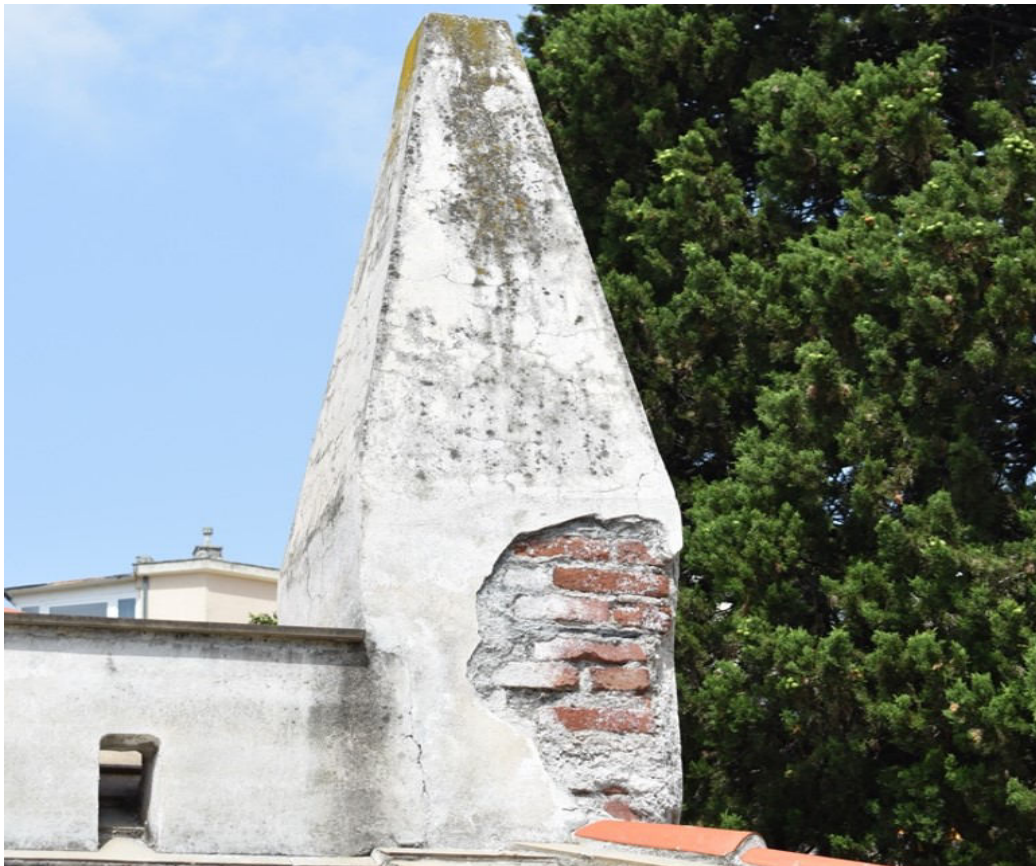
Foto 04 ( pinnacolo lato monte )
