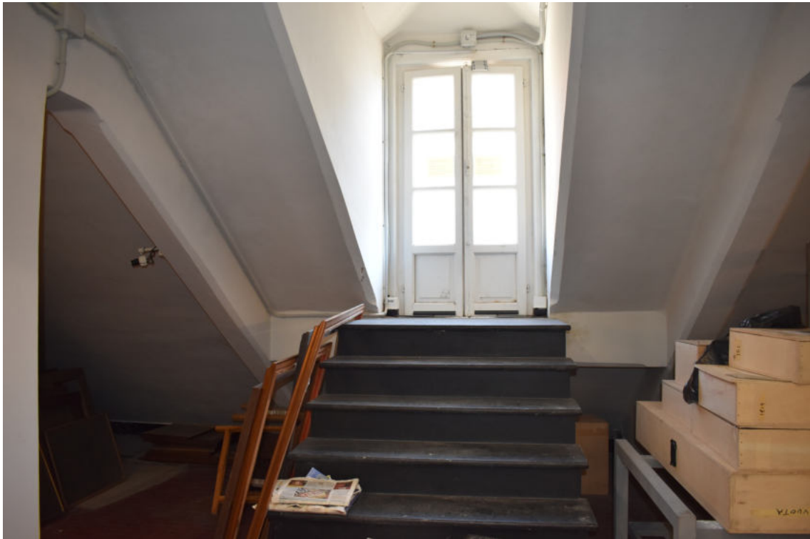
Foto 03 (accesso alla copertura – lato cortile)
