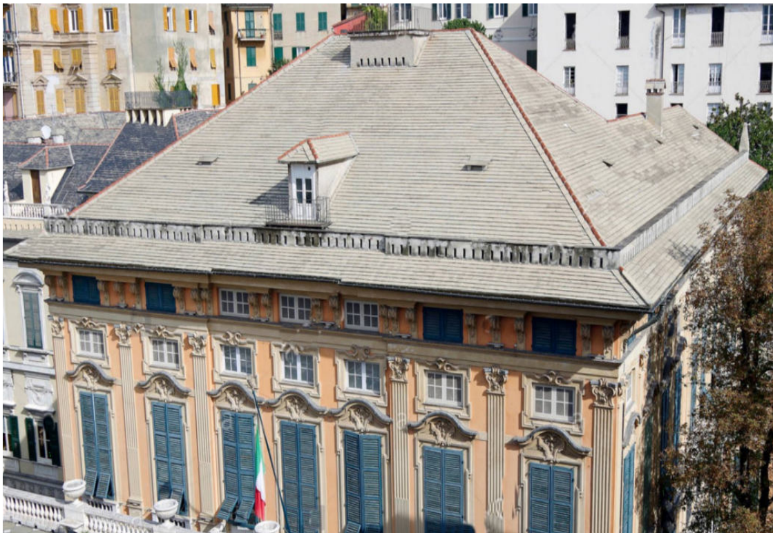
Foto 04 (Vista sud – fronte principale)
