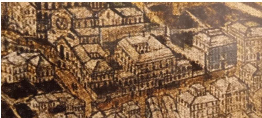
Strada nuova a fine '600 (palazzo Grimaldi arretrato rispetto al fronte della via)
