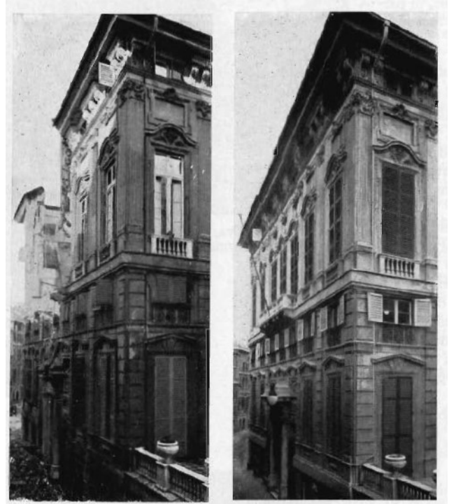
FIGG. 10, 11 - GENOVA, PALAZZO BIANCO - LO SQUARCIO DELLA FACCIATA DOPO IL BOMBARDAMENTO; LA FACCIATA DOPO LA RICOSTRUZIONE E LA RIPRESA DI TUTTA L'ARCHITETTURA
