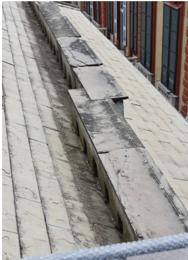
Foto 08 (muretto d'attico su via Garibaldi)
