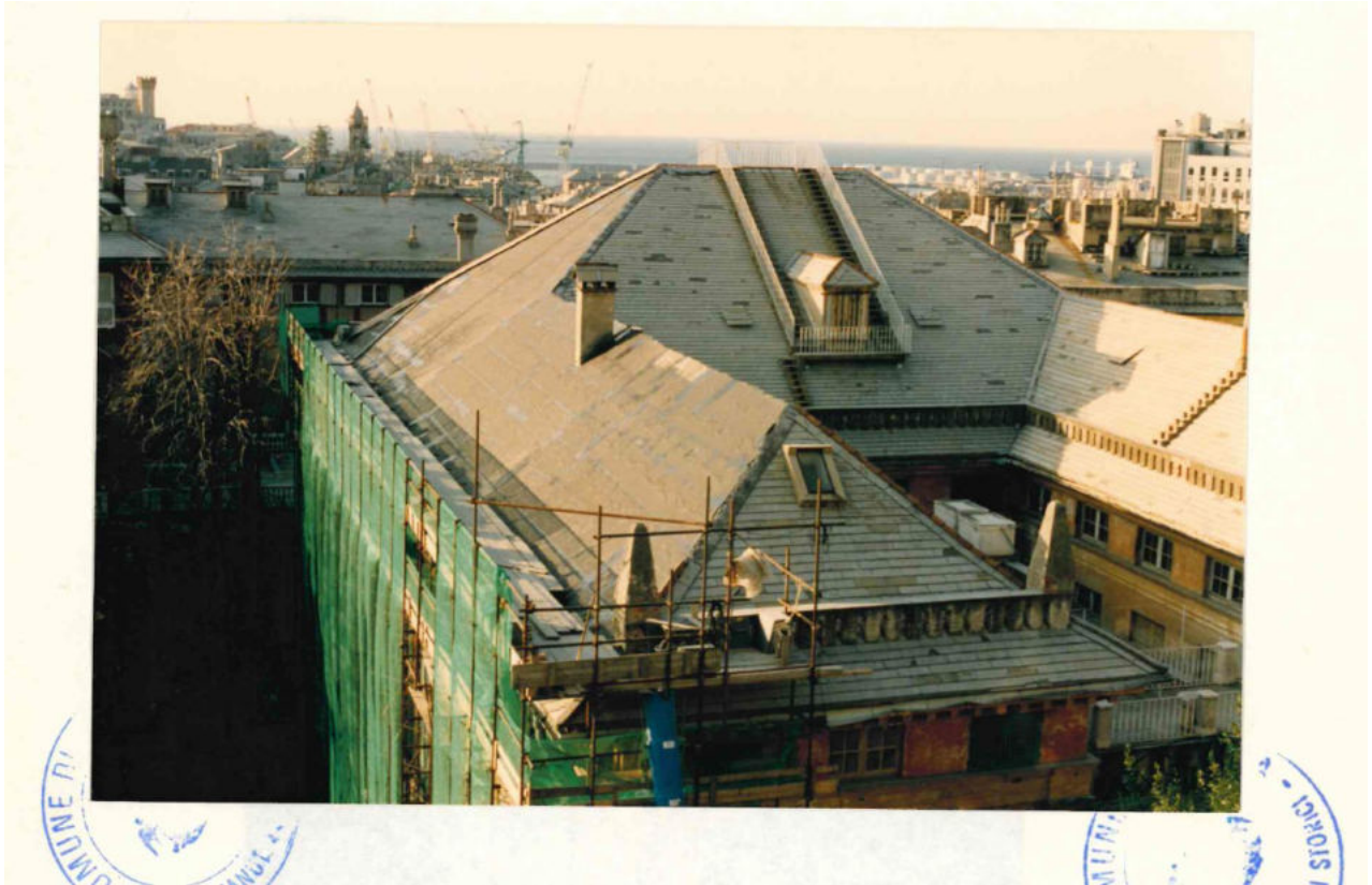
Cantiere 1990 (falde esterne)
