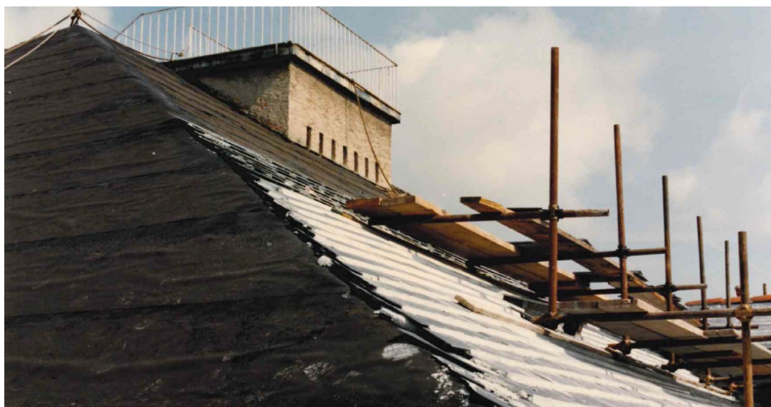
Falda sul fronte e di ponente
