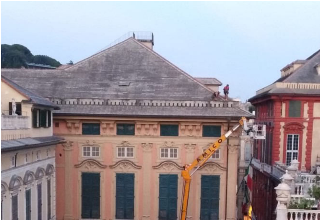
Foto 03 (Vista da ponente – messa in sicurezza gronda/muretto attico)
