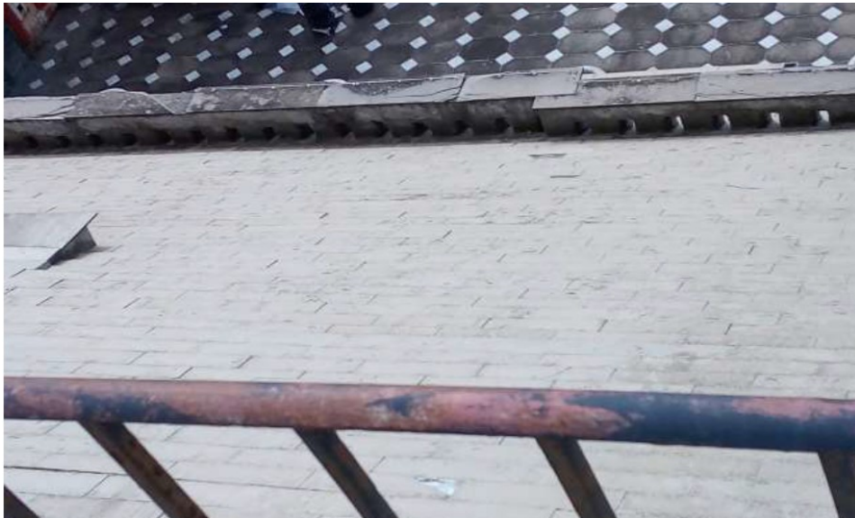
Copertura corpo principale, muretto d'attico su via Garibaldi
