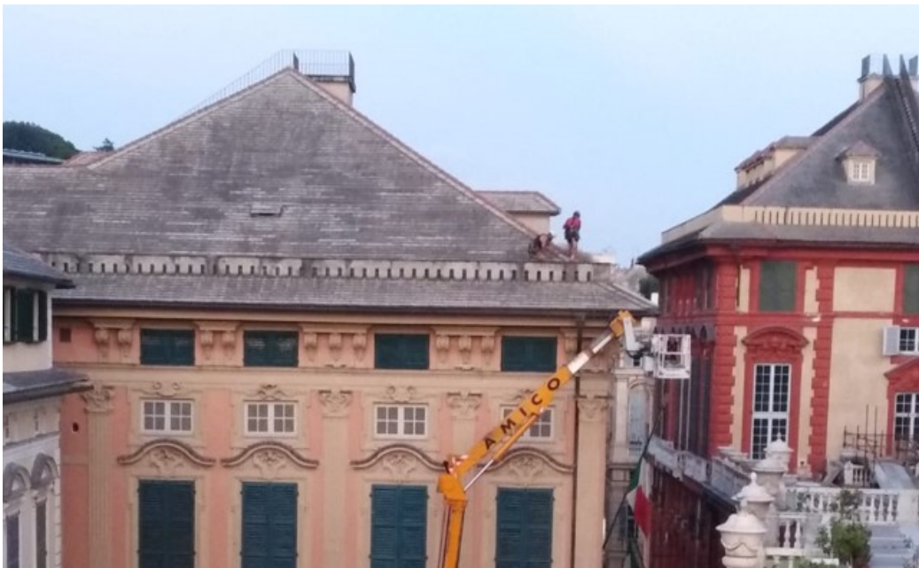
Intervento di messa in sicurezza fascia di gronda (luglio 2021)
