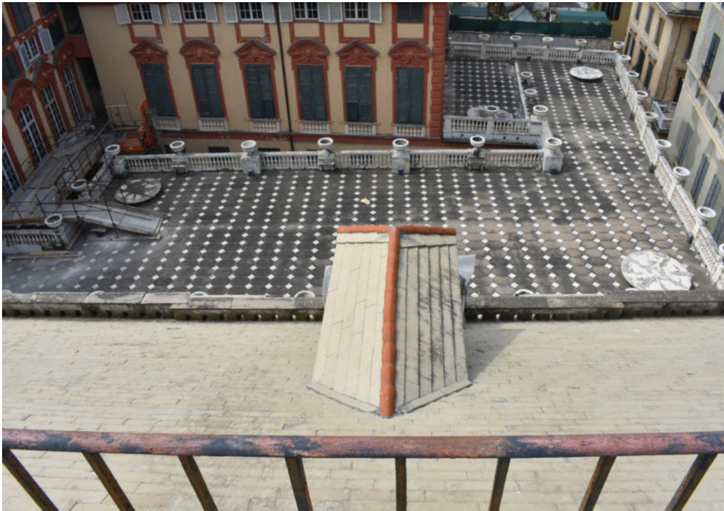
Foto 07 (falda su via Garibaldi)
