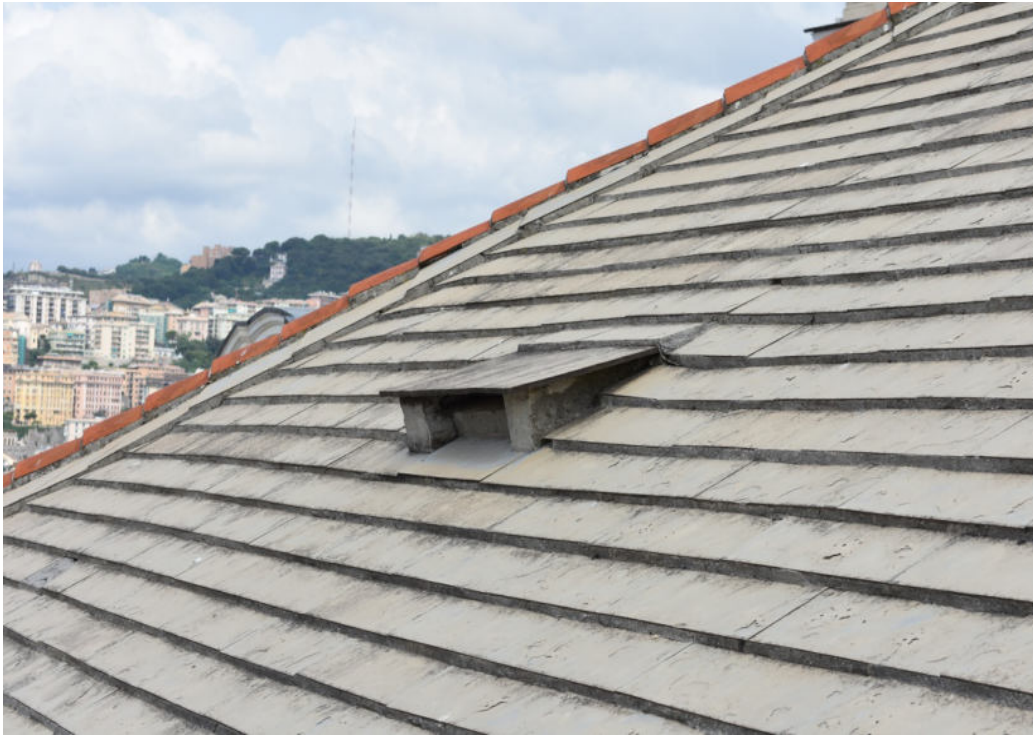
Foto 03 ( apertura per ventilazione sottotetto )
