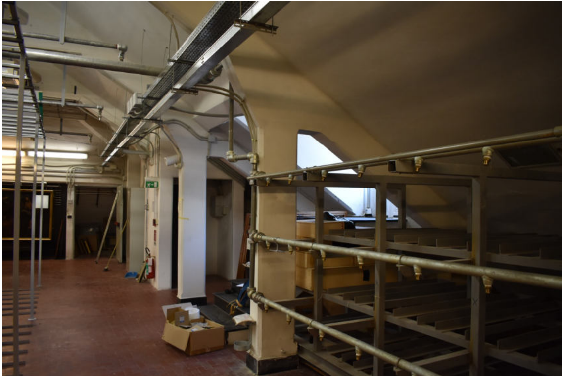
Foto 04 (sala quadreria – sottofalda lato via Garibaldi, accesso al terrazzino)
