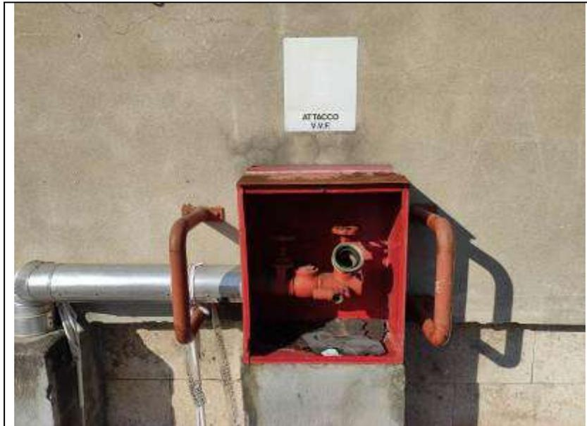
Immagine 5: attacco di mandata per VF da sostituire
