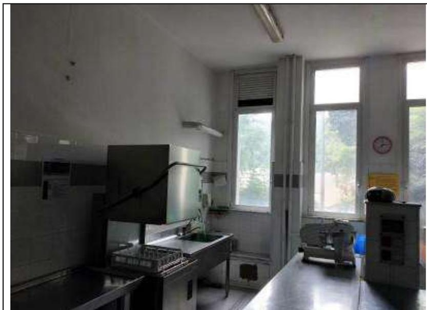
Immagine 6: locale cucina, parete da compartimentare mediante lastre in calcio silicato con grado di resistenza al fuoco pari ad EI 120
