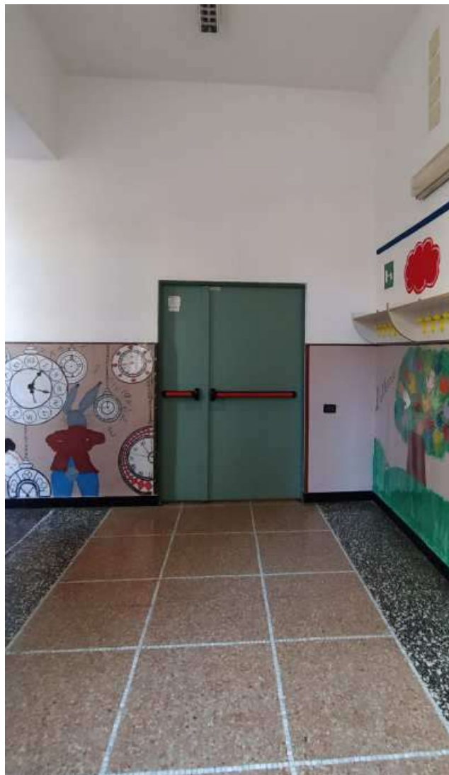
Foto 3. Piano terzo (piano tipo). Stato attuale Il corridoio dove andrà posizionato l'idrante
