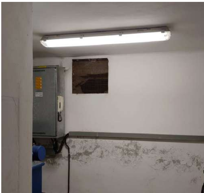
La finestrella al piano seminterrato. Nel dettaglio si vede il cordolo in c.a.
