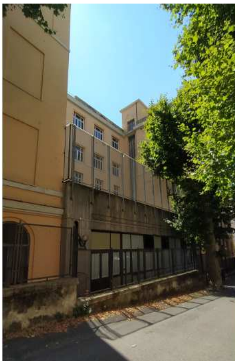
Il prospetto ovest. Si vede il corpo monopiano aggiunto negli anni '80
