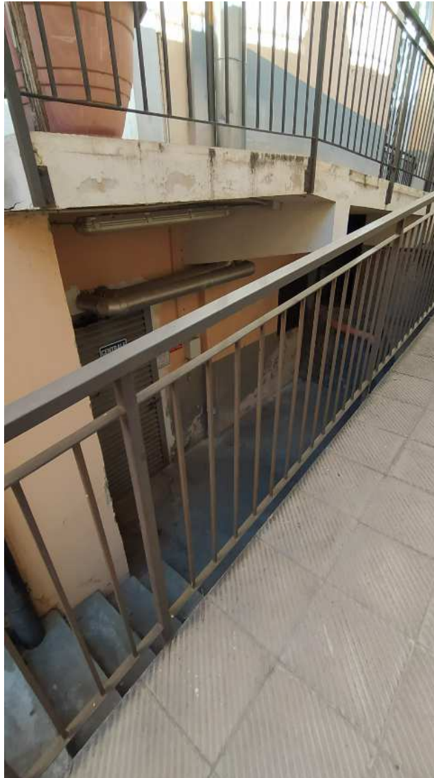
Foto 2. L'accesso alla centrale termica Stato attuale
