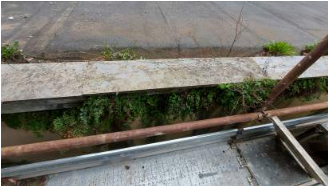
Fig. 20 – Copertine in ardesia di bordo alla copertura piana delle gallerie frontali
