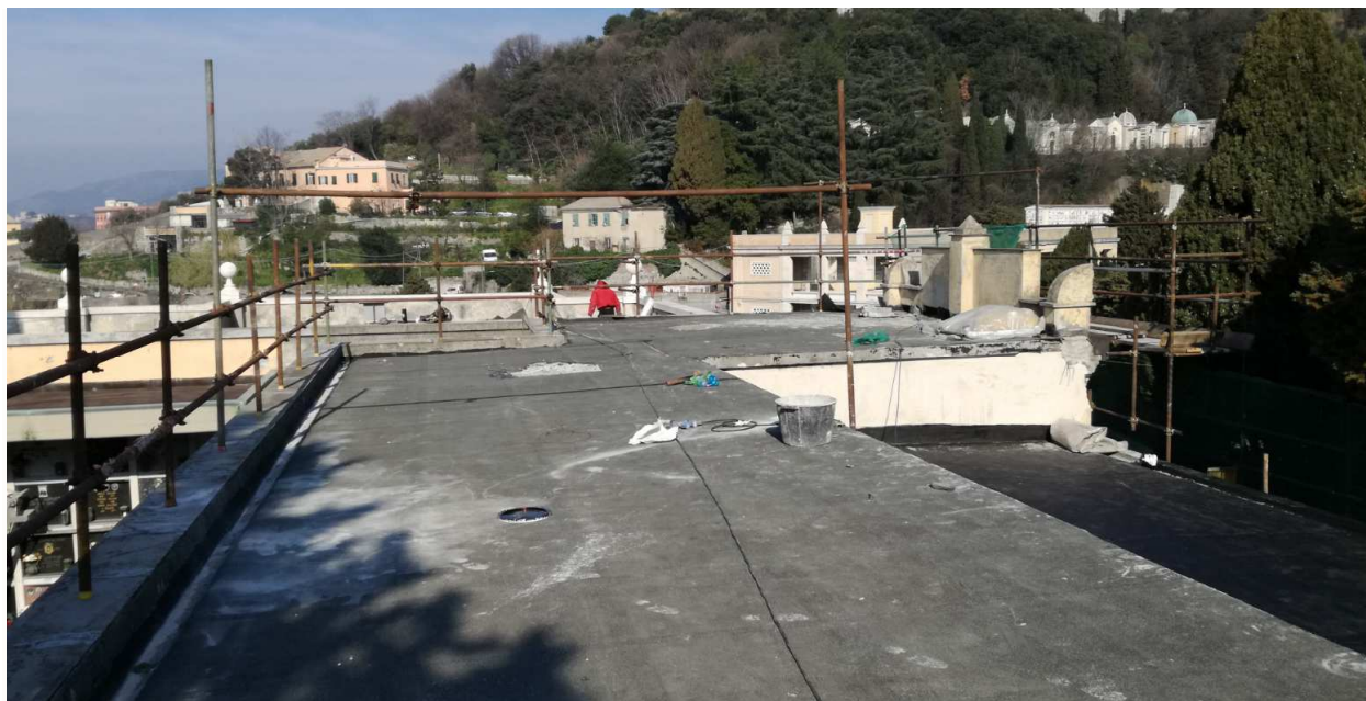
Rifacimento della copertura: foto del 3 marzo 2021
