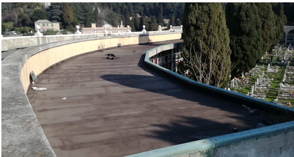
Copertura emiciclo oggetto di intervento nel lotto 2
