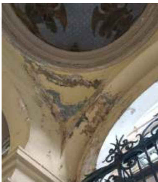
Foto 11 e 12: dettaglio degrado pennacchi e archi
