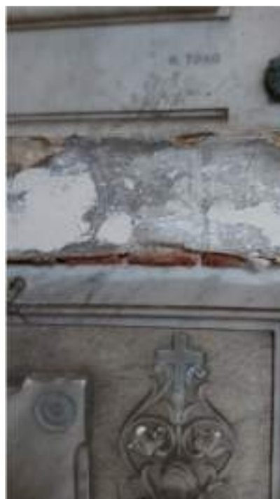
Fig. 15 – Porzioni in distacco dai corpi colombari interni
