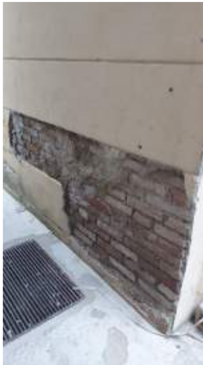
Fig. 12 – Crosta di intonaco a ricoprimento delle murature esterne delle gallerie
