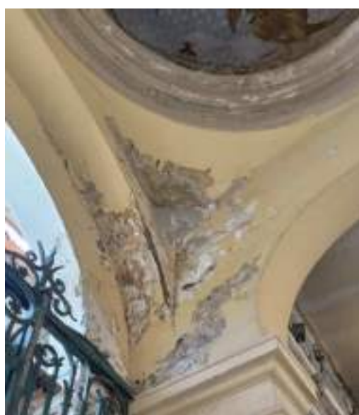
Foto 11 e 12: dettaglio degrado pennacchi e archi
