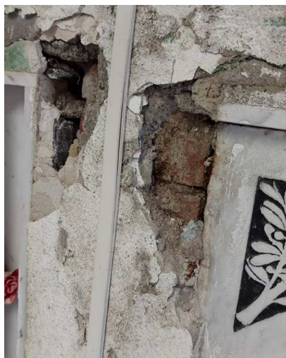
Muratura piena presente nelle parti verticali dei colombari
