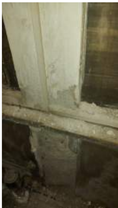
Fig. 15 – Porzioni in distacco dai corpi colombari interni
