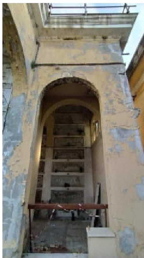
Foto 23 e 24: accesso interno di Levante alla galleria
