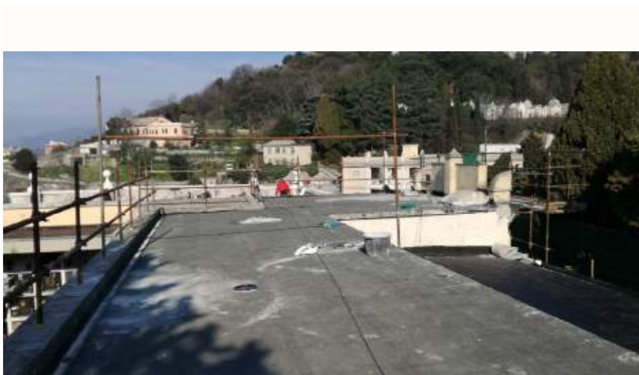
Rifacimento della copertura: foto del 3 marzo 2021
