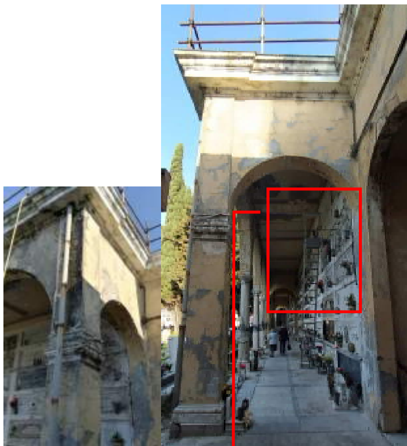
Foto 25: Porticato visto da Sud Est
