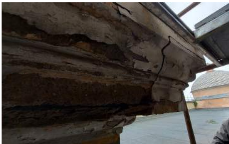
Fig. 19 – Cornicione esterno ala sinistra levante ingresso
