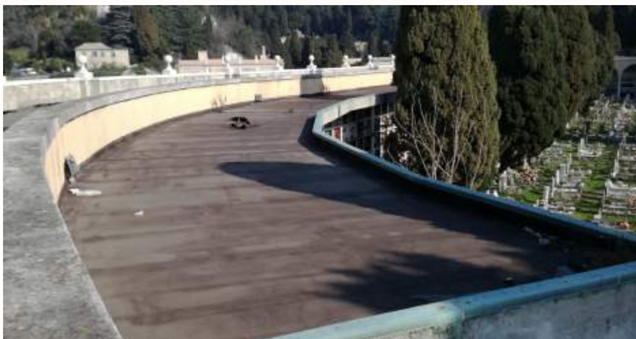
Copertura emiciclo oggetto di intervento nel lotto 2
