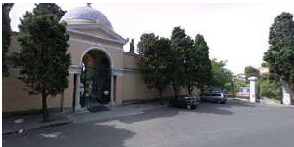
Foto ingresso principale da Via Porta degli Angeli (da Google maps 2008)
