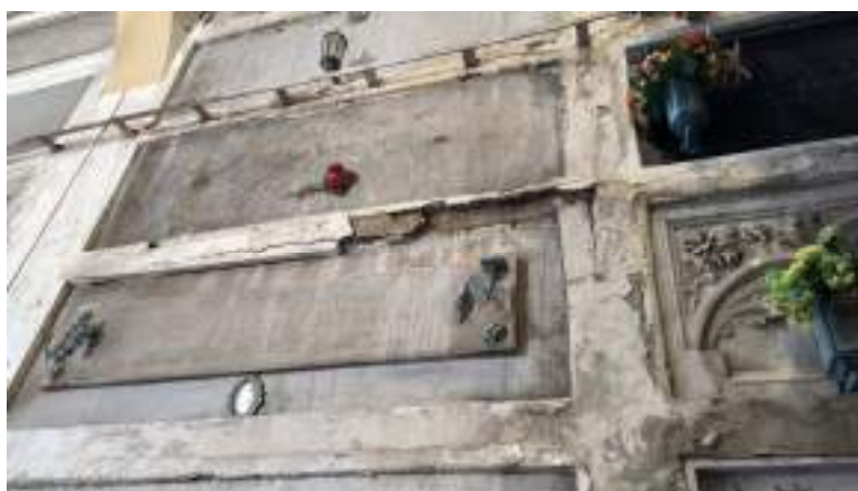
Dettaglio lapide e "frontalino" in fase di distacco
