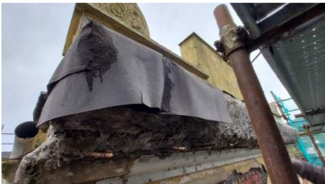
Vista del cornicione esistente della galleria frontale lato Ponente
