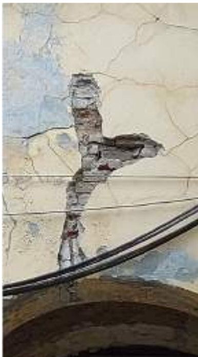
Punto di indagine per visionare l'arco murario del loggiato lato ponente
