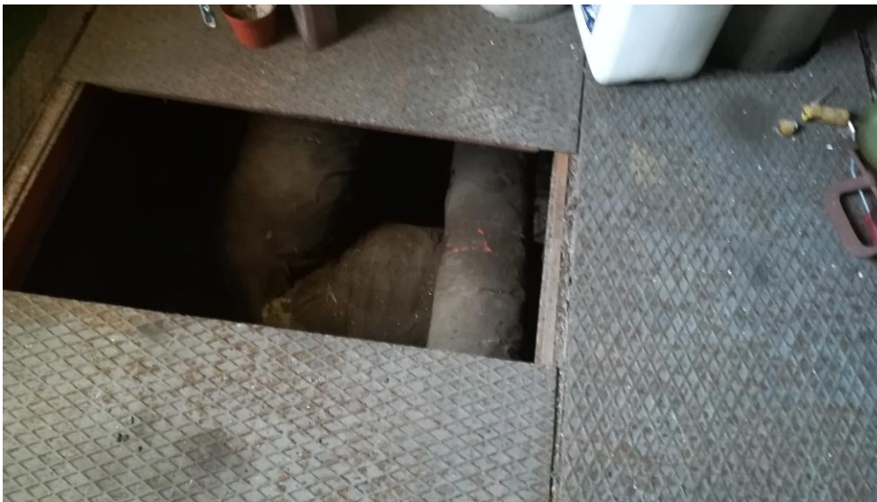
Figura 4 – Tubazioni sotto la pavimentazione
