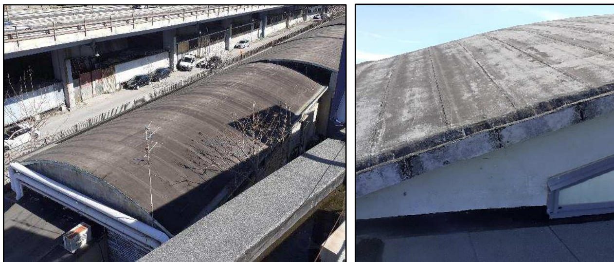
Figura 7: foto rappresentanti le tipologie di copertura dei tetti, rispettivamente dell'edificio M a sinistra e del padiglione C a destra
