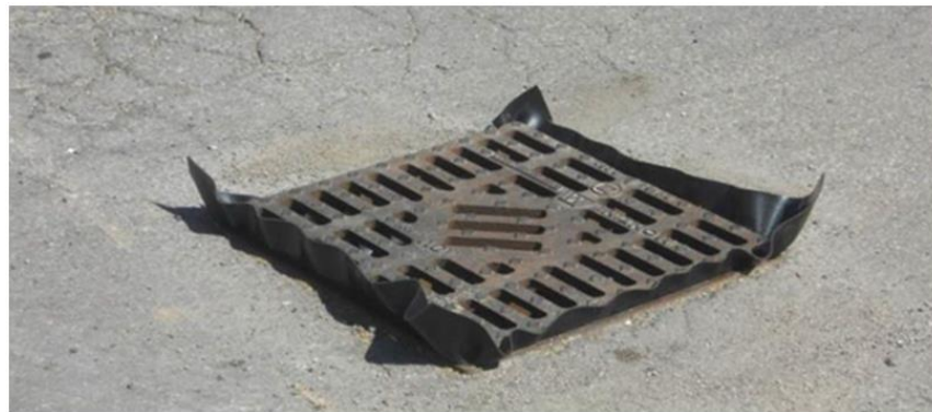
Figura 2 – Esempio di chiusura di pozzetto con telo HDPE
