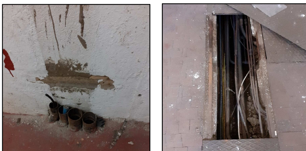
Figura 8: foto esemplificative della tipologia di servizi interrati rinvenuta durante il sopralluogo
