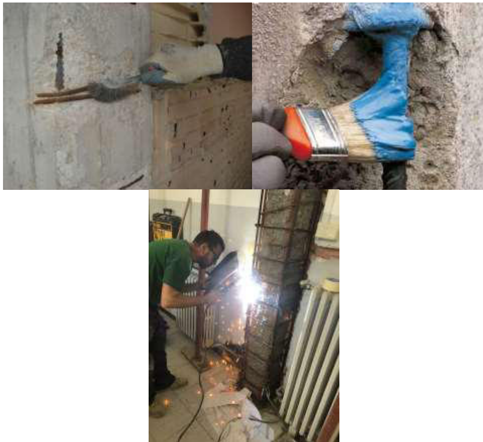
Figura 4 - Fasi di consolidamento opere in c.a.
