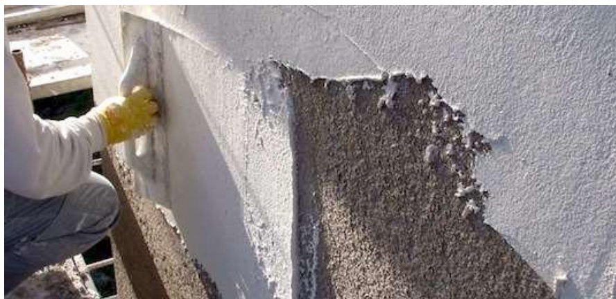
Figura 3 - Fasi di intonacatura e finitura
