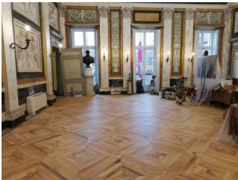
Figura 11 – restauro pavimentazioni a parquet
