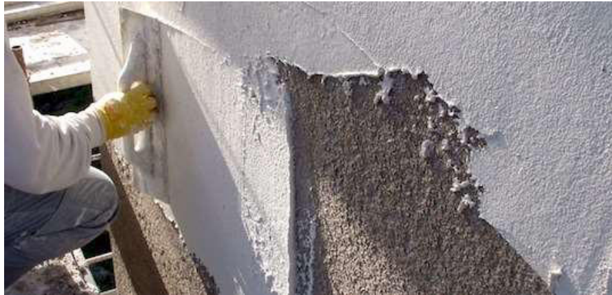
Figura 6 - Fasi di intonacatura e finitura
