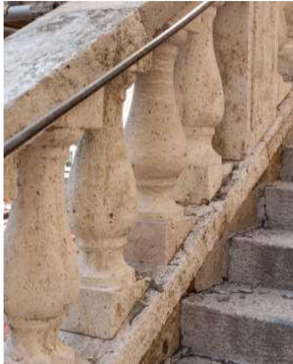
Figura 12 – restauro elementi lapidei
