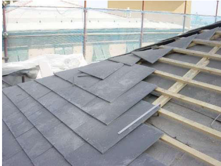
Figura 2: Particolare copertura inclinata in ardesia alla genovese
