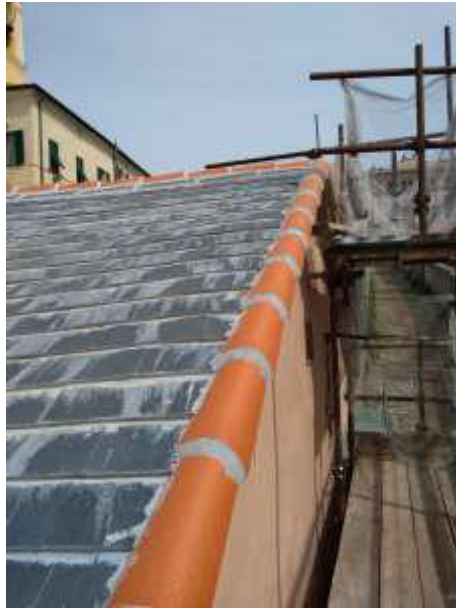
Figura 4 - Particolare copertura inclinata in ardesia alla genovese
