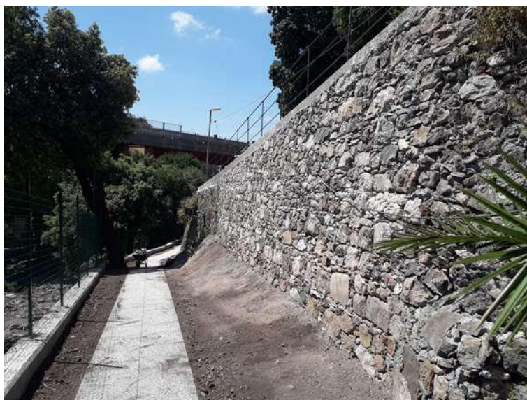
Esempio di muro in pietra realizzato con precedente AQ
