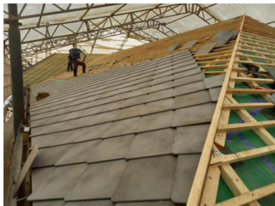
Ripristino e/o rifacimento di coperture
