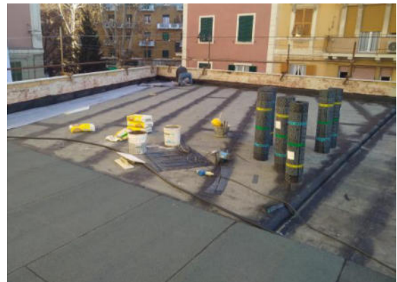
Revisione impermeabilizzazione coperture piane
