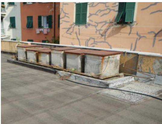
Rifacimento impianti di accumulo
