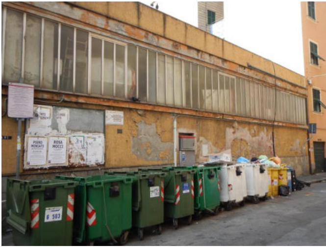
Ripristino intonaci ammalorati
