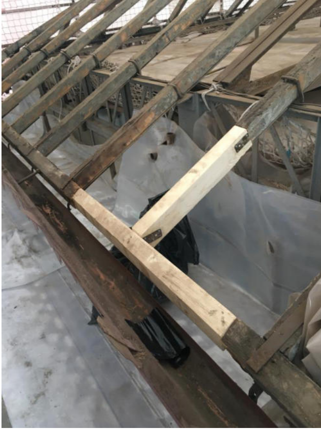
Ripristino elementi orditura lignea
