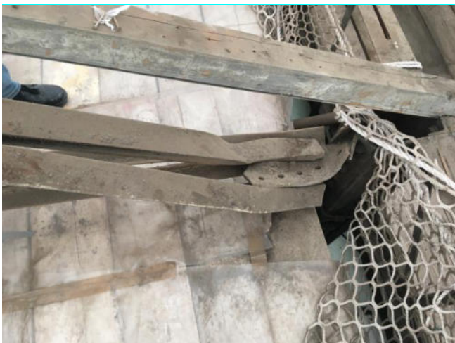
Ripristino capriate in ferro
