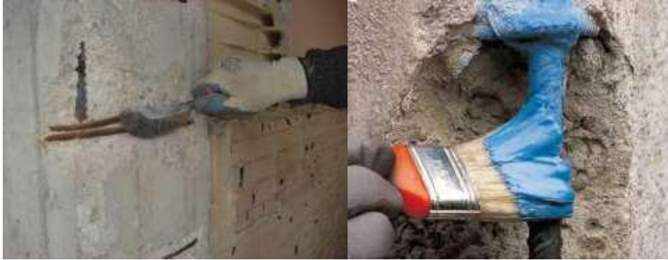
Figura 4 - Fasi di consolidamento opere in c.a.
