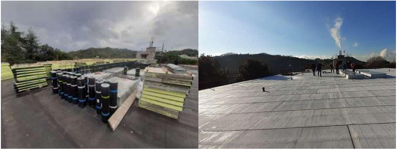
Figura 2: esempio intervento copertura
