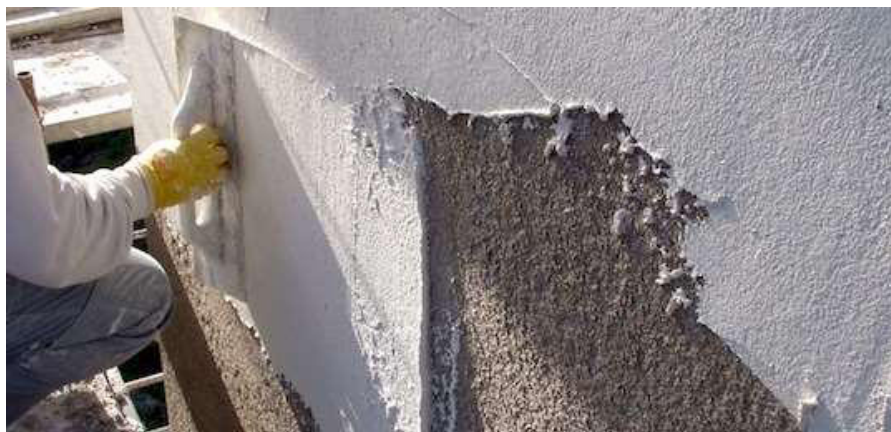
Figura 3 - Fasi di intonacatura e finitura
