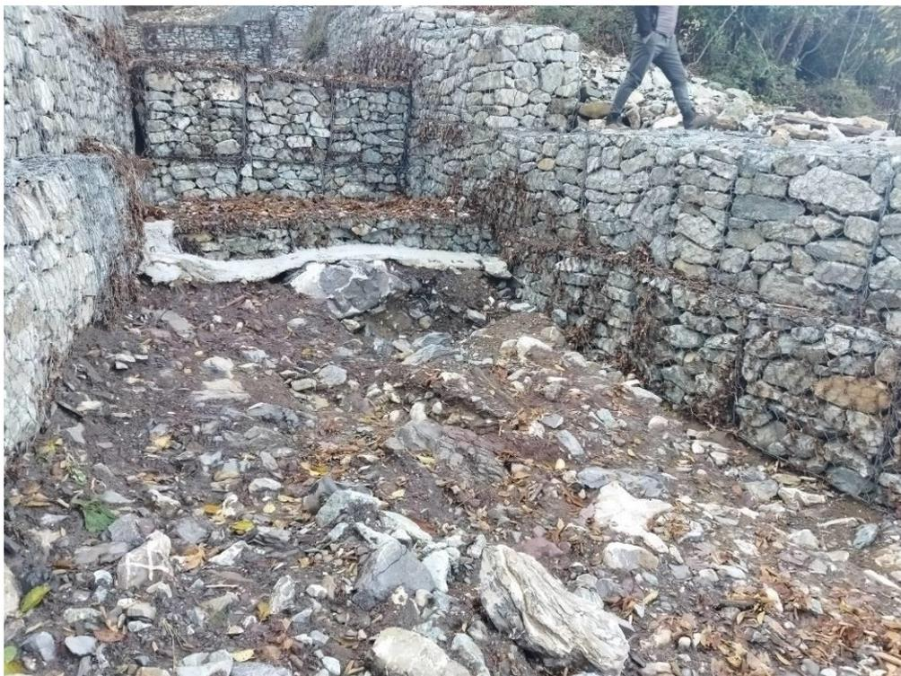
**Foto 3: zona di confluenza Rio Bruscio a formare Rio Rosata. Si notano principi di erosione e la pezzatura grossolana dei blocchi trasportati dalla corrente**
