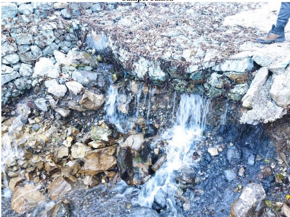
**Foto 7: erosione d'alveo laddove non protetto con materasso di gabbioni**
