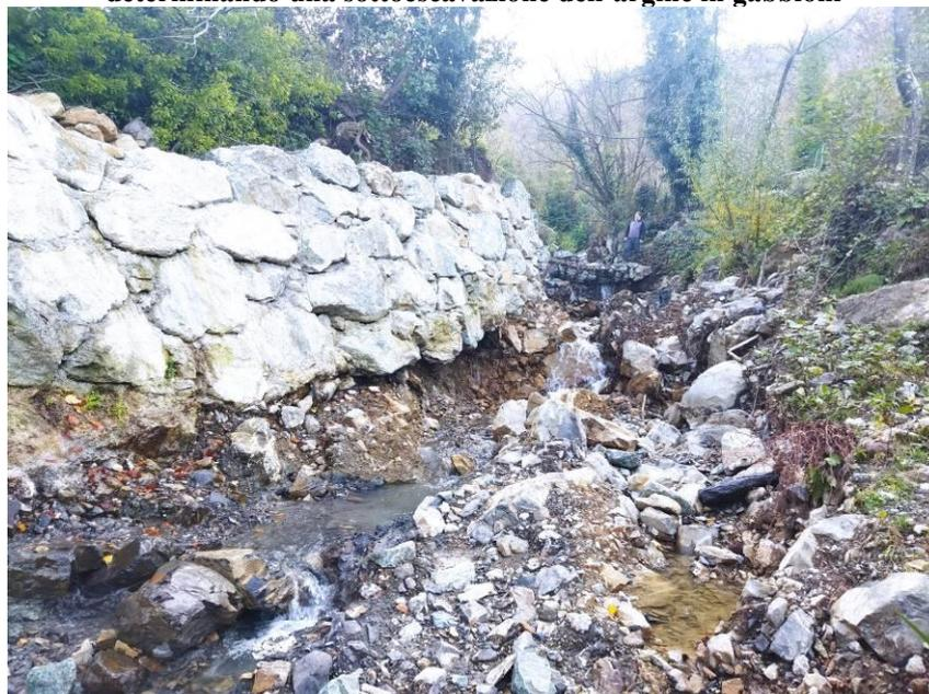
**Foto 9:** da foto precedente verso valle. L'erosione procede interessando anche la scogliera in sponda destra, estinguendosi nel tratto supianeggiante di alveo.
