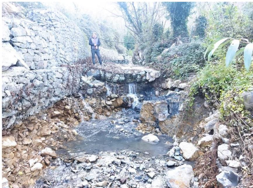
**Foto 8:** appena a valle da foto precedente. L'erosione ha asportato circa 1 metro di alveo determinando una sottoescavazione dell'argine in gabbioni
