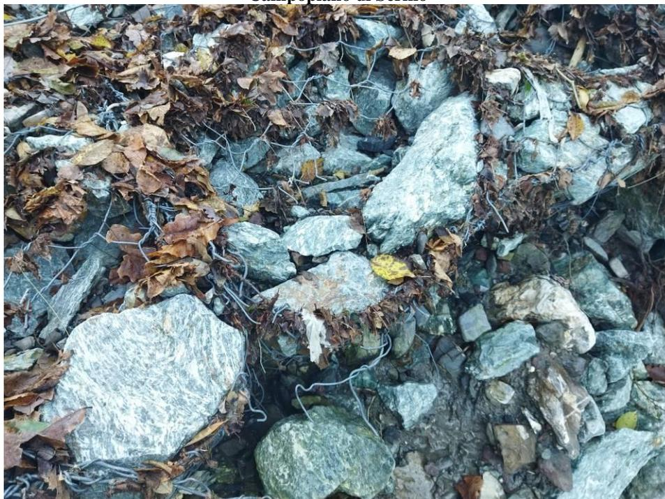
**Foto 5: dettaglio di rottura filo zincato del gabbione a seguito di urti con materiale solido grossolano ad opera della corrente**
