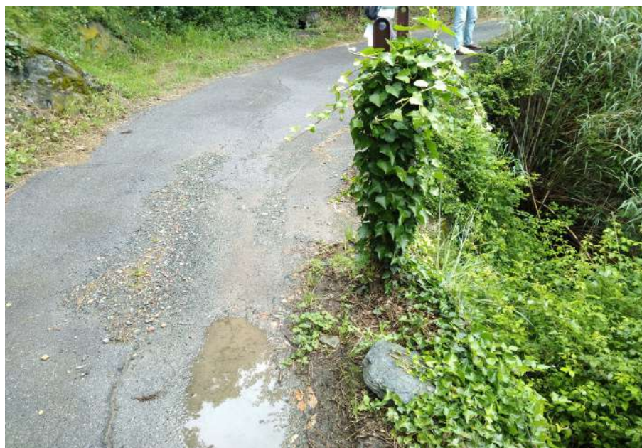
INTERVENTO 4 - Veduta tratto oggetto di intervento
