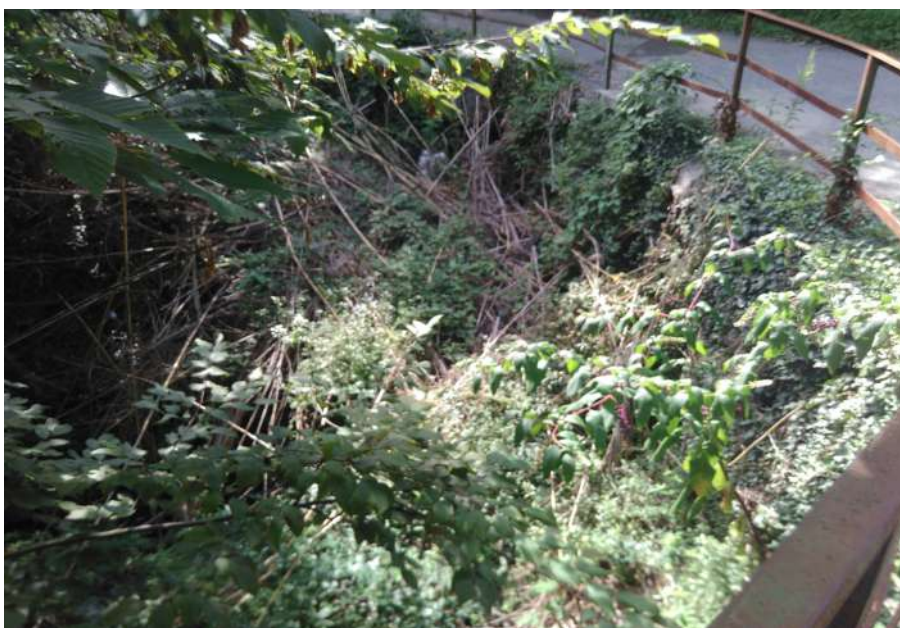
INTERVENTO 5 - Veduta tratto oggetto di intervento
