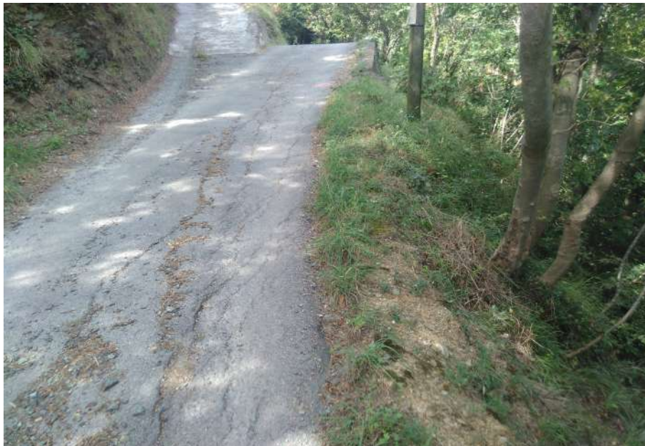
INTERVENTO 3 - Vedute tratti oggetto di intervento
