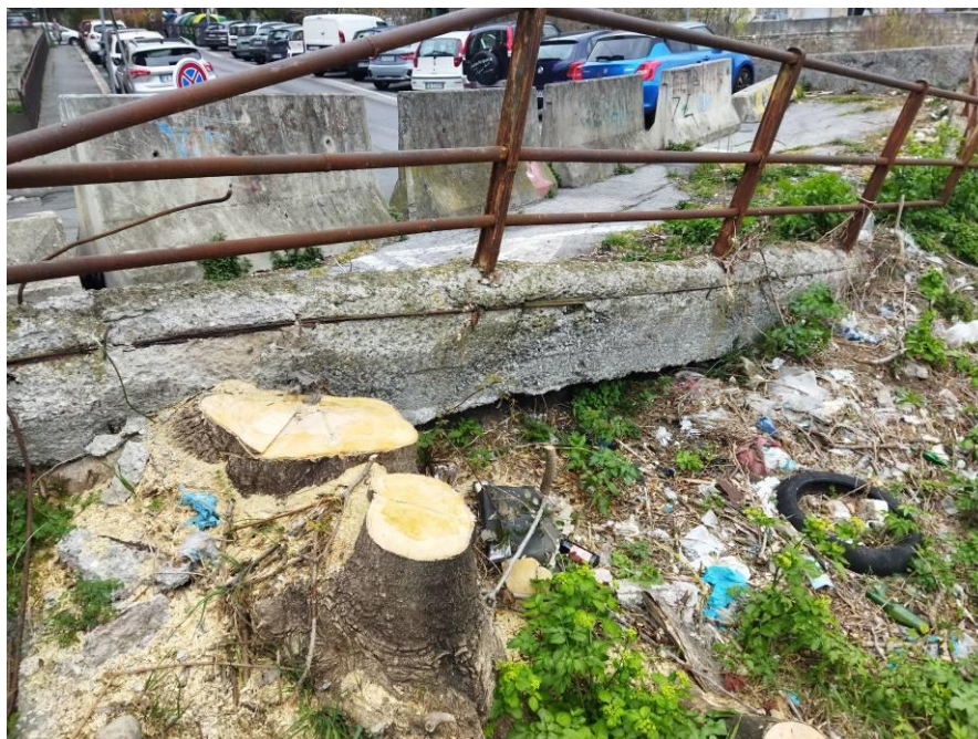
Foto 5: dettaglio di foto precedente. Sullo sfondo via Gavoglio e la delimitazione con new jersey. Prime attività di taglio e pulizia vegetazionale, propedeutiche al rilievo planoaltimetrico
