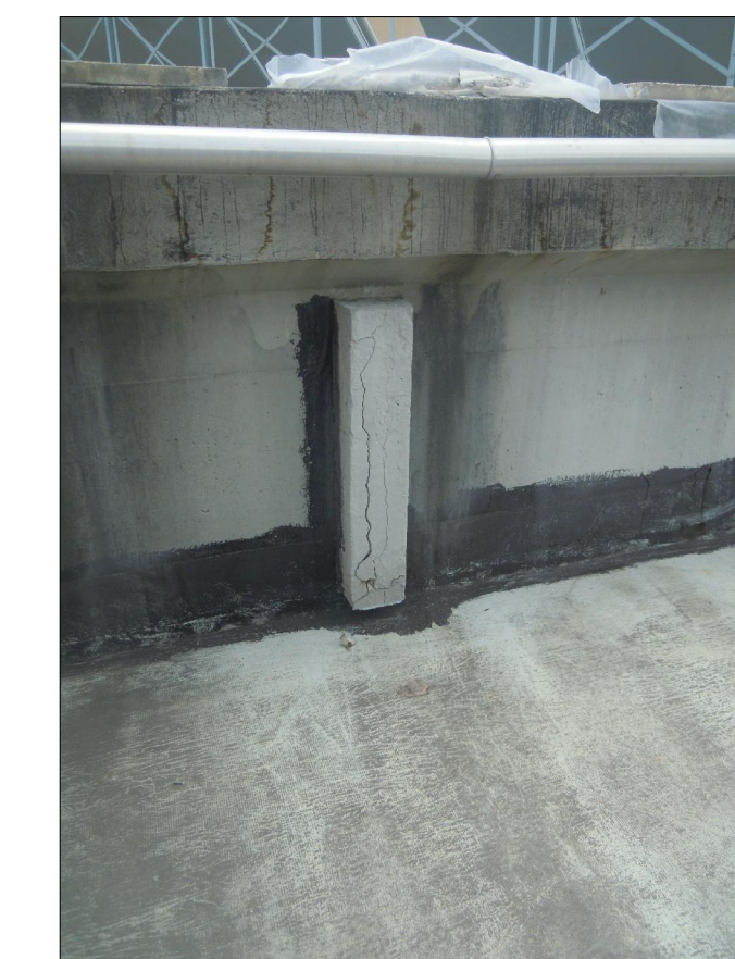
Ripristino Cls ammalorato: travi di irrigidimento trasversali
