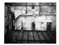
Al di sopra del solaio in legno, negli anni 60 è stato realizzato un nuovo solaio in ferro, che assolve alla funzione di sostenere i carichi dell'estradosso, escludendo da tale funzione il sottostante solaio in legno originario. Le travi in ferro principali sono poggiate sulle murature perimetrali longitudinali
