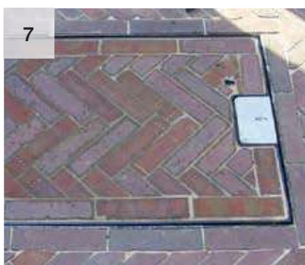
Riempimento della copertura per l'adattamento all'ambiente circostante.
