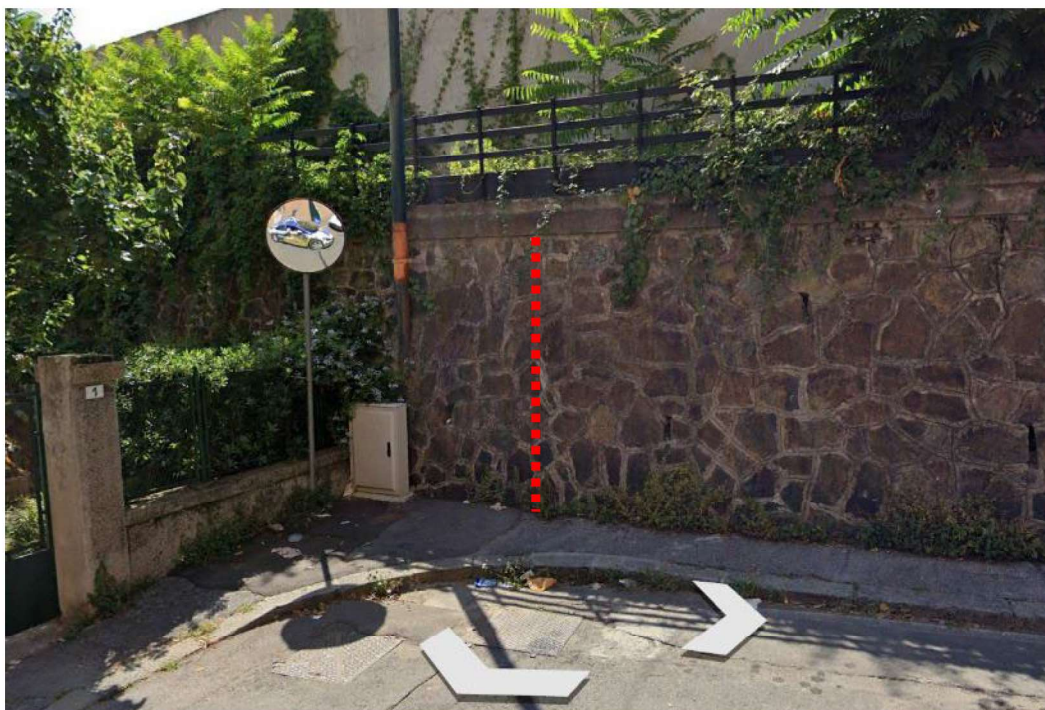
Figura 3.7: Vista frontale sezione di indagine n. 3 (S03)
