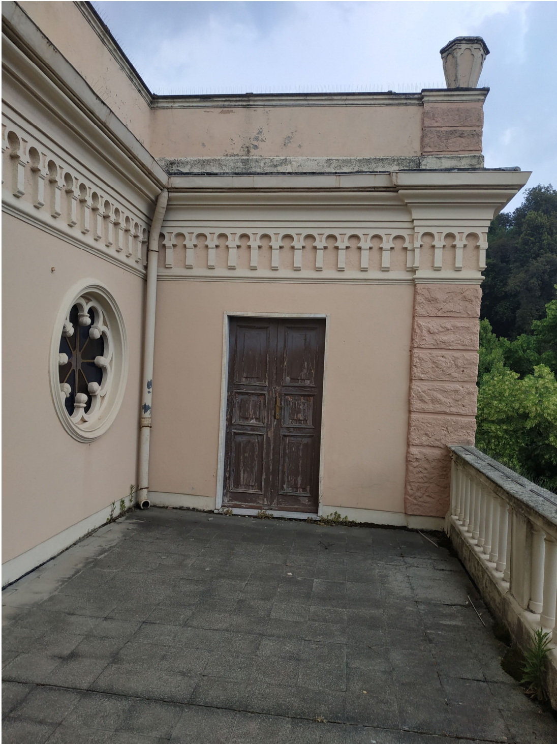
Foto n. 22 – Terrazzo secondo piano lato est
