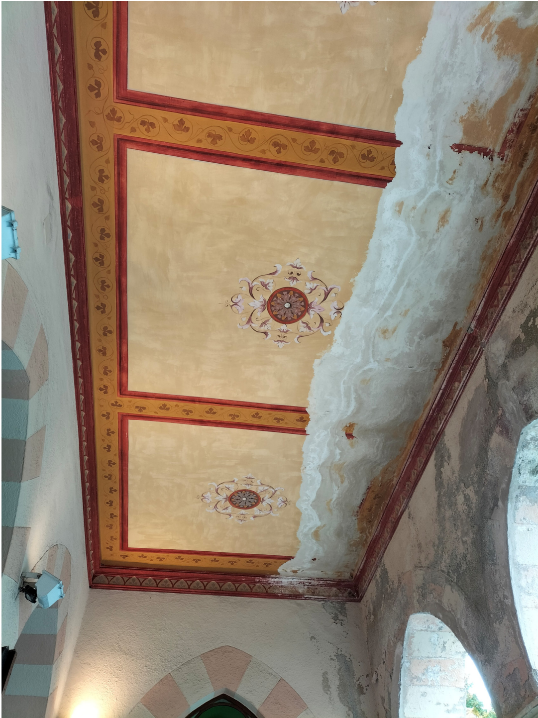
Foto n. 16- Piano primo: arcate e soffitto loggia
