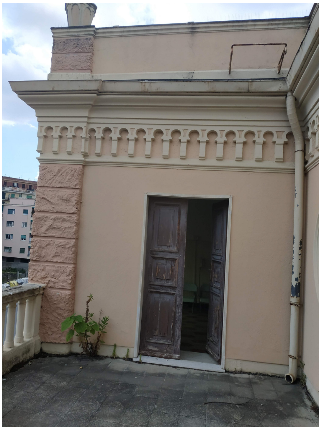
Foto n. 44 – Terrazzo secondo piano lato est
