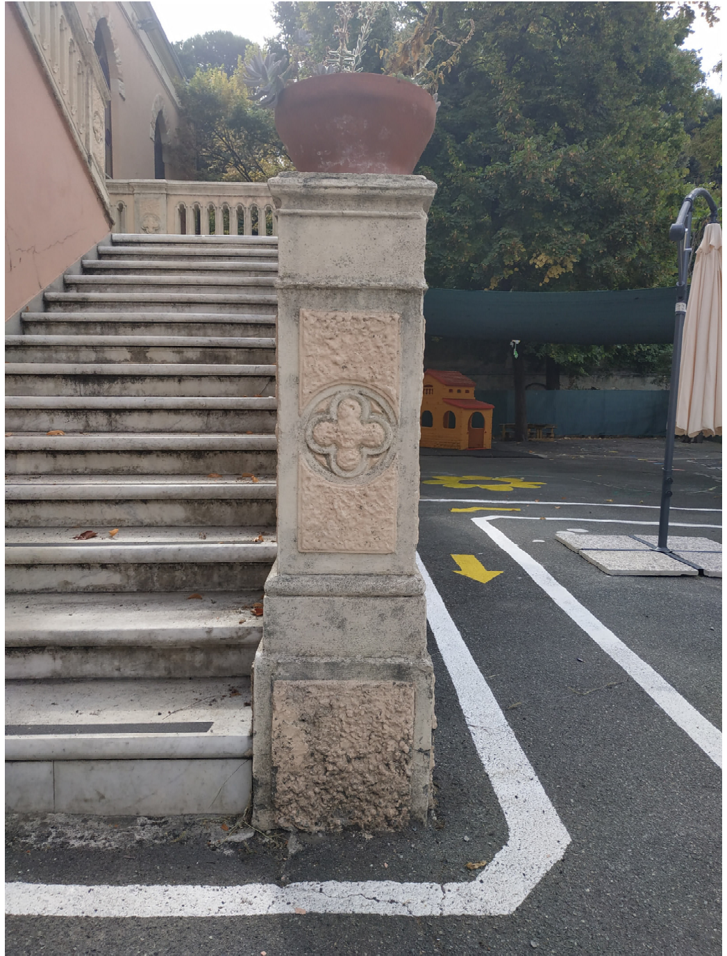
Foto n. 34 – Dettaglio scala esterna
