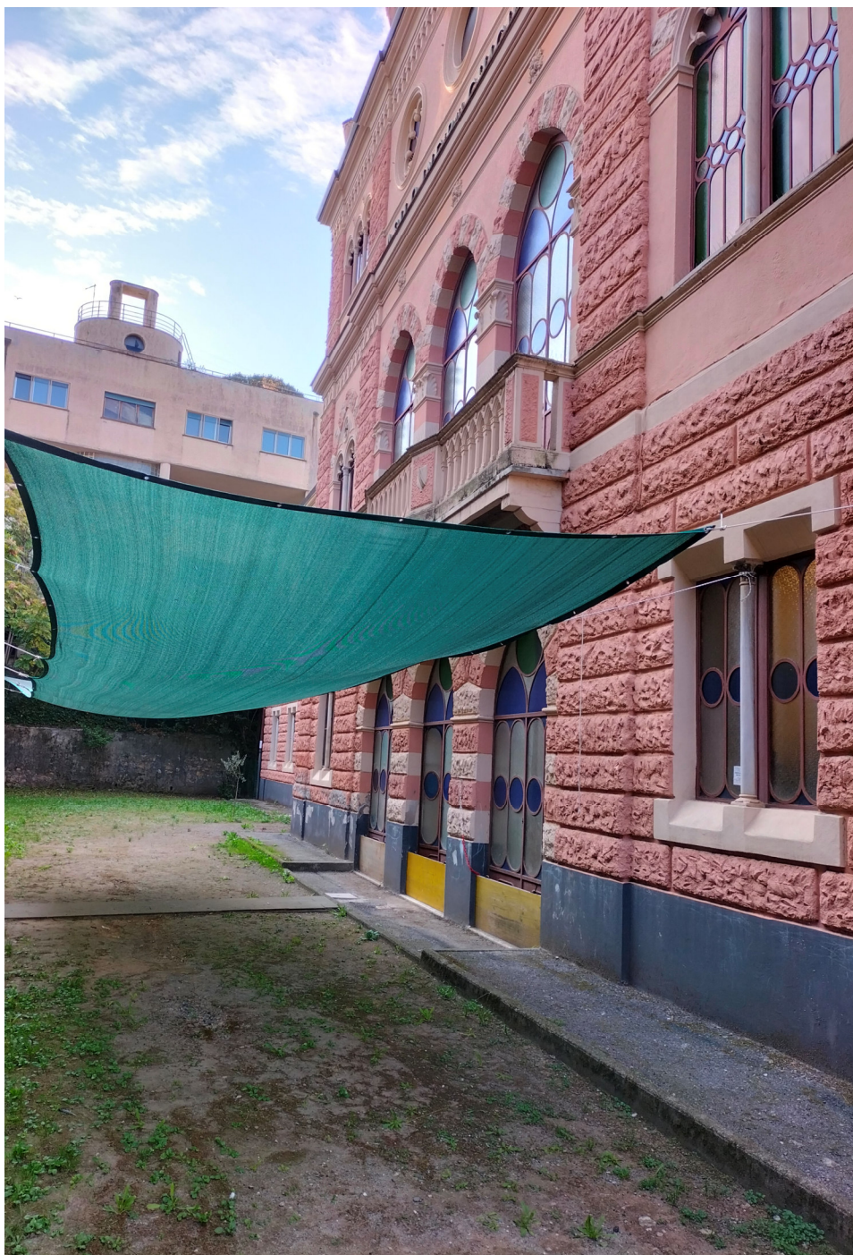
Foto n. 10 - Piano terreno: pavimentazione esterna dove è previsto ampliamento
