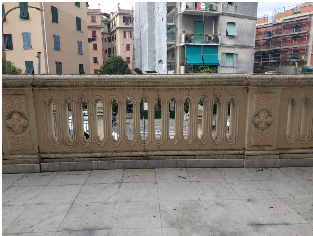
Foto n. 19 – Parapetto pianerottolo primo piano
