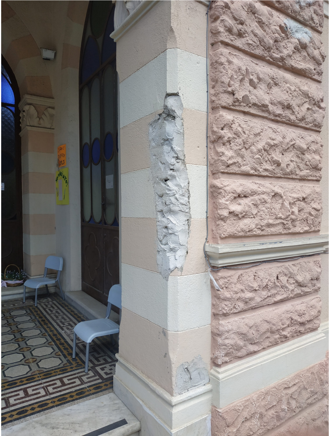
Foto n. 39 - Loggia piano primo
