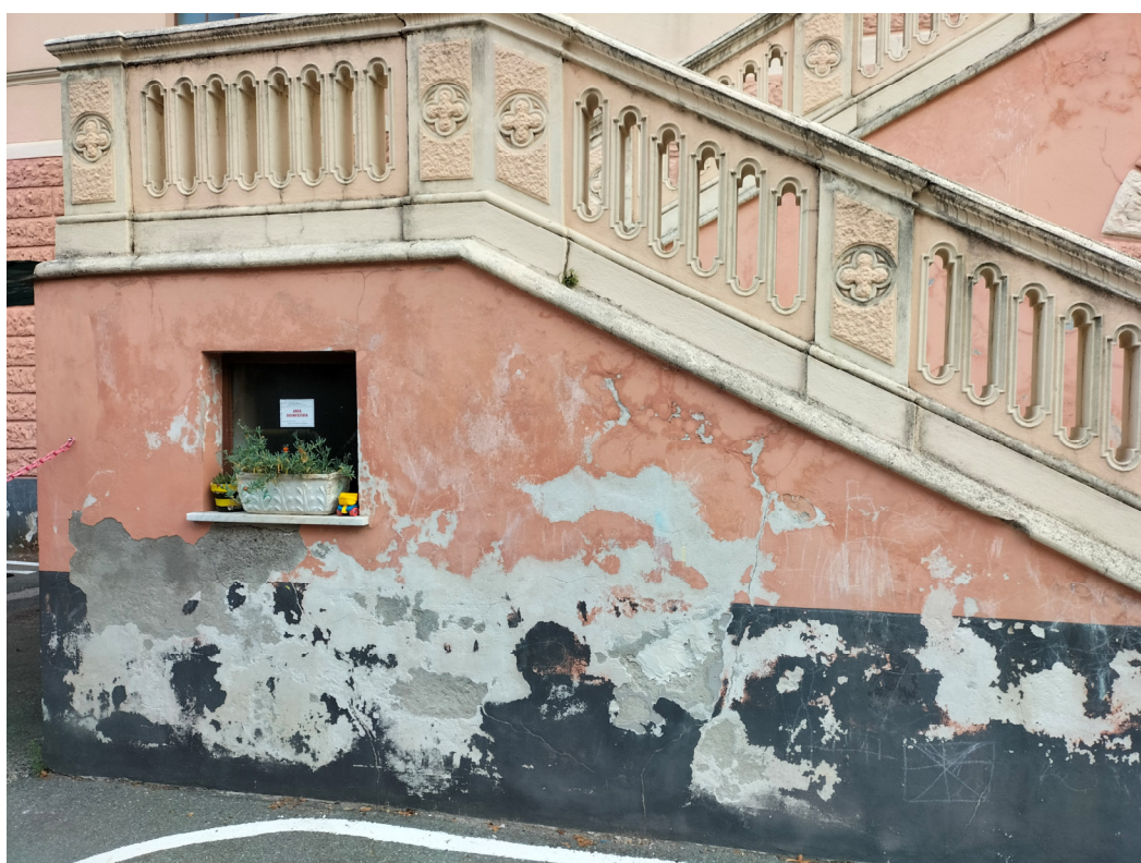
Foto n. 29 e 30- Dettaglio pareti vani scala rampe esterne
