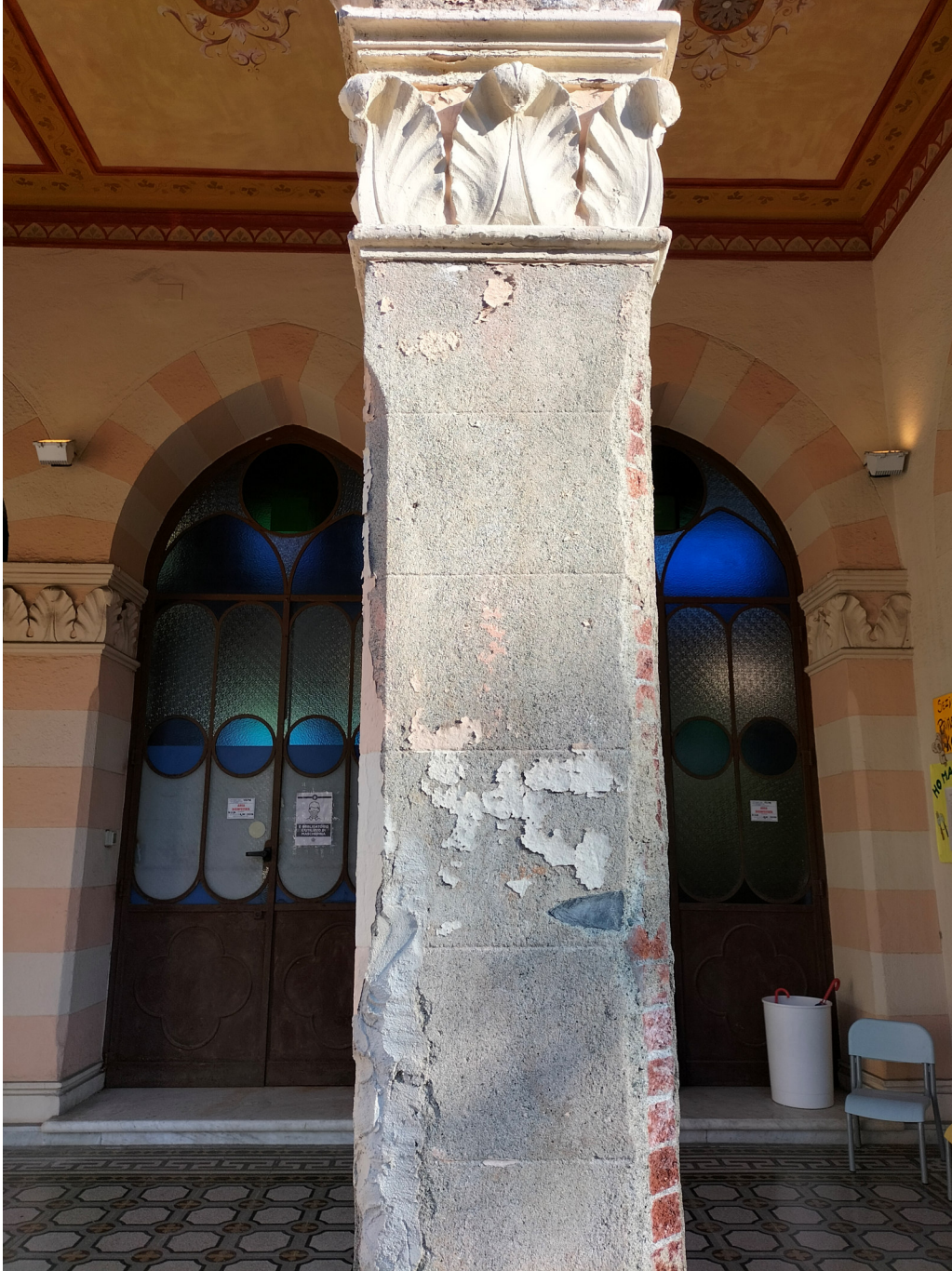
Foto n. 12 - Particolare colonna loggia piano primo
