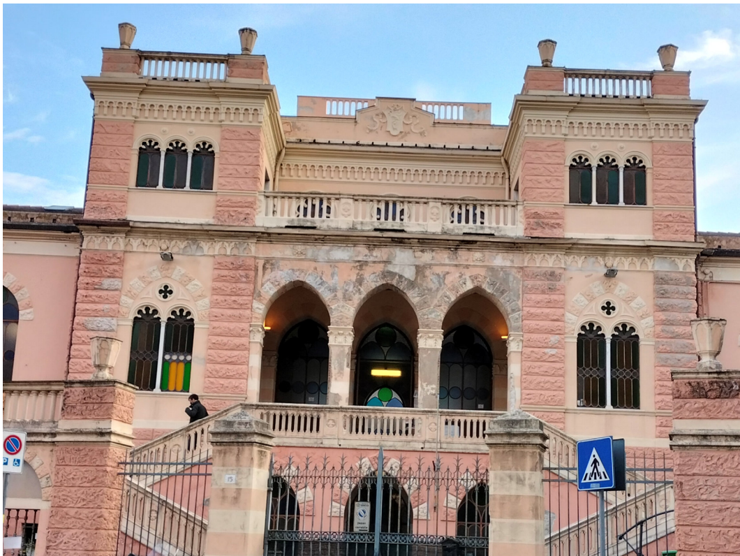
Foto n. 24 e n. 25 – Prospetto principale: porzione di facciata oggetto di intervento
