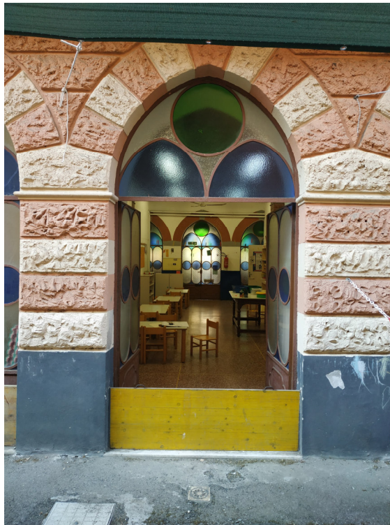
Foto n. 8 – 9 Piano terreno: aula 3 (attuale) Refettorio (progetto) – Serramento esistente a cui verrà affiancato nuovo serramento vetrato
