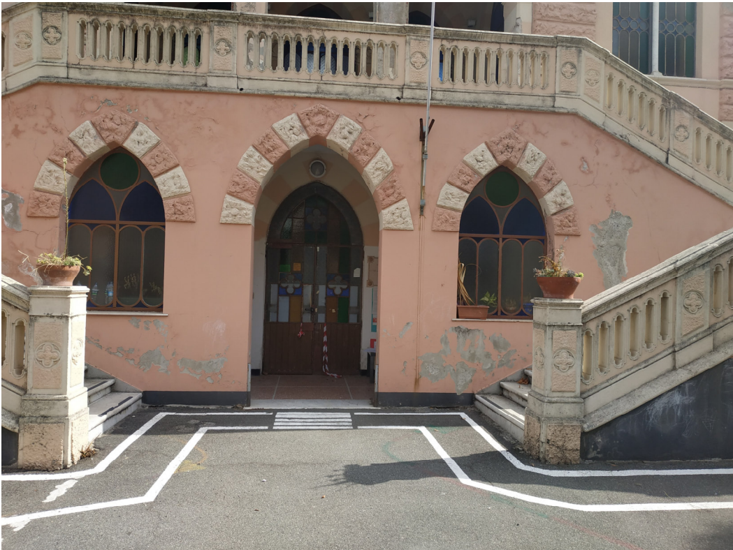
Foto n. 26 e n. 27 – Portico di ingresso e dettaglio terrazzo soprastante
