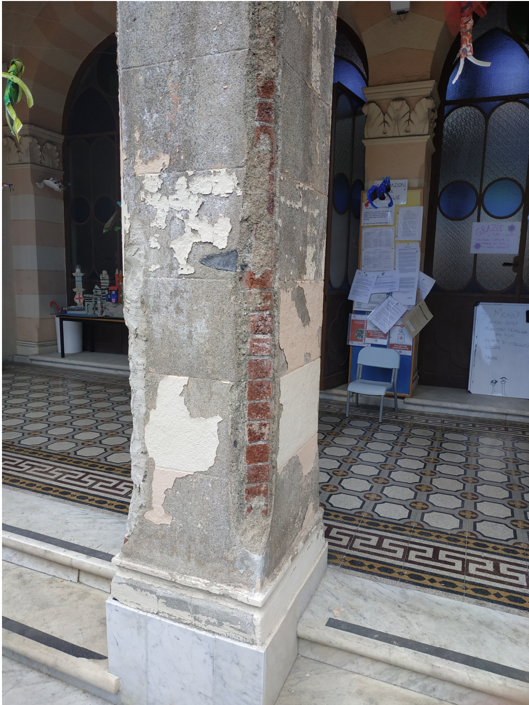
Foto n. 40 - Loggia piano primo
