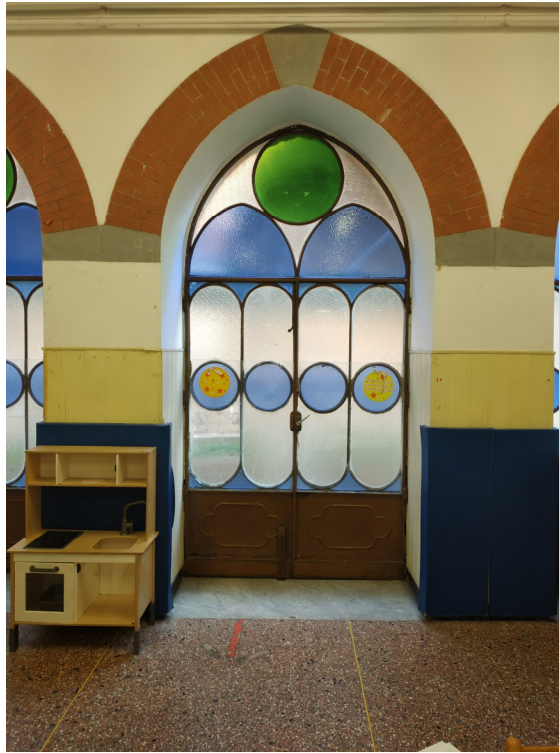
Foto n. 8 – 9 Piano terreno: aula 3 (attuale) Refettorio (progetto) – Serramento esistente a cui verrà affiancato nuovo serramento vetrato
