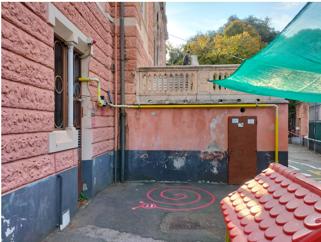
Foto n. 31 e n. 32 – scala esterna
