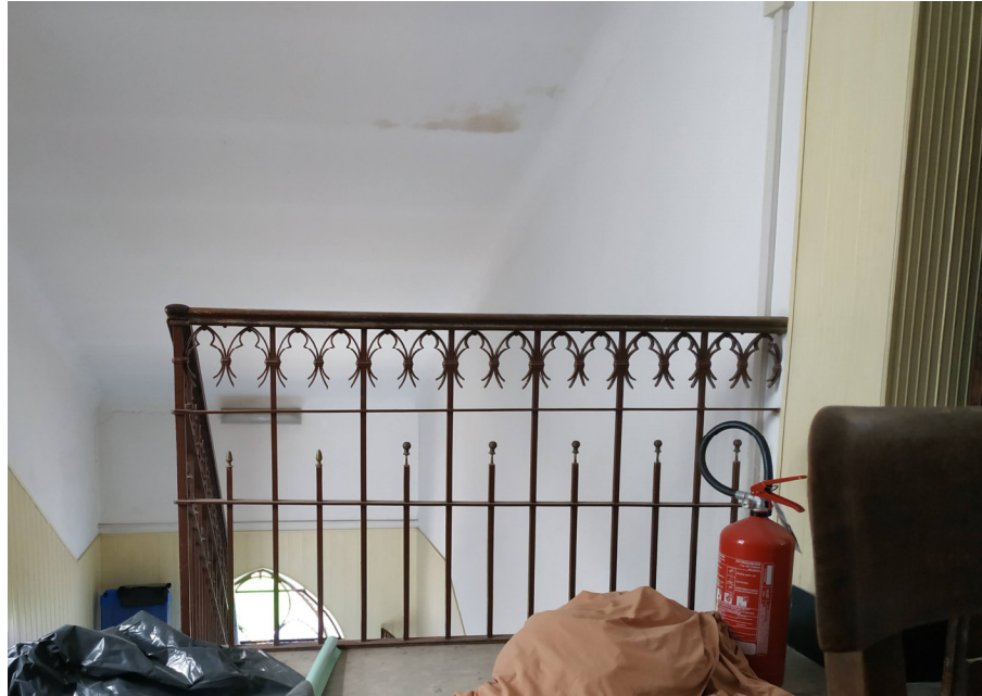
Foto n. 16 - 17 – Ringhiera che dovrà essere sopraelevata
