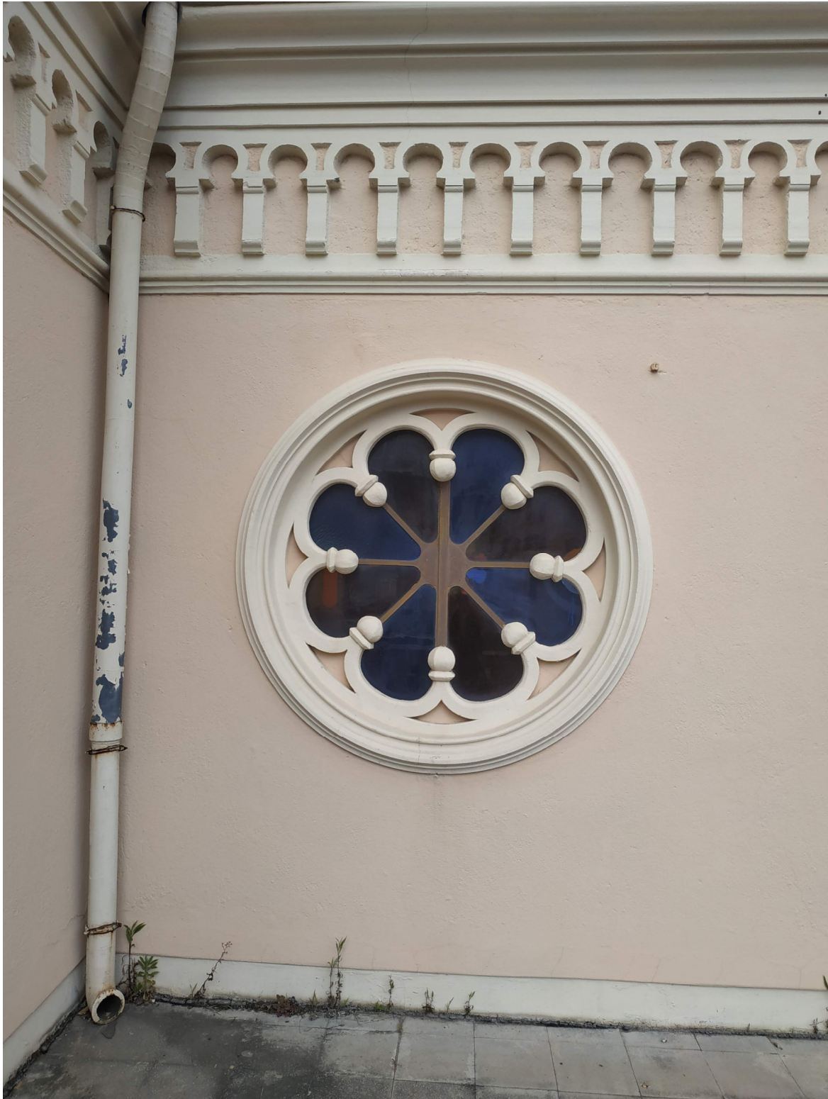
Foto n. 45 – Terrazzo secondo piano lato ovest
