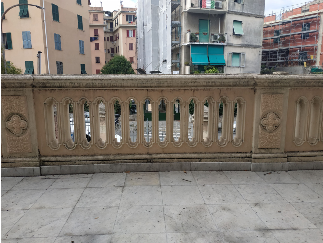
Foto n. 35 – Parapetto pianerottolo primo piano
