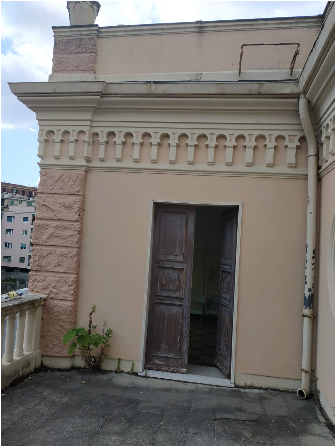
Foto n. 23 – Terrazzo secondo piano lato est
