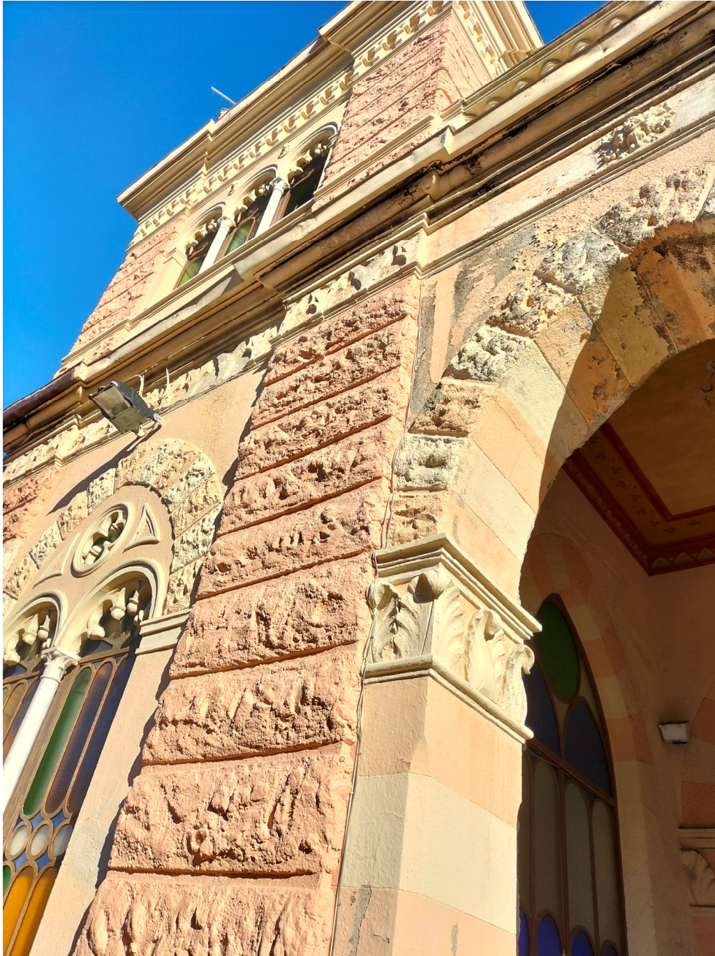
Foto n. 11 - Particolare prospetto principale
