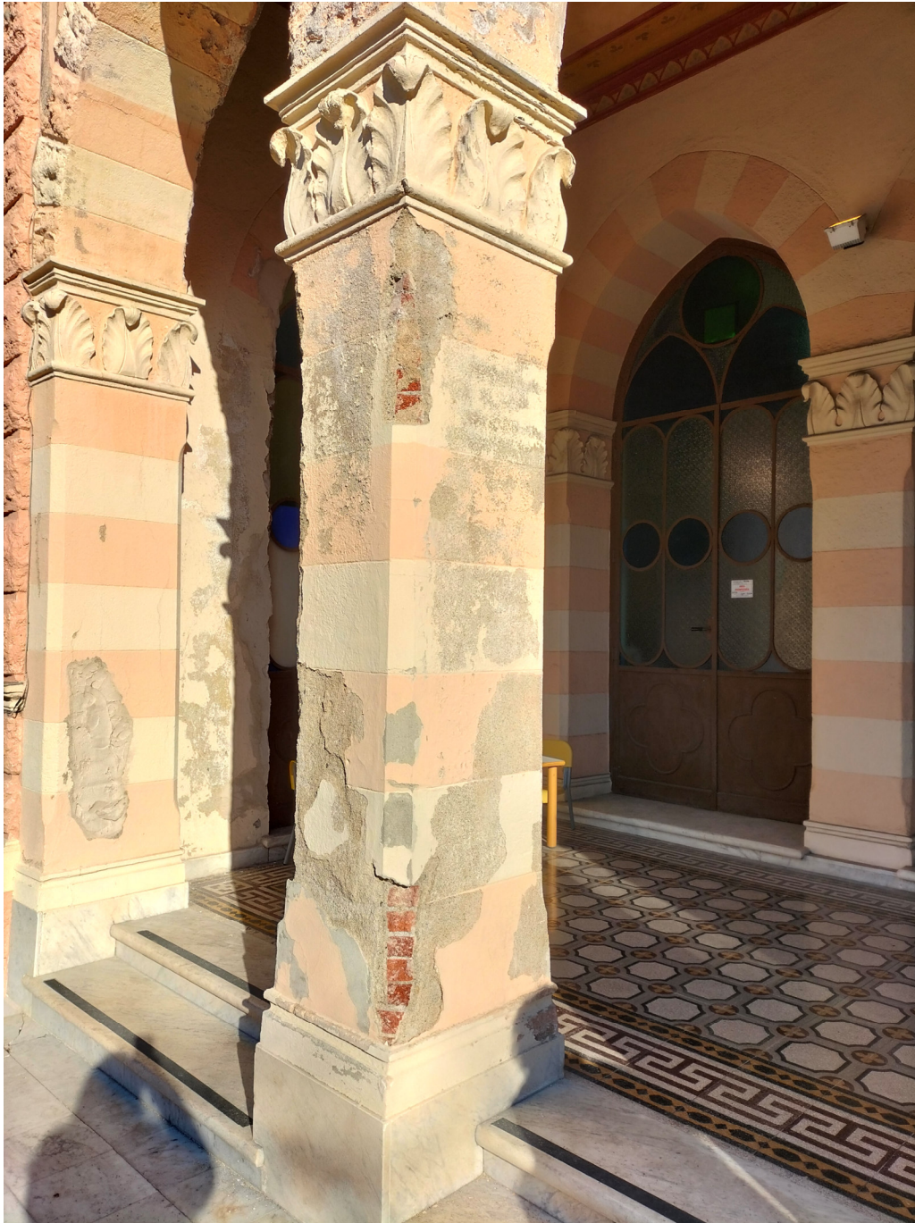
Foto n. 13 - Particolare colonne loggia piano primo
