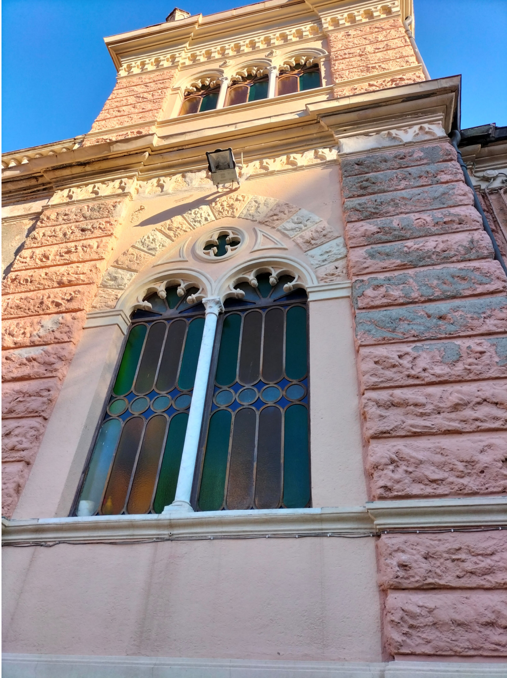
Foto n. 10 - Particolare prospetto principale
