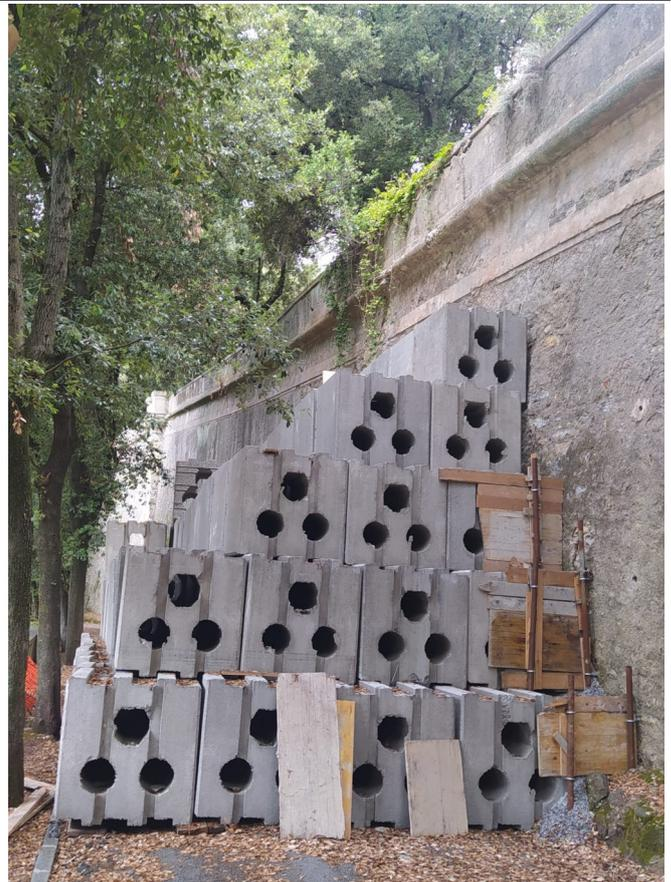
Foto 1-2: stato pre-lavori (spanciamento e lesioni senza protezione, e successiva posa di blocchi provvisionali)
