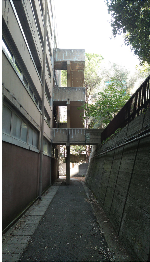
PROSPETTO NORD-SCALA DI SICUREZZA ALA OVEST
