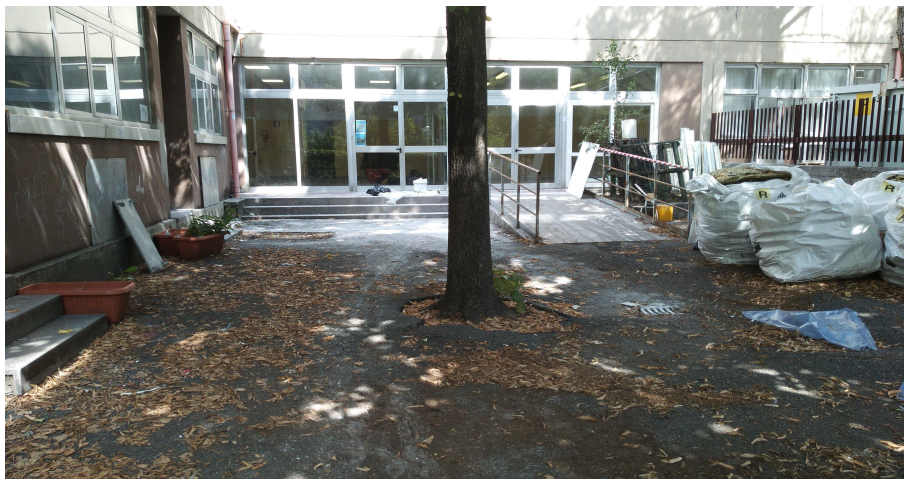
Vista dell'area di cantiere
