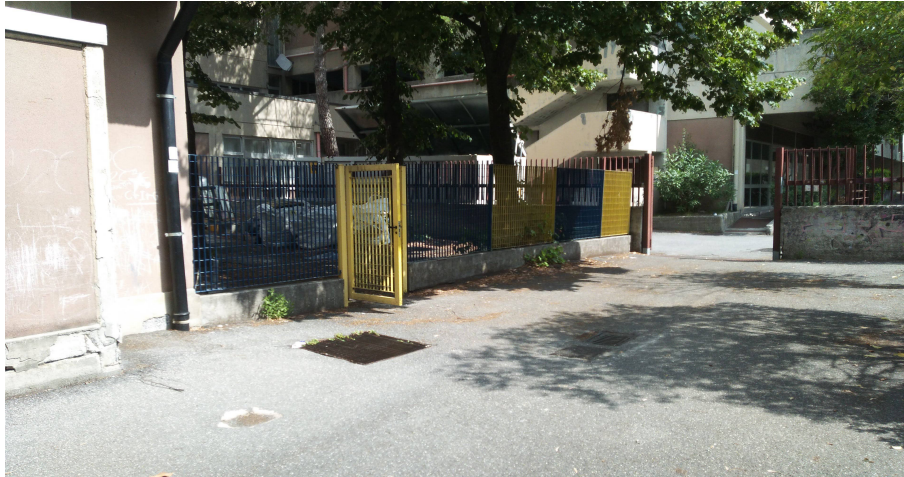
Vista dell'area di cantiere
