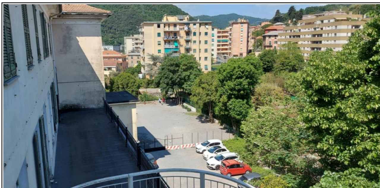
Foto 2: Vista dall'alto dell'area di intervento
