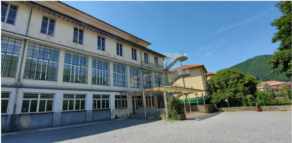
Fig. 8: Veduta prospetto nord
