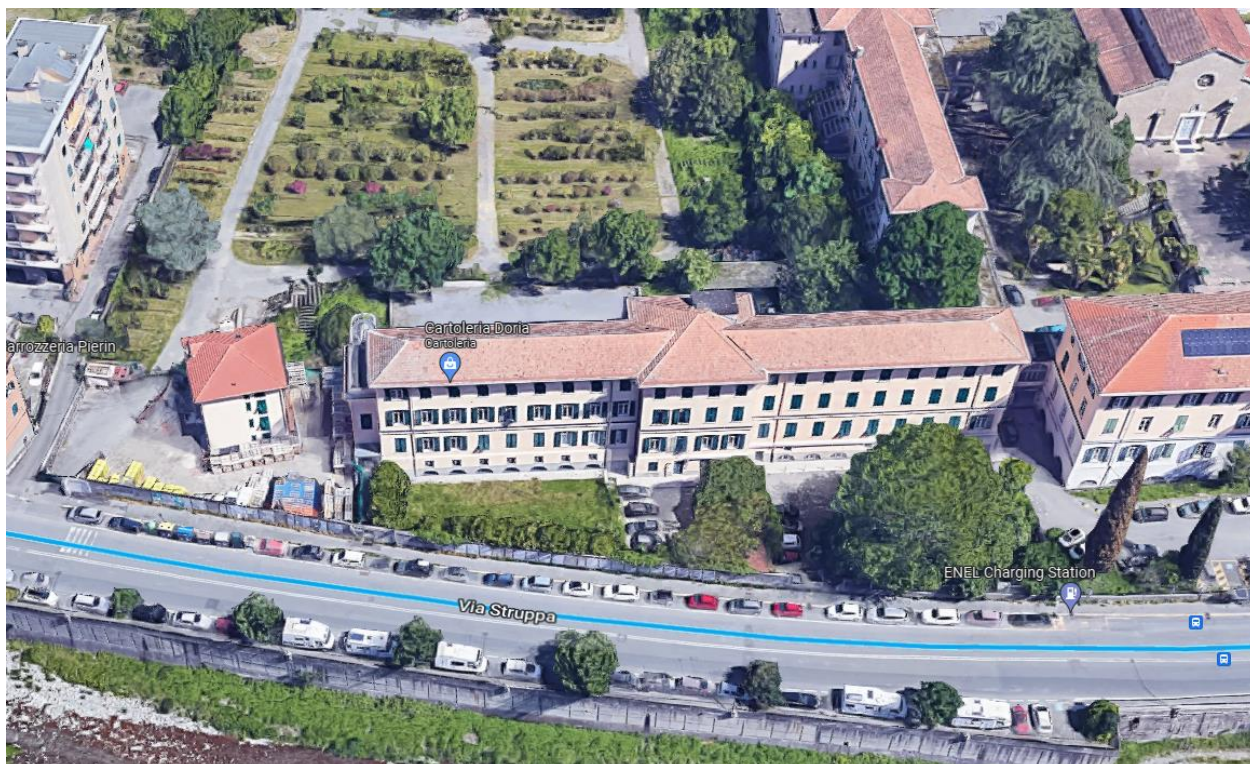
Foto 2 : Veduta aerea prospetto principale su via Struppa (google maps)
