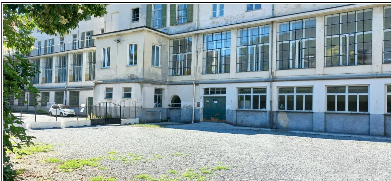
Foto 1: Area retrostante all'edificio scolastico, dove è prevista la realizzazione della nuova palestra
