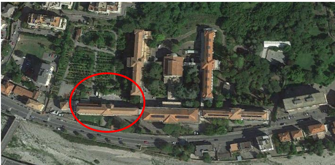
Fig. 6: Veduta zenitale con indicazione dell'edificio scolastico e parte retrostante verde
