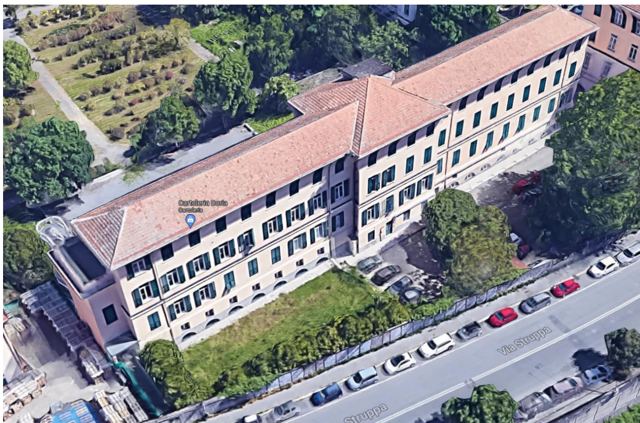
Foto 4 : Veduta aerea dettaglio prospetto principale (google maps)
