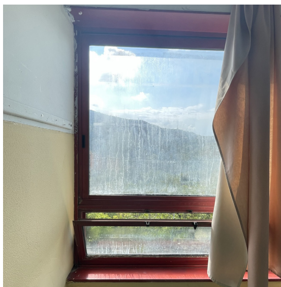
Serramento in ferro
