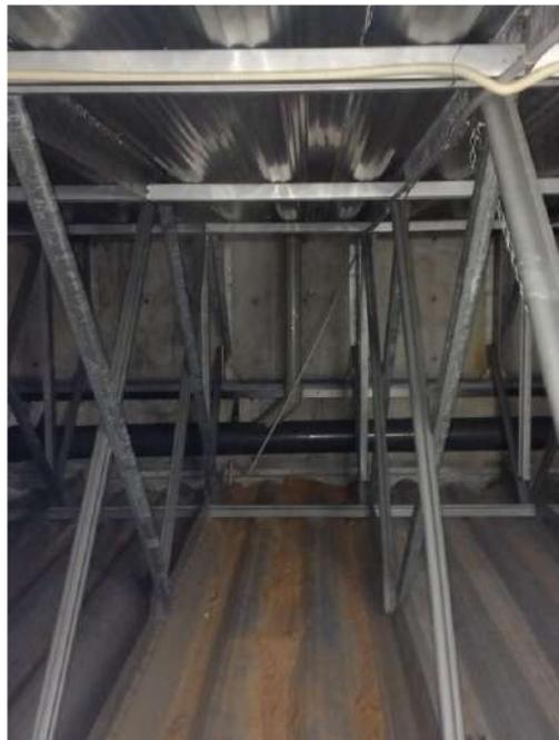
Fig. 6 – Vista della struttura della copertura palestra con le travi reticolari di grande luce Maxicover dubl-panel della Ipisistem
