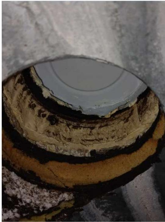
Fig. 7 – Vista di uno dei sondaggi eseguiti sulla copertura per definire la stratigrafia presente
