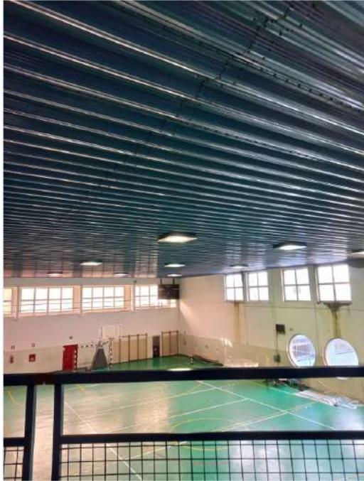
Fig. 5 – Vista del soffitto della palestra con la lamiera grecata intradossale
