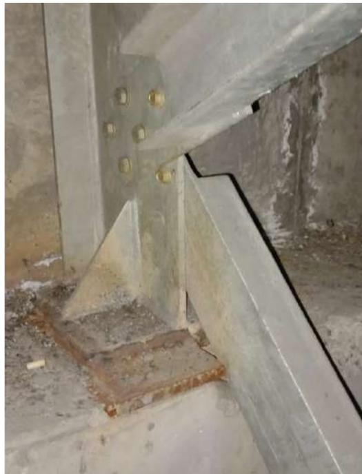
Fig. 8 – Vista dell'appoggio delle travi reticolari di copertura sui muri perimetrali
