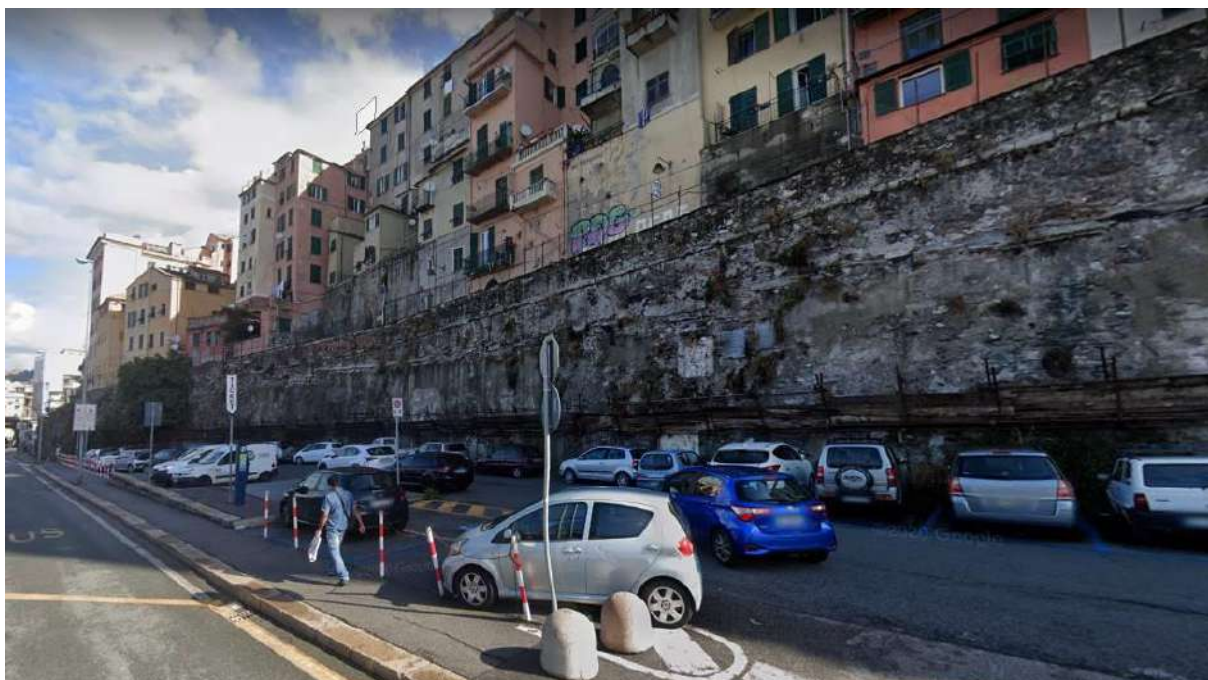
Foto 1 – vista delle mura nell’area parcheggio di Corso Quadrio
