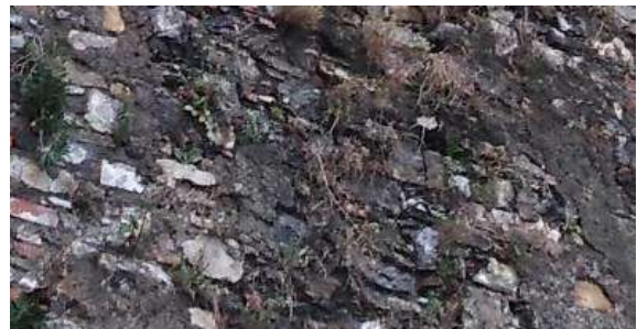
erosione giunti
