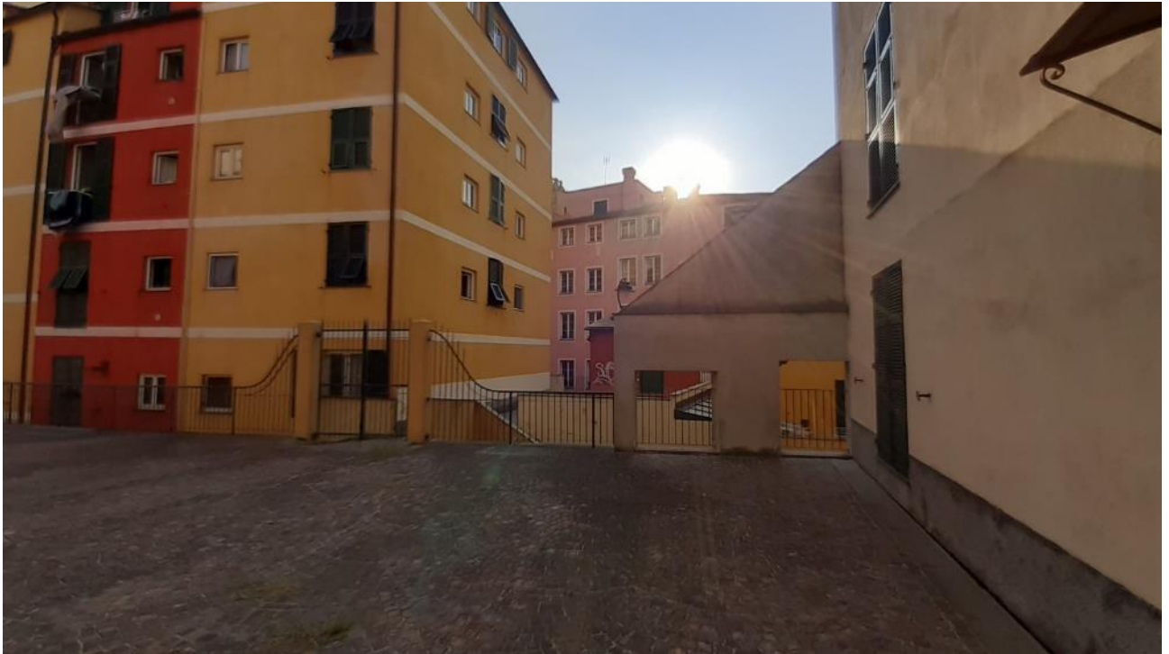
Piazza delle Monachette – vista sul cancello del passaggio su piazza delle Marinelle
