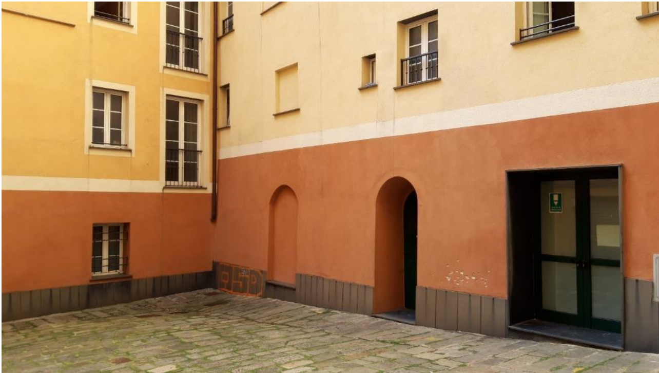
Piazza Tenedo – vista lato ovest
