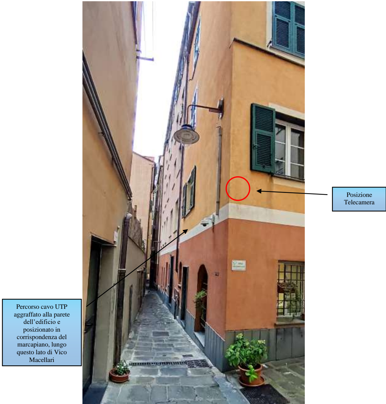
Figura 25 – Posizione Telecamera in Piazza Tenedo e percorso cavo UTP in Vico Macellari
