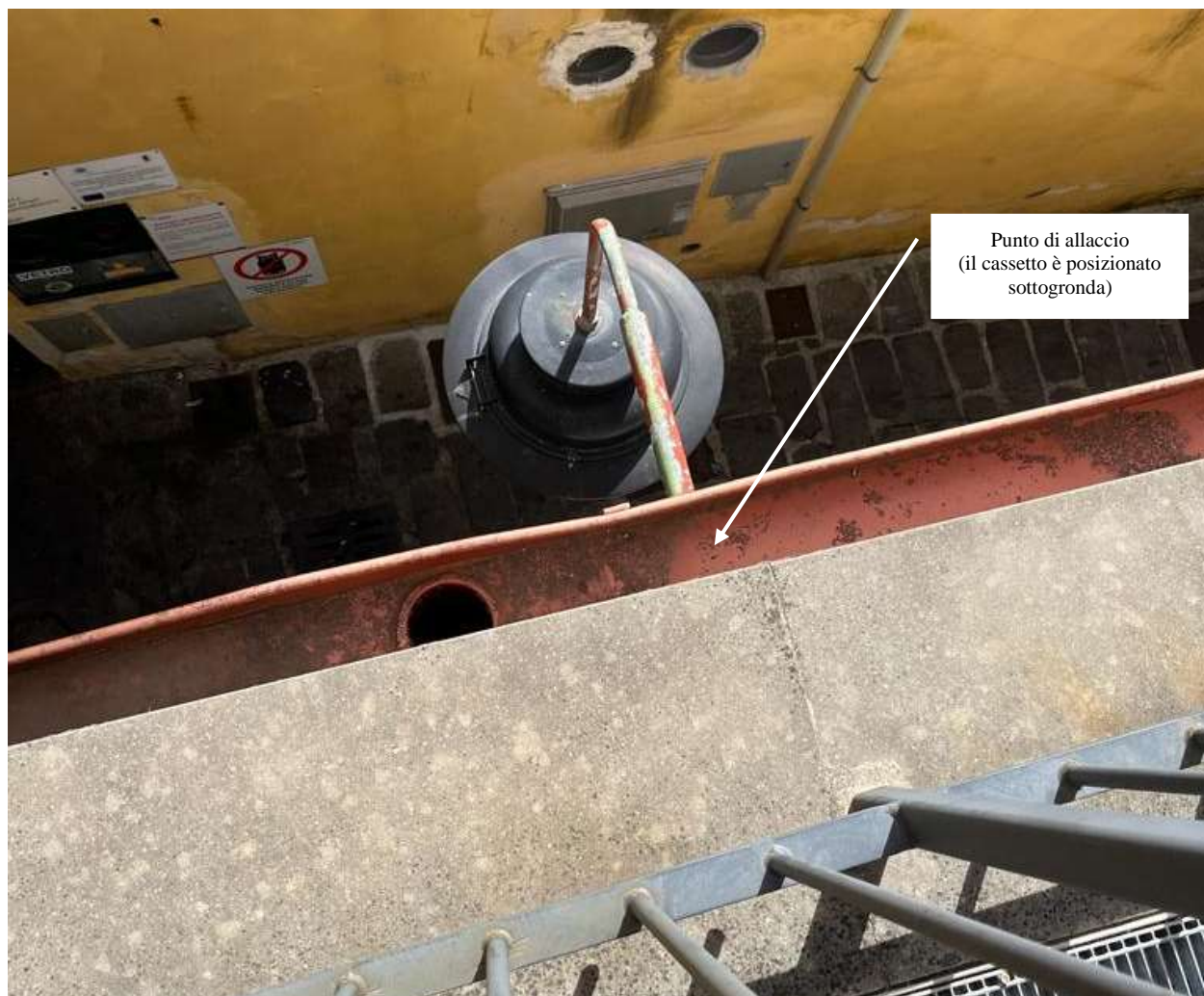
Figura 12 – Punto di allaccio da c.ill. esistente in Vico Tacconi
