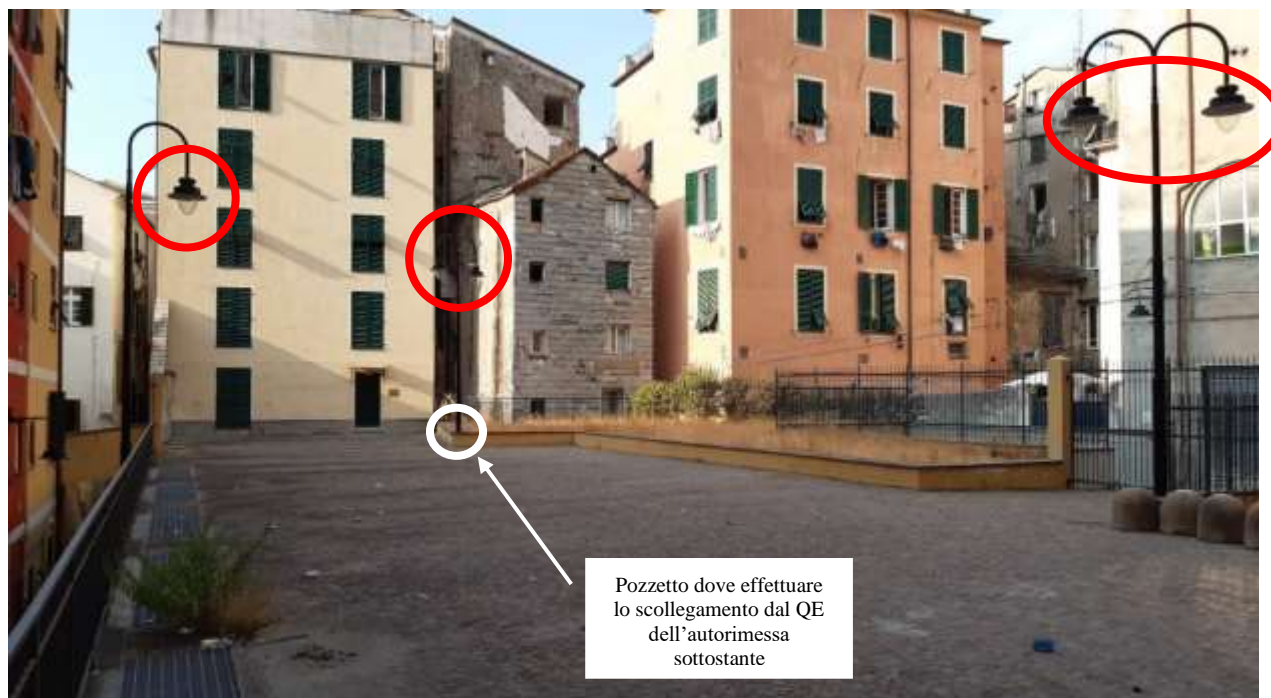
Figura 10 – Piazza delle Monachette – corpi illuminanti da sostituire e punto di scollegamento dall'attuale impianto collegato all' autorimessa
