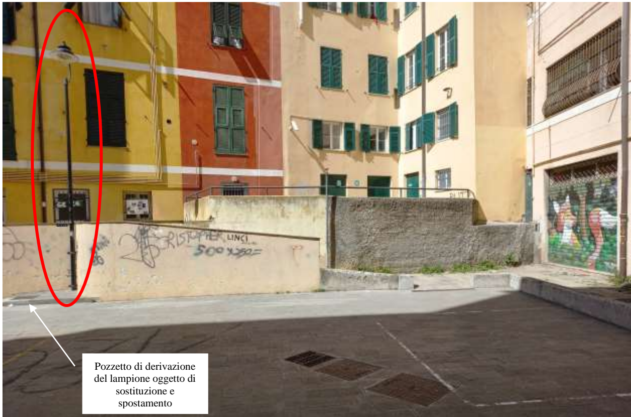
Figura 2 – Palo IP da sostituire e spostare per realizzazione della nuova scalea
