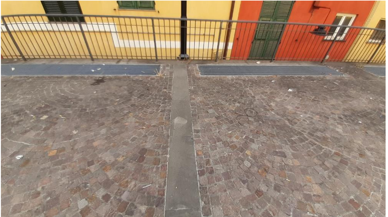
Piazza delle Monachette – vista della pavimentazione in sampietrini disposti a ventaglio
