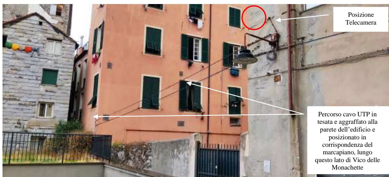
Figura 26 – Posizione Telecamera in Piazza delle Monachette e percorso cavo UTP in Vico delle Monachette
