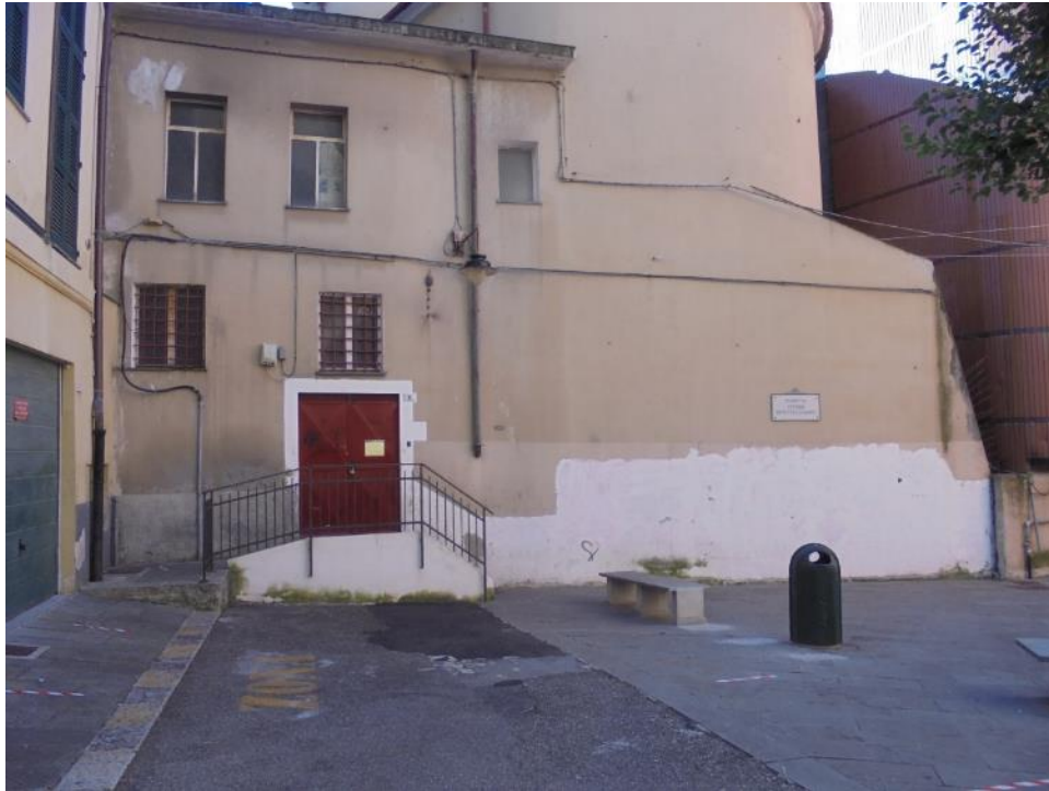
Vico Nuovo – sbocco su Piazza Vittime di tutte le mafie
