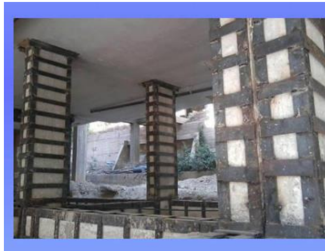
Figura 32. Esempio di calastrellatura per pilastri
