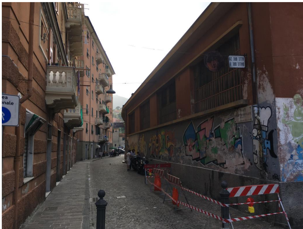
FOTO 5- Vista del prospetto Sud sull'area pedonale di via Castiglione
