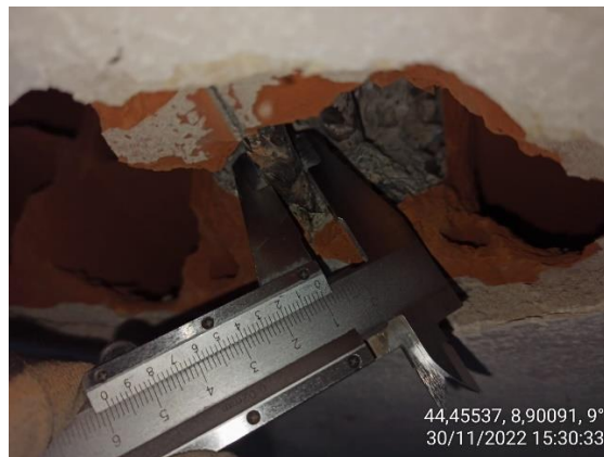
Figura 25. Misurazioni eseguite sul solaio della copertura
