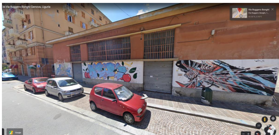
Fig. 8: Veduta dell'ingresso del mercato da via Bonghi
