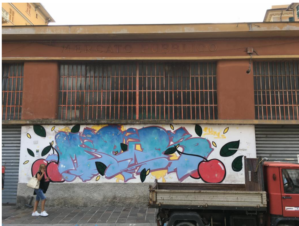
FOTO 4 – prospetto principale su via Bonghi
