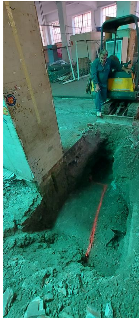
Figura 33 Saggio plinto di fondazione (foto scattate durante il saggio per verifica sistema di fondazione)
