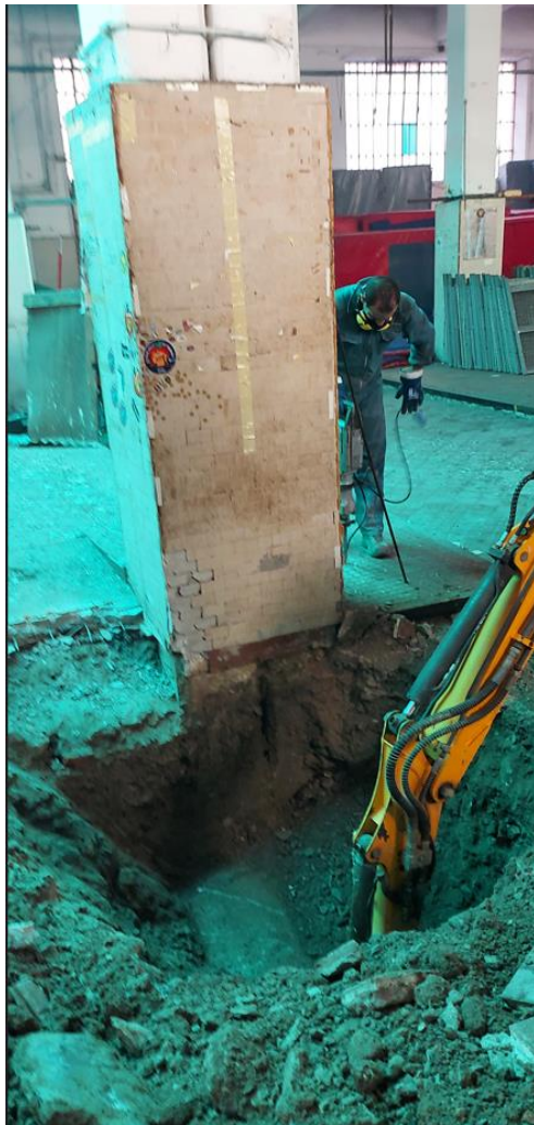
Figura 33 Saggio plinto di fondazione (foto scattate durante il saggio per verifica sistema di fondazione)
