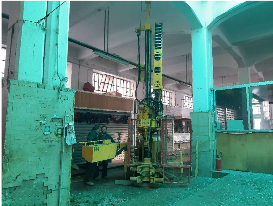
Postazione sondaggio S1
