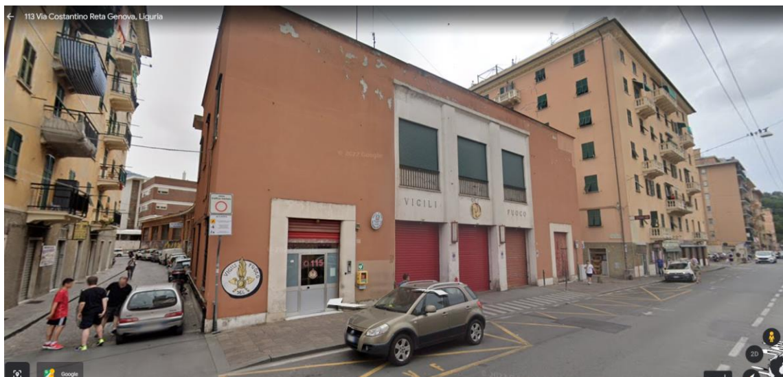
Fig. 10: Vista della caserma dei Vigili del Fuoco da via Costantino Reta
